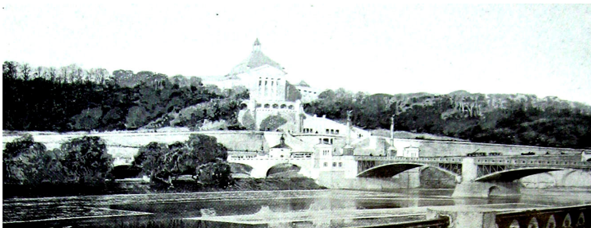
Obr. 160: A. Balšánek: Návrh na umístění budovy techniky na Letné. Zdroj: Architektonický obzor . 1915, roč. XIV., s. 53
