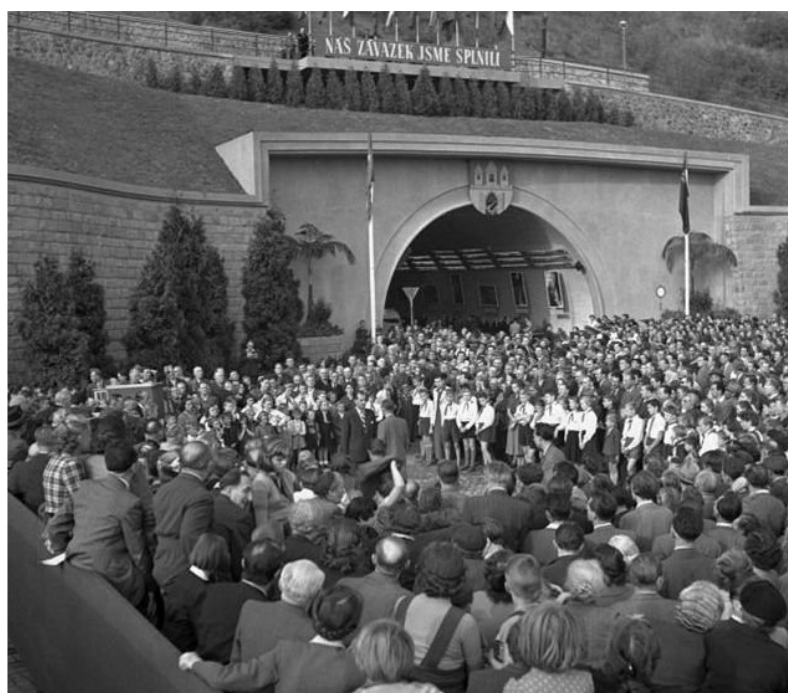
Obr. 162: Otevření Letenského tunelu v ose Štefánikova mostu v roce 1953. Zdroj: ČTK
