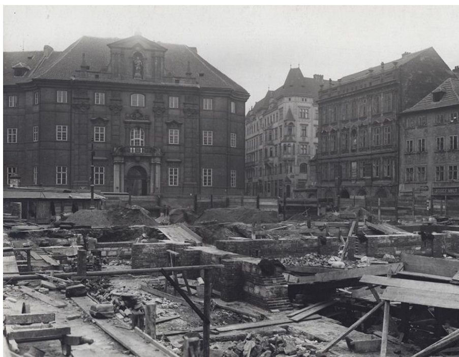
Obr. 210: Staveniště nové budovy radnice. Zdroj: http://praha.idnes.cz/
