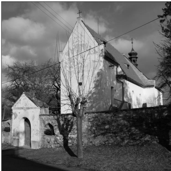
Obr. XCI: Třebonín (okr. Kutná Hora) a obr. XCII: Vysoký Újezd nad Dědinou (okr. Hradec Králové) Stávající objemová figura kostela sv. Matouše s věží ukončenou v pozici poloviny štítu lodi (řešení z počátku 19. století; románské zdivo věže končí v úrovni korunní římsy lodi) a předpokládaná konečná románská podoba kostela sv. Jakuba Většího (foto M. Falta, 2013; model M. Falta, 2012).
