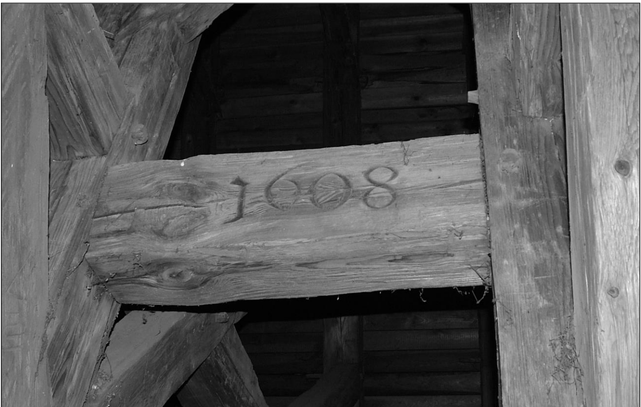
Obr. 11: Libčany (okr. Hradec Králové), kostel Nanebevzetí Panny Marie. Rytý letopočet datující konstrukci krovu (foto M. Falta 2006).
