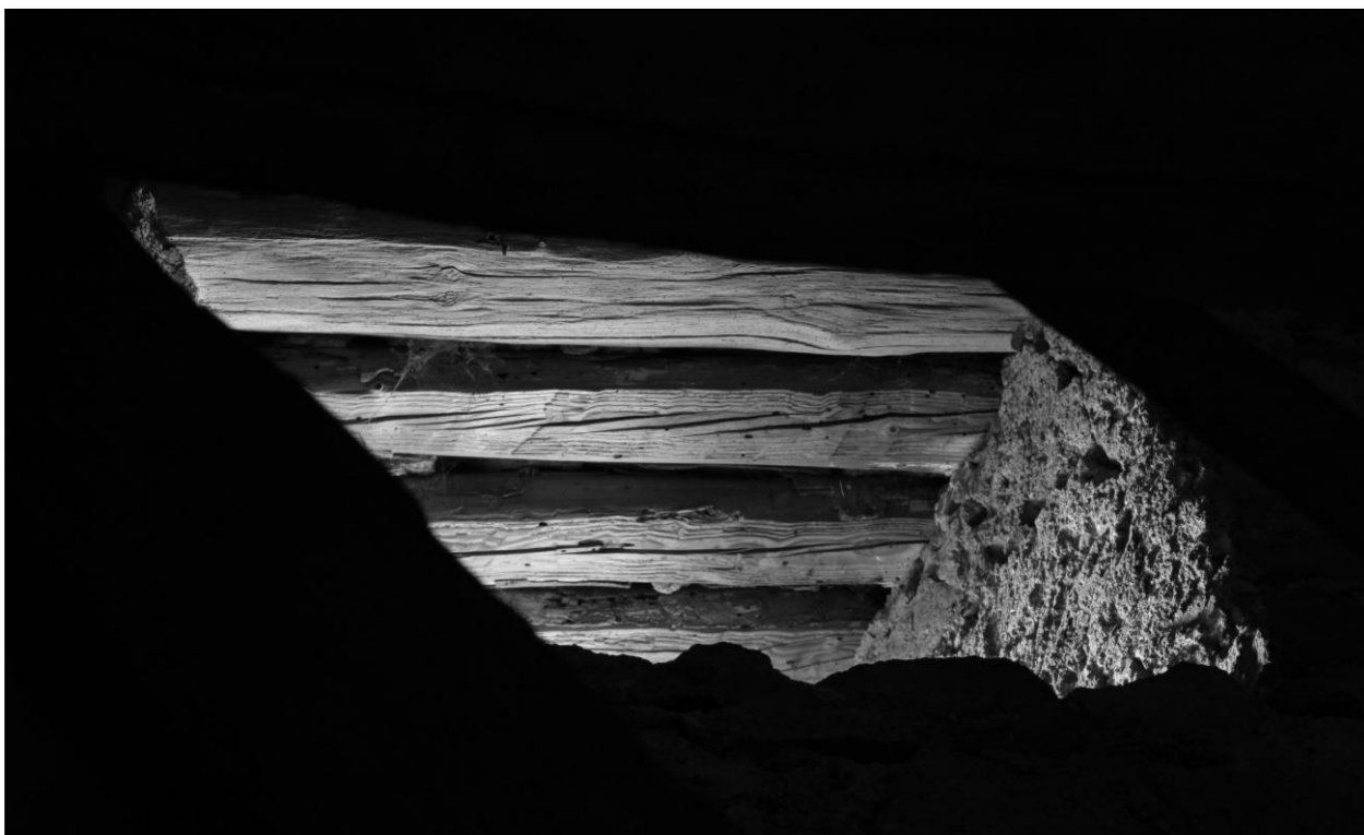
Obr. 110: Kozojedy (okr. Praha – východ), kostel sv. Martina.
