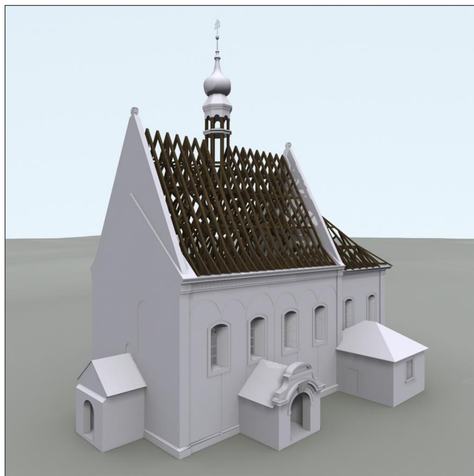
Obr. XXXII a XXXIII: Libčany (okr. Hrade Králové), kostel Narození P. Marie. současný stav objektu s vyznačenými renesa- nčním krovem nad lodí a barokním nad chórem (model M. Falta 2015).
