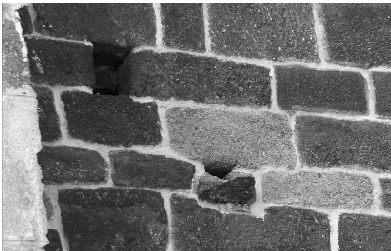
Obr. 19: Svojšíň (okr. Tachov), kostel sv. Petra a Pavla. Detail severní románské stěny věže s vyústěním výlevky vedoucí z úrovně rubu klenby nad tribunou a kapsou po nosné části lešení. Kvádrování na mladší severní zdi lodi zhotovené z lomového materiálu je pouze naznačeno rytím v omítce (foto M. Falta 2008).
