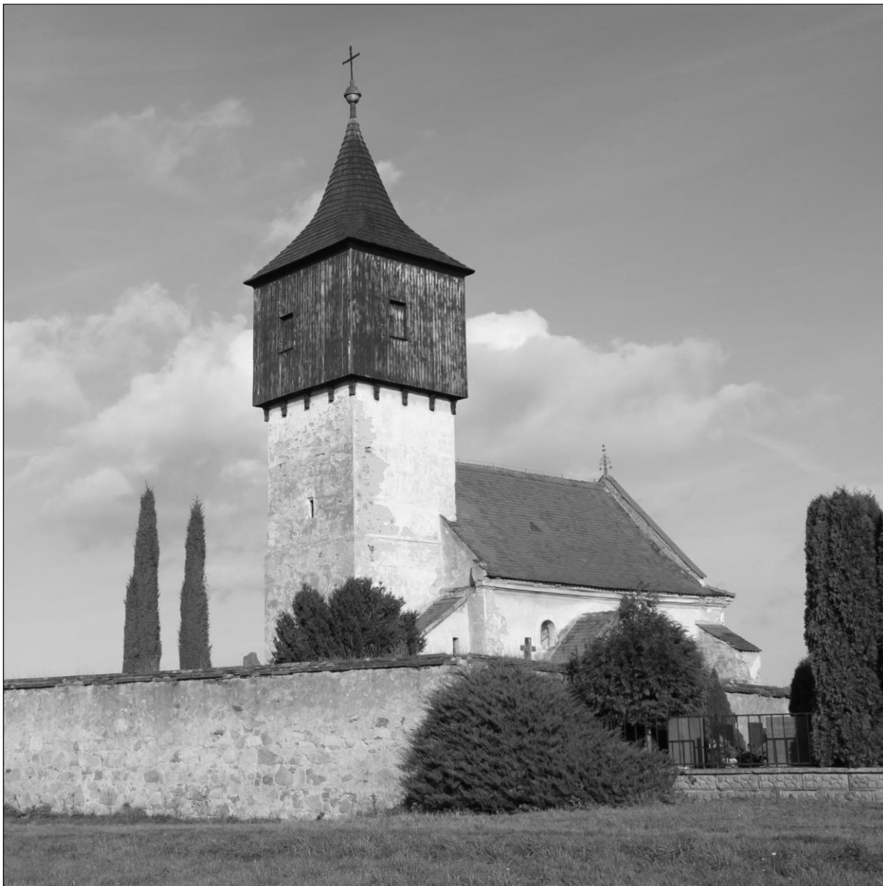
Obr. 106: Kozojedy (okr. Praha – východ), kostel sv. Martina.
