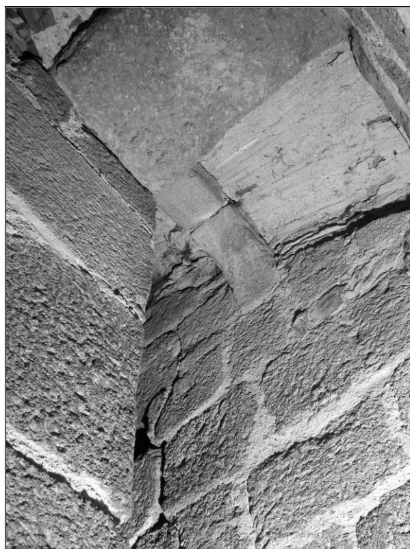
Obr. 26 (vlevo): Svojšín (okr. Tachov), kostel sv. Petra a Pavla. zastropení horní podesty schodiště kamennými deskami jednostranně vetknutými (foto M. Falta 2008).
