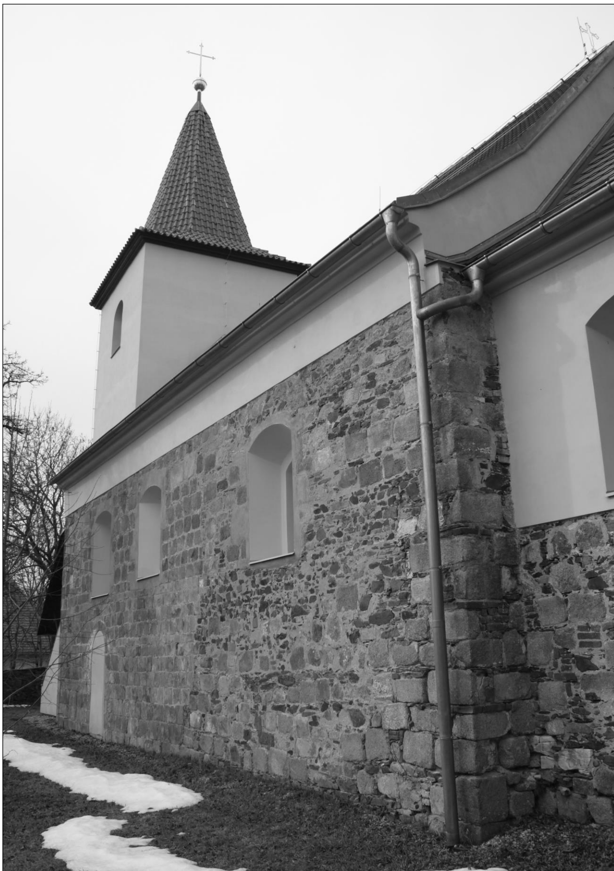
Obr. 78: Olešky (okr. Praha – východ), kostel Narození Panny Marie. Celkový pohled na kostel od jihovýchodu (foto M. Falta 2016).
