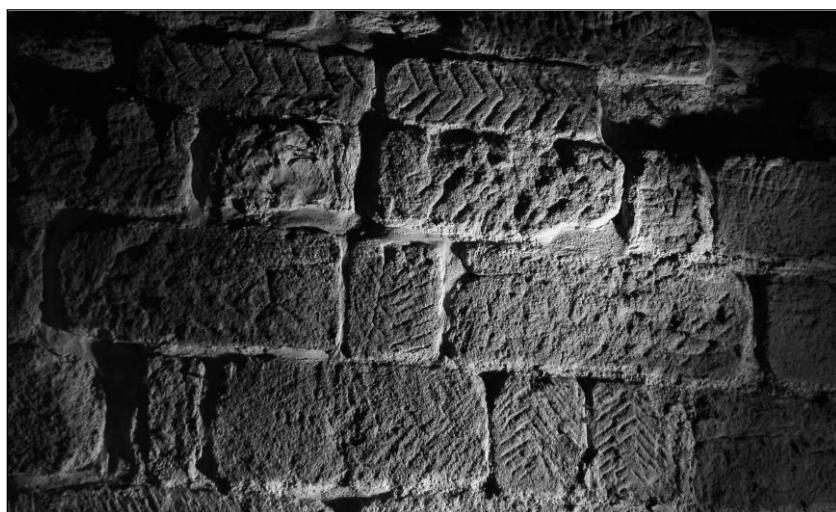
Obr. 37: Plaňany (okr. Kolín), kostel Zvěstování Panny Marie Zdivo v interiéru věže s dekorem ve formě opus spicatum ve vodo-rovném i svislém směru (foto M. Falta 2008).
