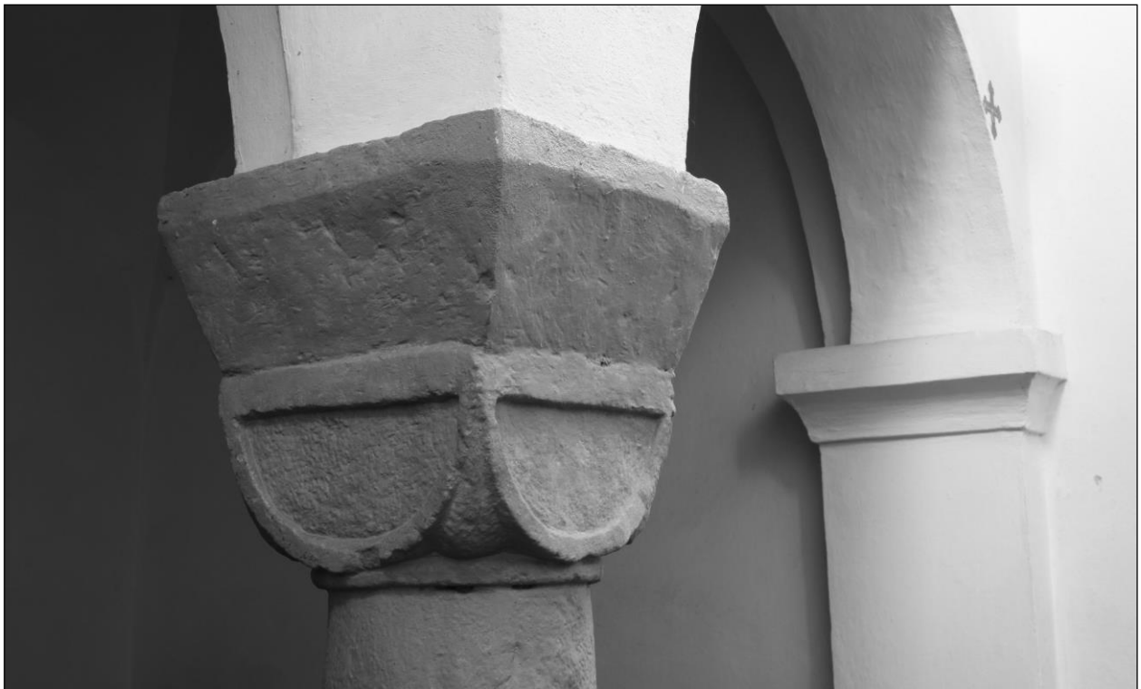
Obr. 74: Vysoký Újezd nad Dědinou (okr. Hradec Králové), kostel sv. Jakuba Většího. Krychlová hlavice nesoucí arkády empory (foto M. Falta 2011).
