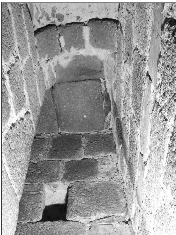
Obr. 26 (vlevo): Svojšín (okr. Tachov), kostel sv. Petra a Pavla. zastropení horní podesty schodiště kamennými deskami jednostranně vetknutými (foto M. Falta 2008).
