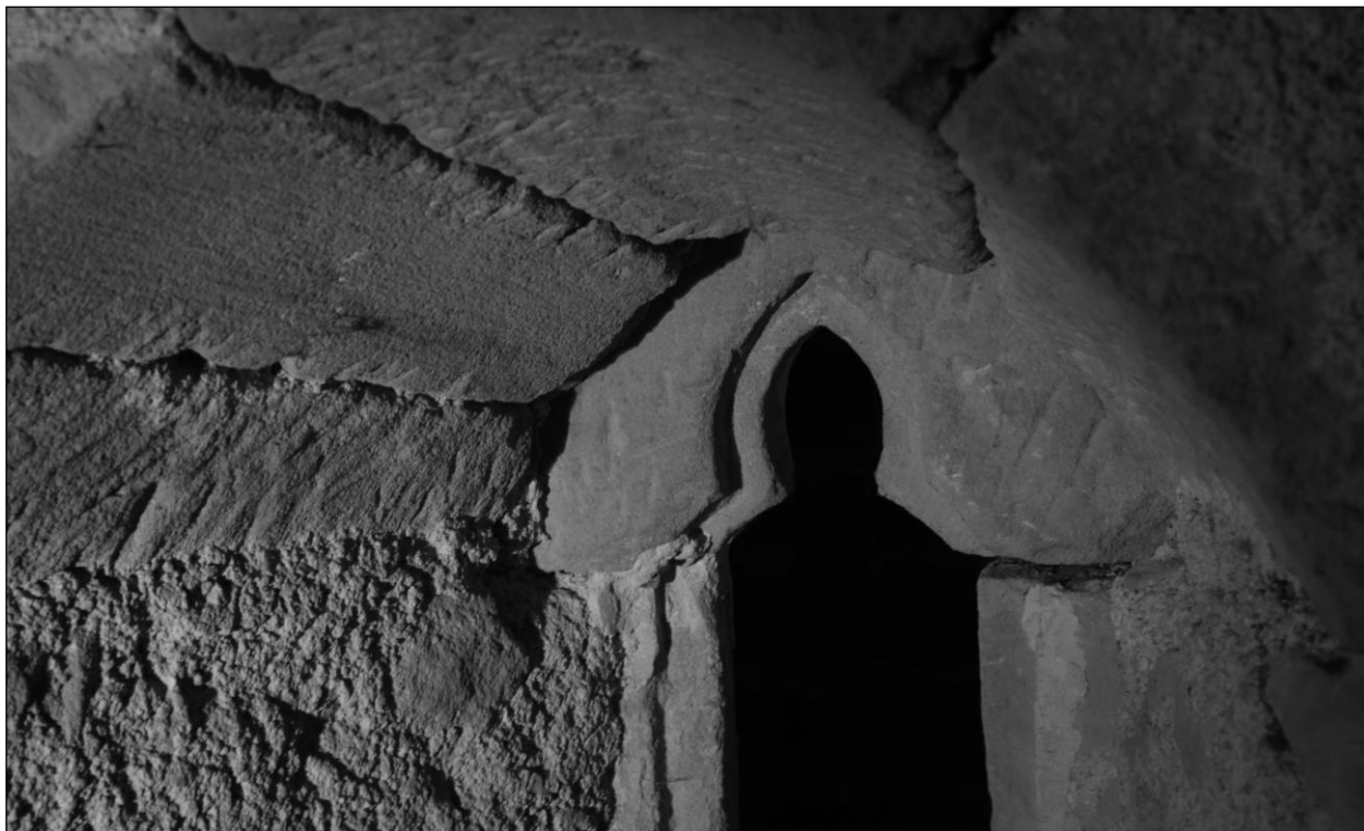
Obr. 113: Kozojedy (okr. Praha – východ), kostel sv. Martina.
