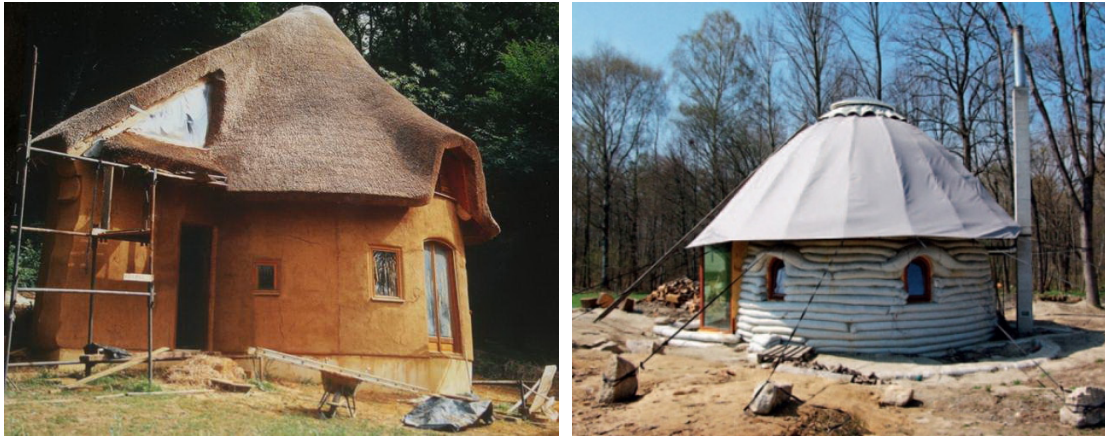
Obr. 2.1: „Ekologické stavby“ v ČR – hliněný dům a dům z pytlů www.baobaby.org/en/slamene-domy/ve-svete/ a bydleni.idnes.cz
