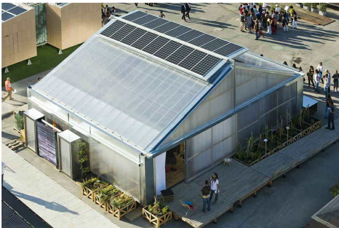
Obr. 6.16: (e)co House týmu ETSAV-UPC, pohled z ptačí perspektivy. Dobře viditelné jsou hřebenové větrací klapky s integrovanými fotovoltaickými panely, Madrid, 2012 – foto: (e)co Team, ETSAV-UPC, 2012
