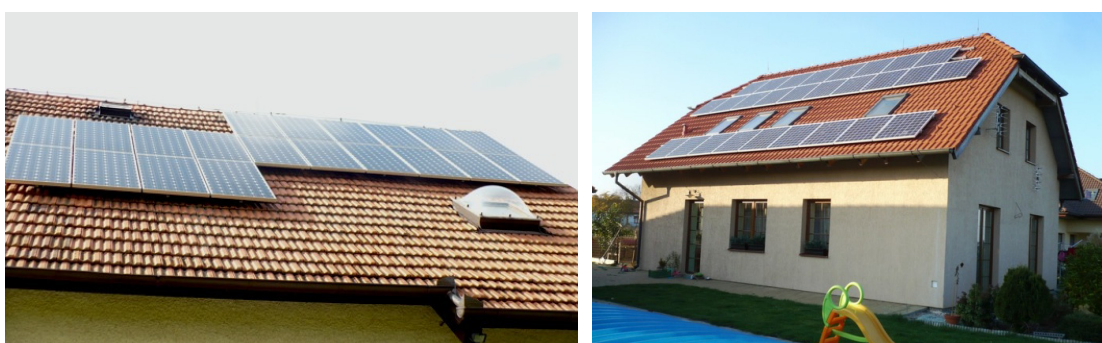
Obr. 3.17: Fotografie fotovoltaických panelů aplikovaných na střechu rodinného domu bez zvažování vlivu na výsledný výraz stavby – www.ekobydleni.eu a www.svp-solar.cz
