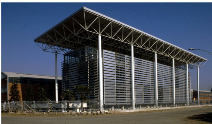
Obr. 4.38: Ottavio di Blasi, budova TAD, Milán-Lainate www.divisare.com
