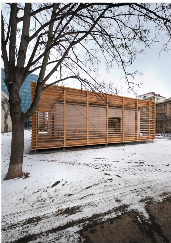
Obr. 4.6: AIR House, Informační centrum ČVUT, Dejvice (M.Č. 2014)
