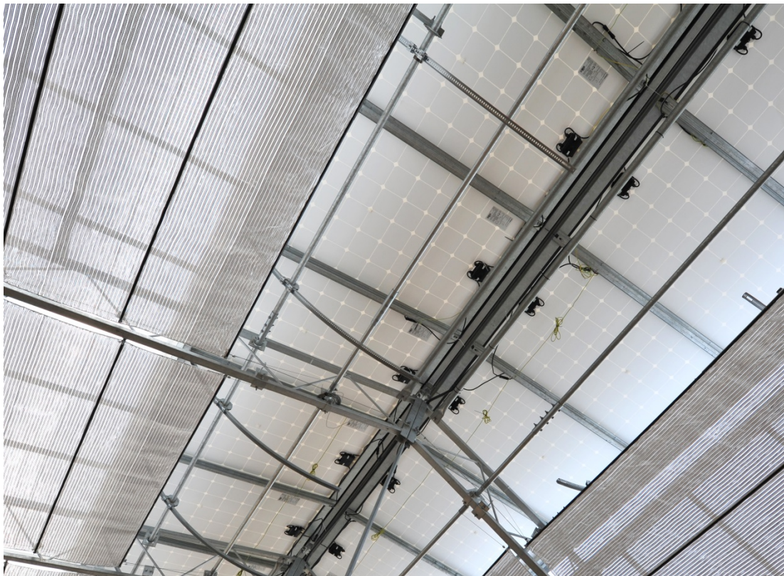
Obr. 6.21: (e)co House, detail větrací klapky v hřebeni a zatažených stínících rolet – foto: Martin Čeněk, 2012
