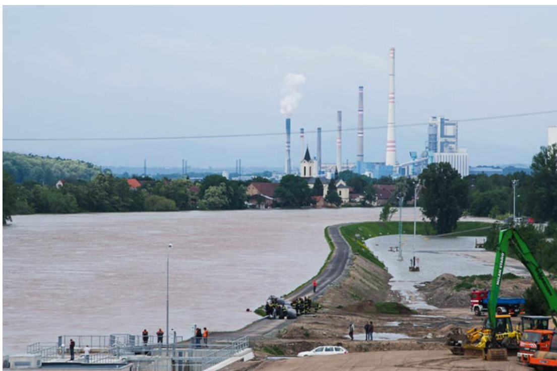
Pohled na protipovodňovou hráz z Nového mostu Mělník 2013, Foto: Daniel Poláček
