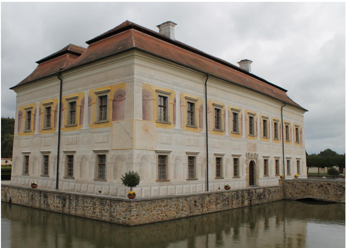
Fotografie 9 : Hlavní budova zámku z jihozápadu [NPÚ, vlastní]
