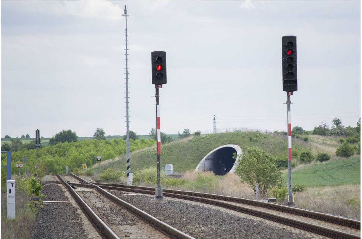
Obrázek A.13: Droužkovický portál tunelu s odjezdovými návěstidly
