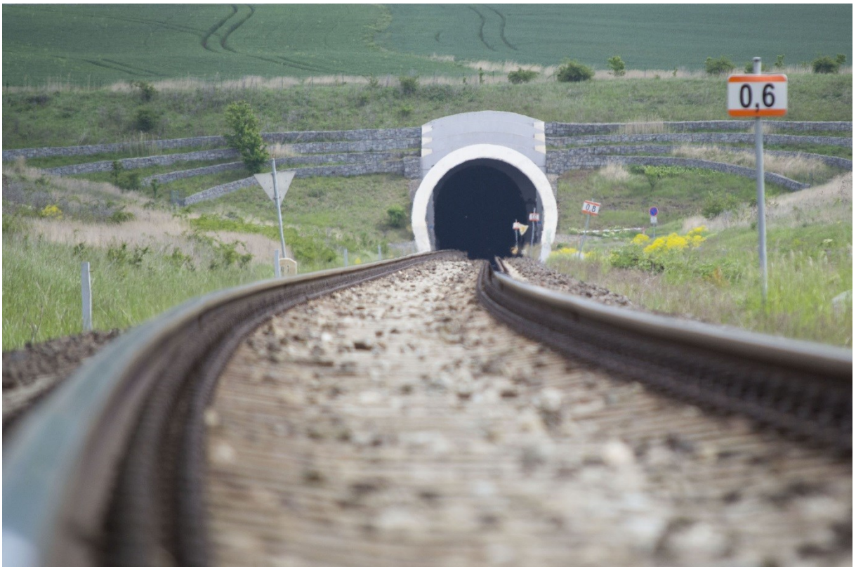
Obrázek A.12: Březenský portál nejdelšího jednokolejného tunelu v ČR
