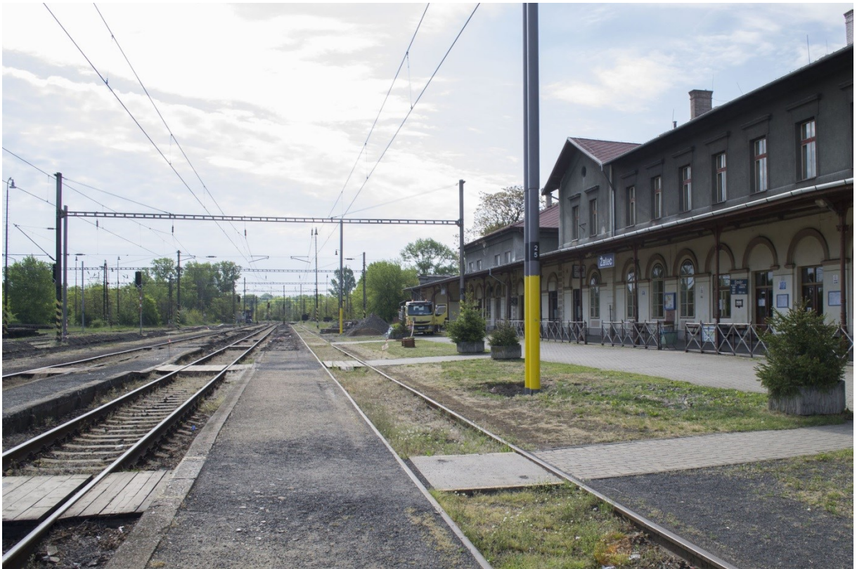
Obrázek A.1: Pohled na výpravní budovu stanice Žatec
