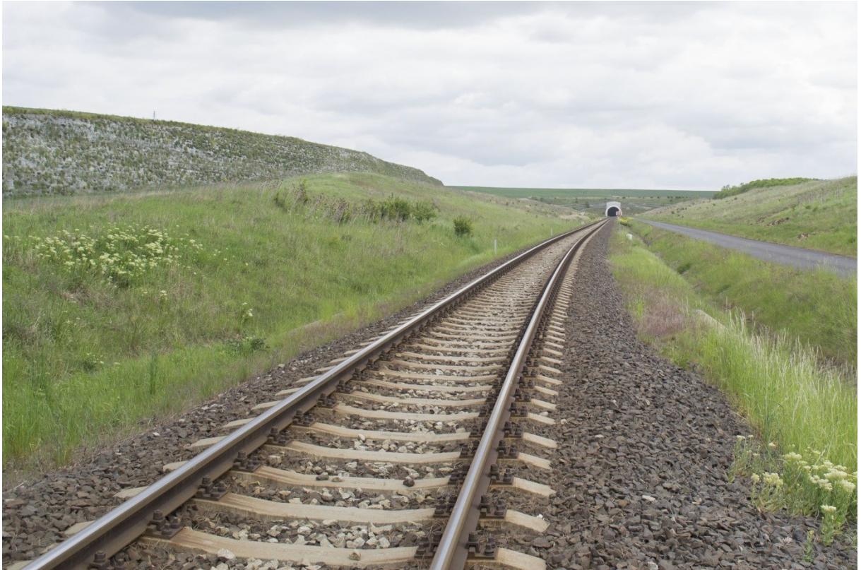
Obrázek A.11: Pohled na zářez trati před vstupem do tunelu
