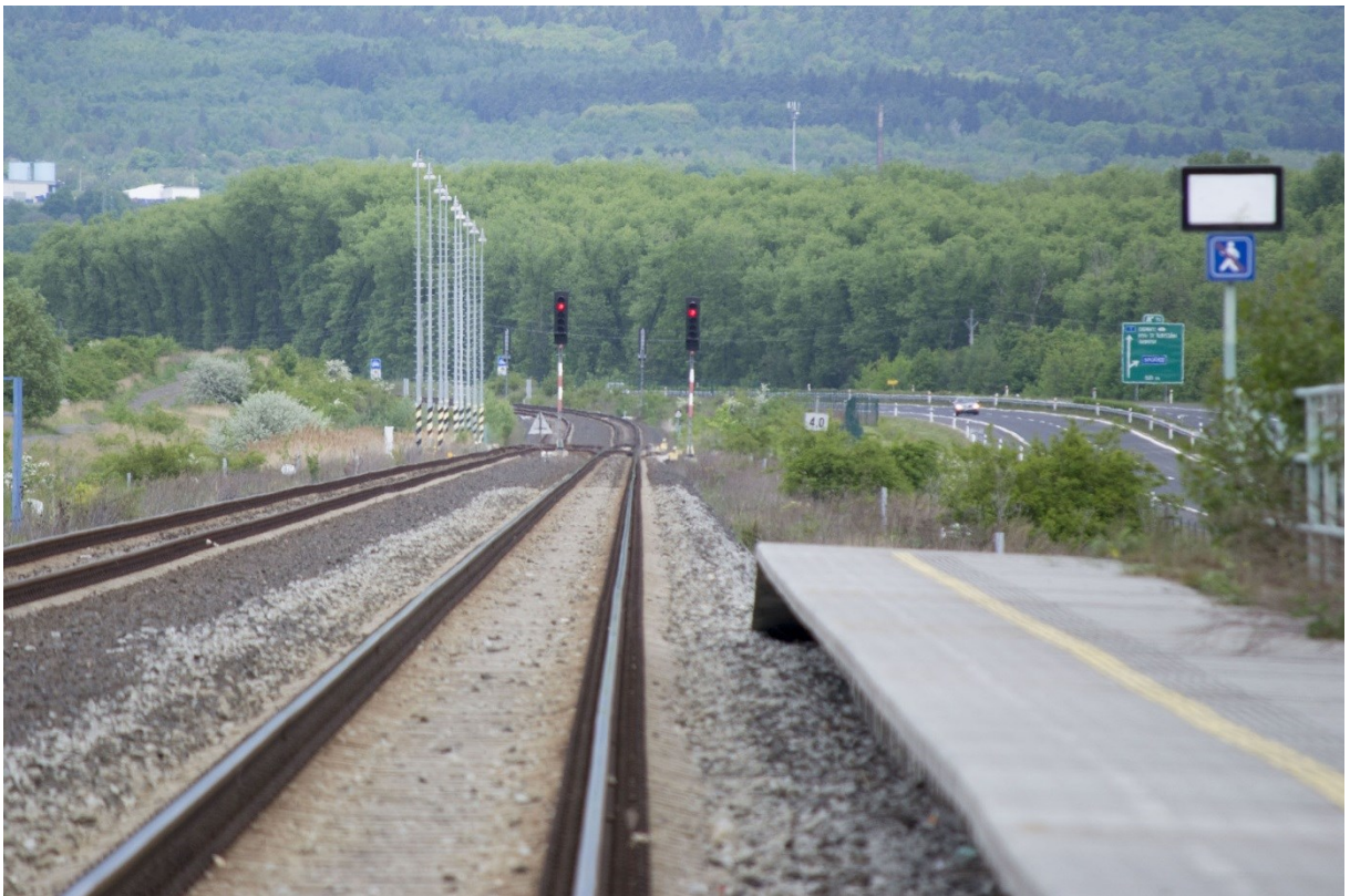
Obrázek A.14: Pohled na chomutovské zhlaví stanice Droužkovice
