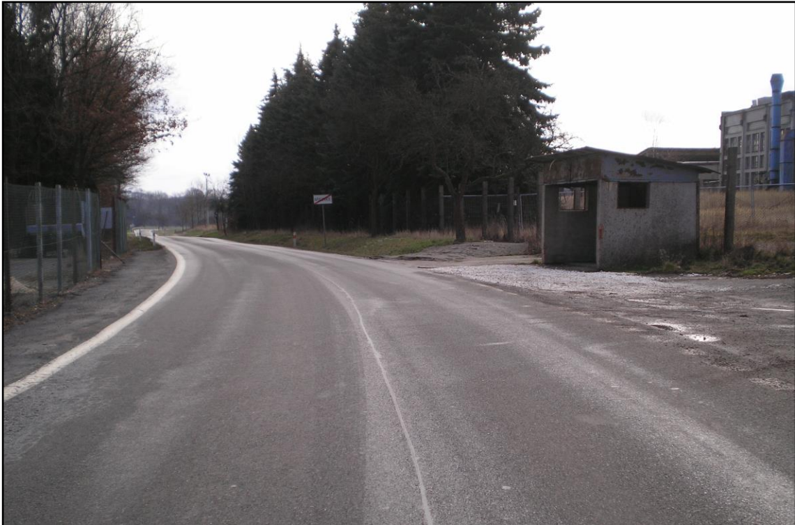
Obr. 8 Jižní výjezd z obce Březnice – pohled ze severozápadu
