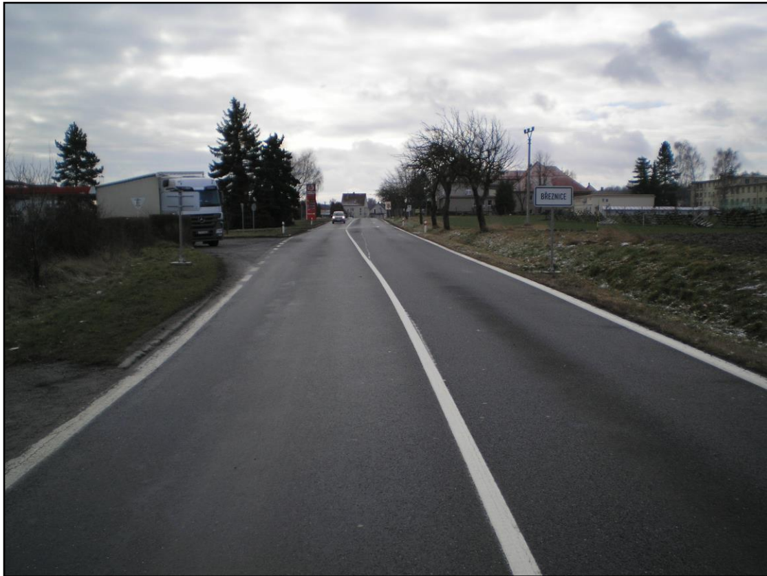
Obr. 1 Vjezd do obce Březnice, vlevo čerpací stanice – pohled ze severu
