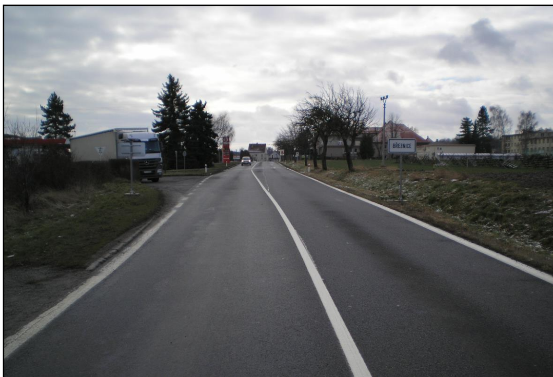
Obr. 2 Příčný úsek na vjezdu do obce Březnice – pohled ze severu
