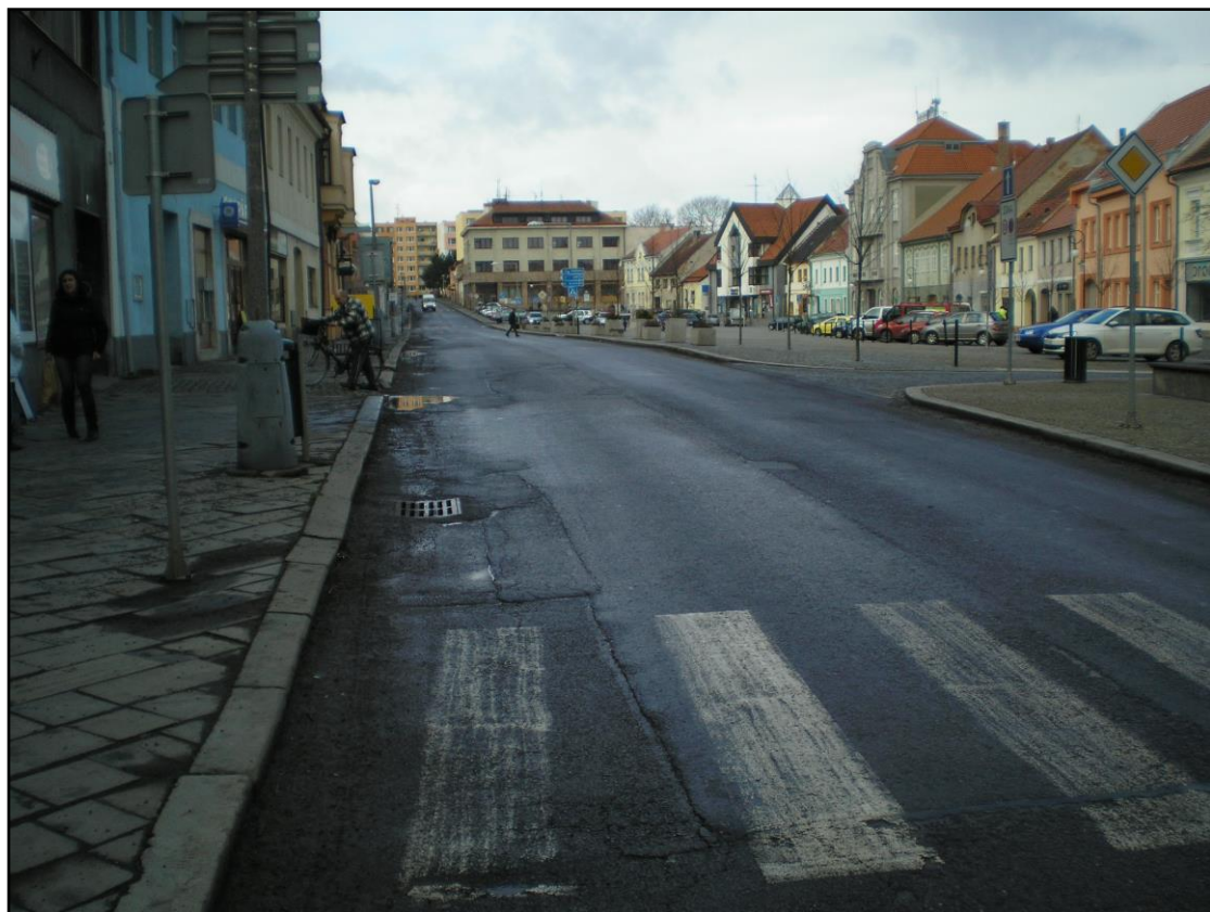
Obr. 6 Náměstí v obci Březnice – pohled z východu
