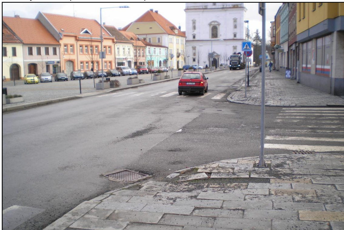
Obř. 6 Pohled na náměstí v místě napojení ulice Blatenská – pohled ze západu
