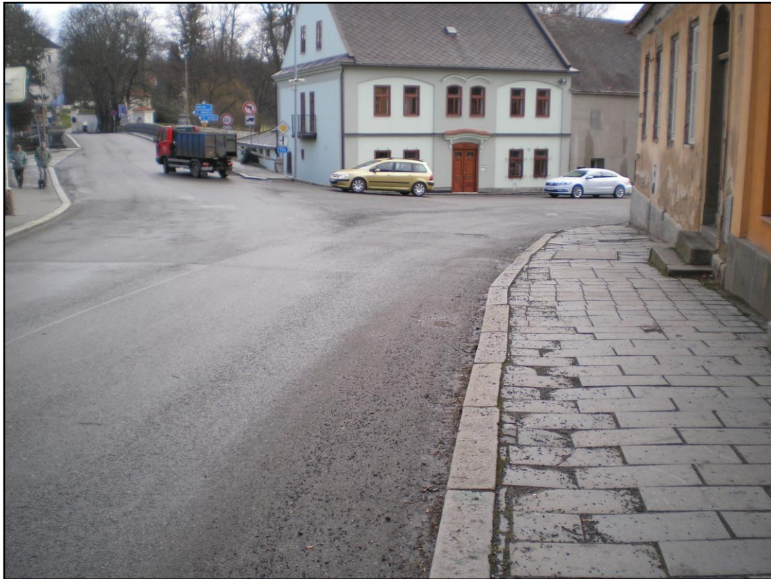
Obr. 7 Křižovatka I/19 a II/174 na začátku ulice Počapská – pohled ze západu
