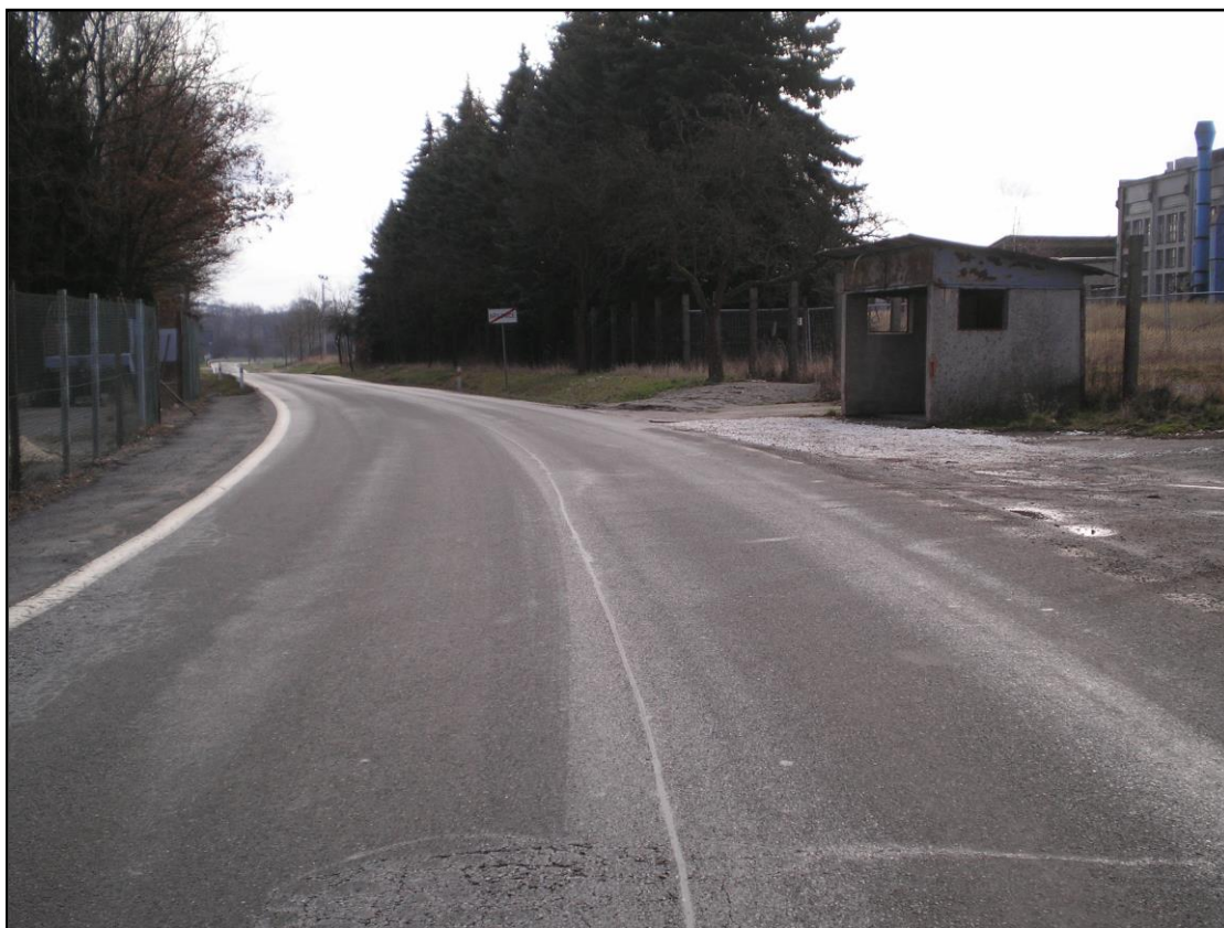
Obr. 14 Výjezd z obce, vpravo autobusová zastávka – pohled ze severozápadu
