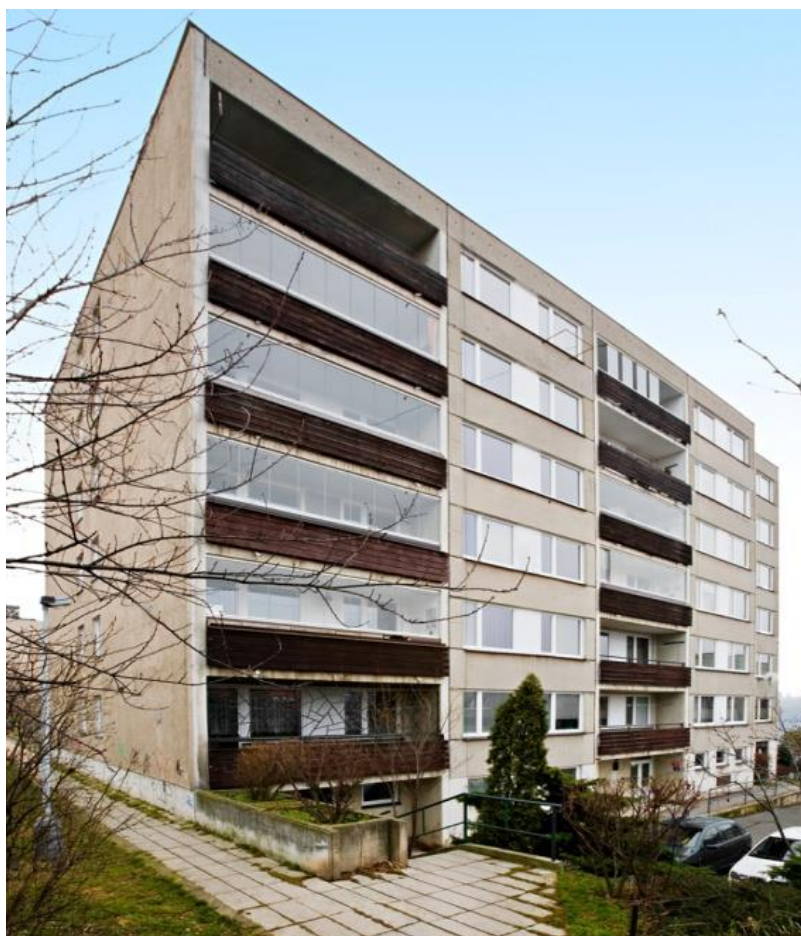
Obr. 2 Bytový dům v původním stavu
