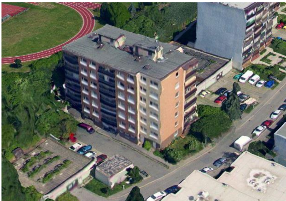
Obr. 1 Pohled na celkovou situaci řešeného bytového domu
