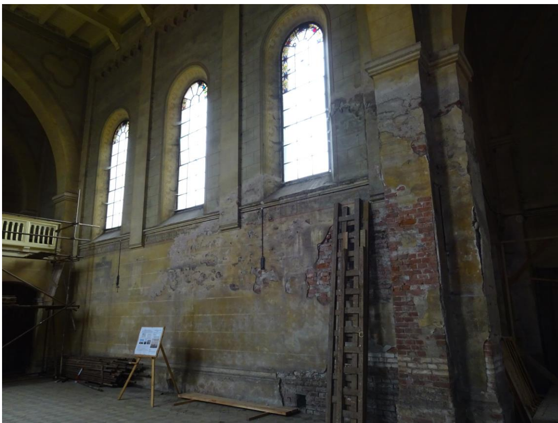
Fotografie 7: Pohled na severní stěnu lodě, interiér
