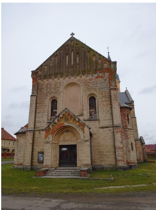
Obr. 3: Průčelí kostela postižené biodegradací Vlastní zpracování.
