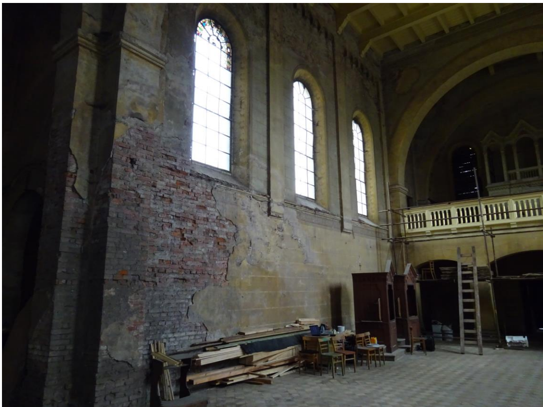
Fotografie 2: Pohled na spodní část jižní stěny lodě, interiér
