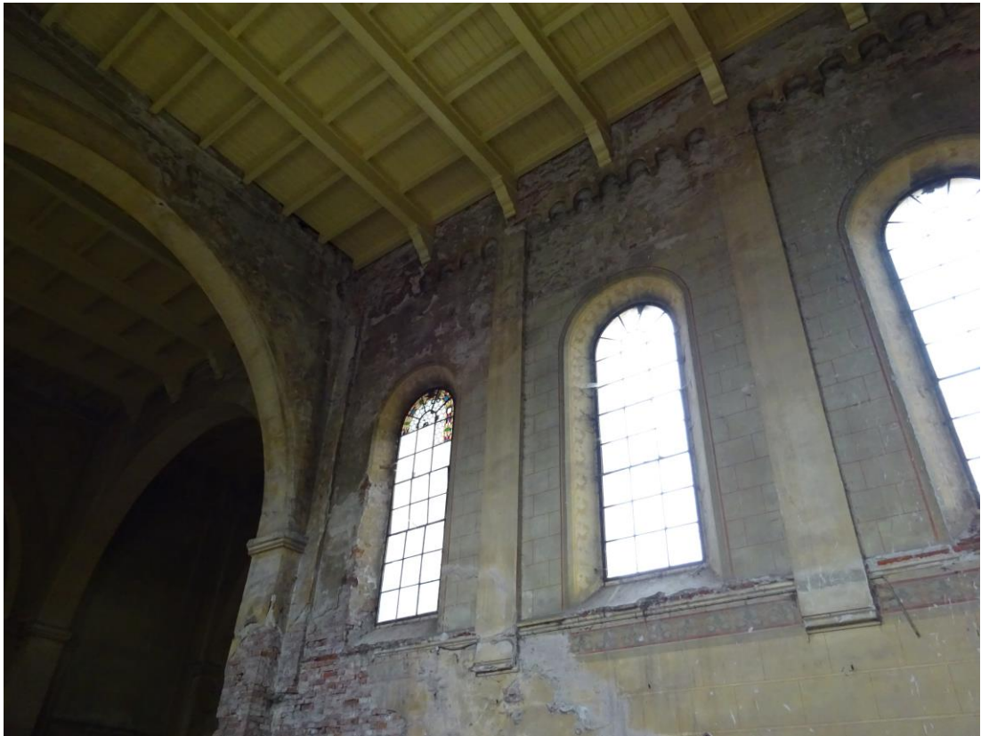
Fotografie 3: Pohled na horní část jižní stěny lodě, interiér
