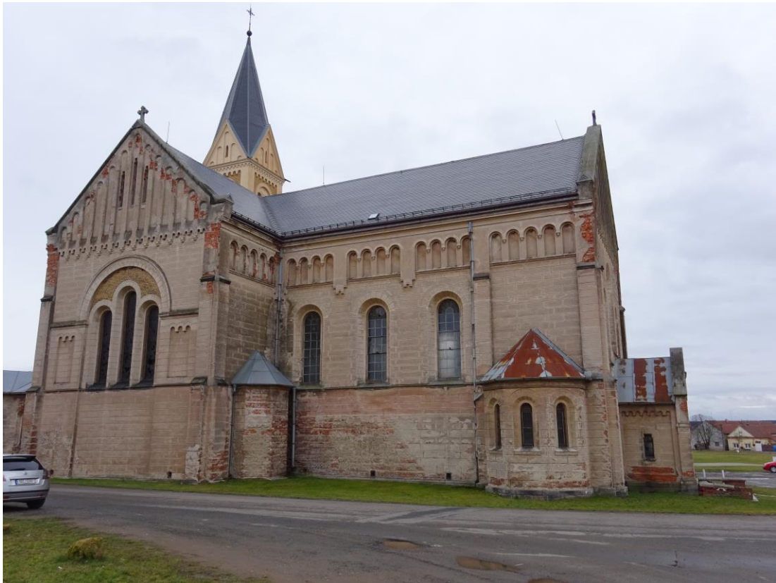
Fotografie 9: Severní pohled, exteriér
