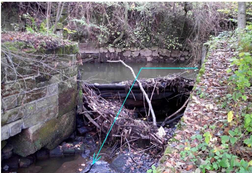
Obr. 4.5 - Pohled na kanál spojující derivační přivaděč s řekou (fotka č. 1)
