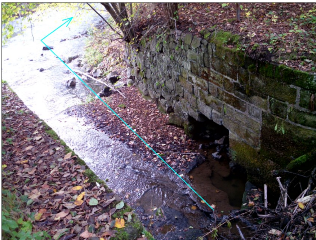
Obr. 4.6 - Pohled na kanál spojující derivační přivaděč s řekou (fotka č. 2)
