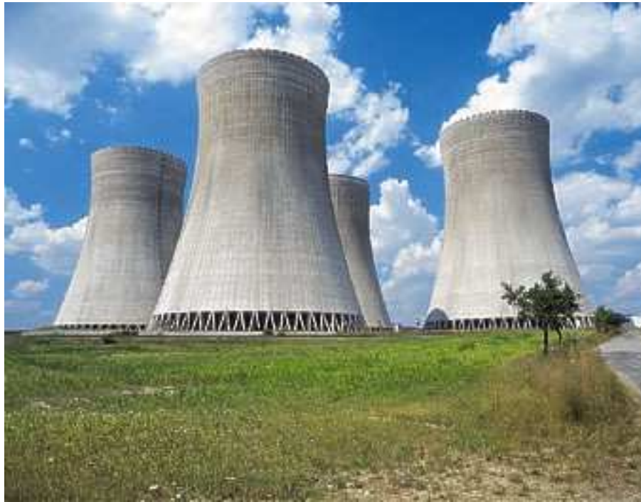
Obr. 4: Chladicí věž (směšovací výměník) [7]
