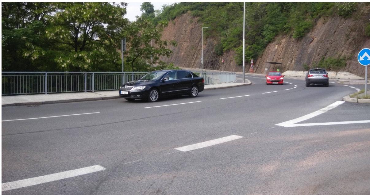
Obrázek 6.2: Fotografie z místa řidiče směrem na příjezd od Komořan
