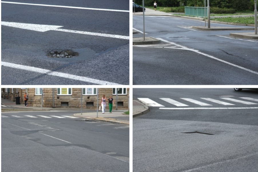
Ilustrace 19: Poškození vozovky
