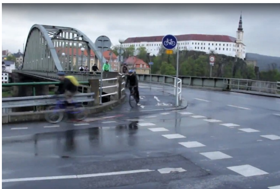
Ilustrace 3: Převedení cyklotrasy v rámci Tyršova mostu z pravého na levý břeh řeky Labe
