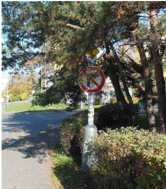
Obrázek 39: Zakryté SDZ za neupravenou zelení.
