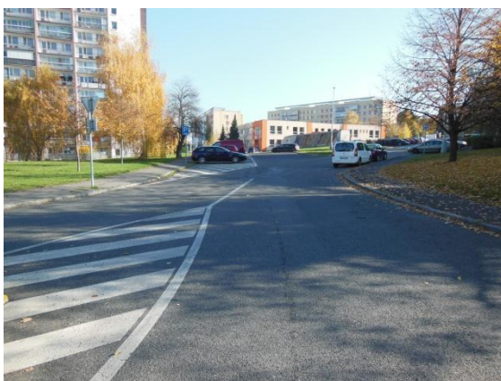
Obrázek 40: Rozlehlé dopravní stíny.
