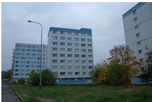
Obrázek 18: Areál kolejí Univerzity Karlovy.
