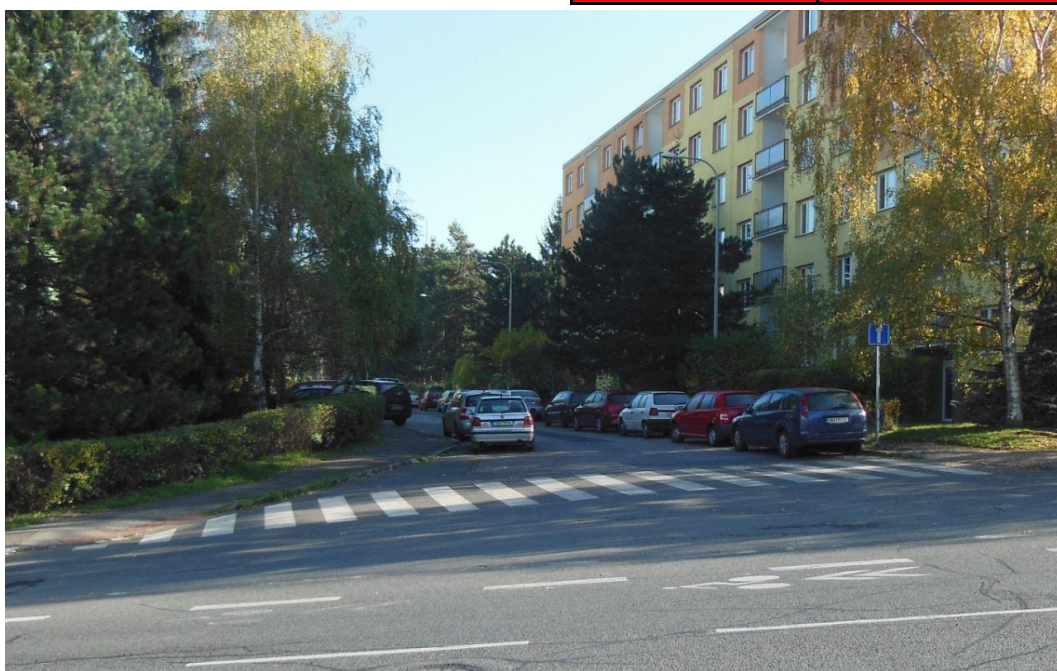
Obrázek 44: Příliš dlouhé přechody v řešené lokalitě.
