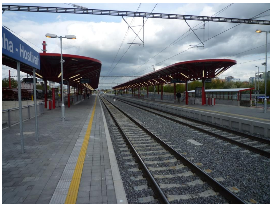
Obrázek 5: Modernizovaná železniční stanice Praha - Hostivař.
