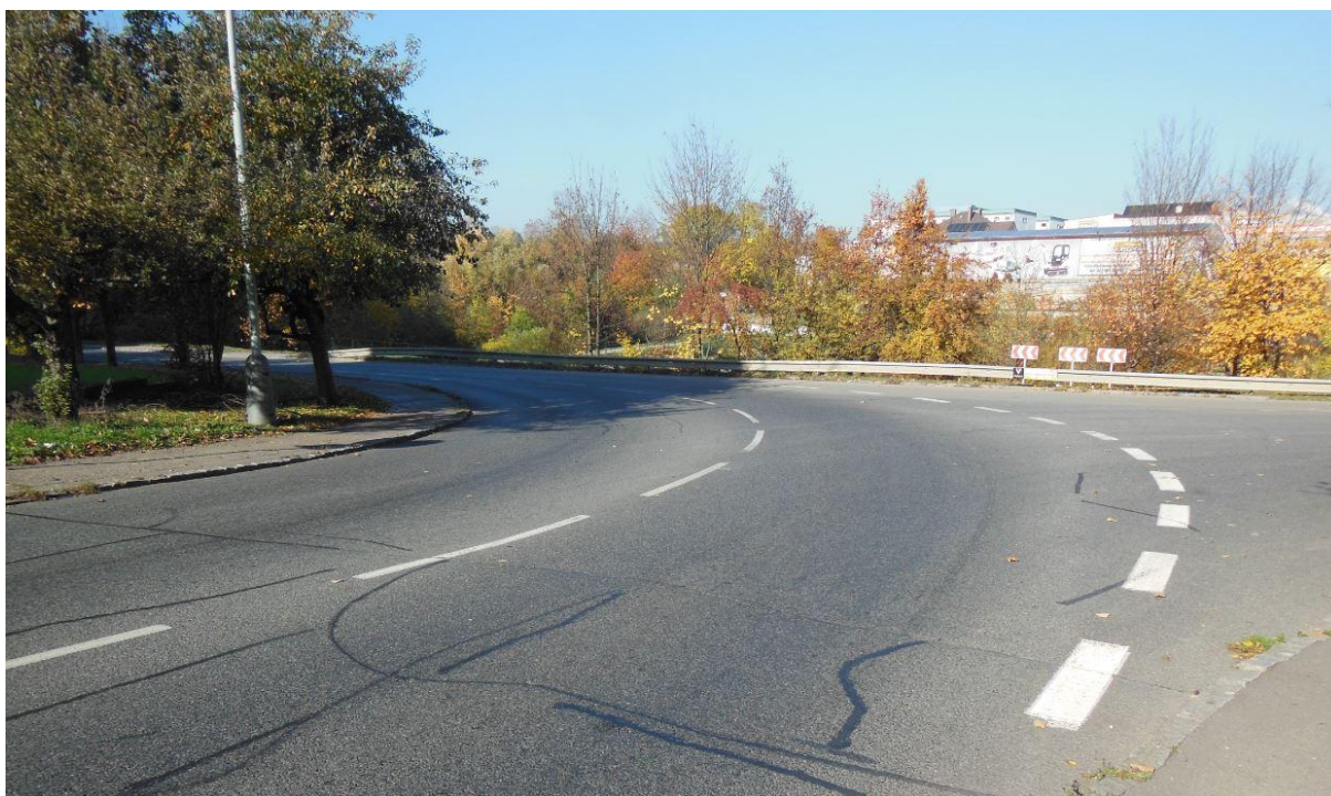
Obrázek 33: Prudký směrový oblouk se zelení na vnitřní straně.
