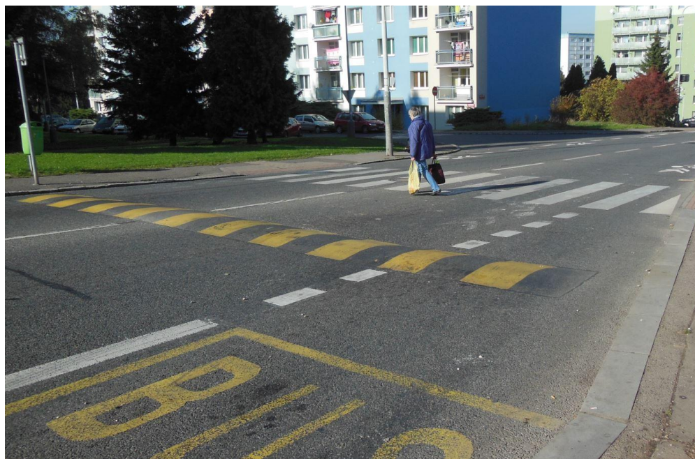
Obrázek 42: Aplikace krátkého prahu zabudovaného do vozovky.
