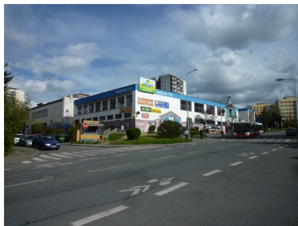
Obrázek 15: Celkový pohled na OC Taškent.
