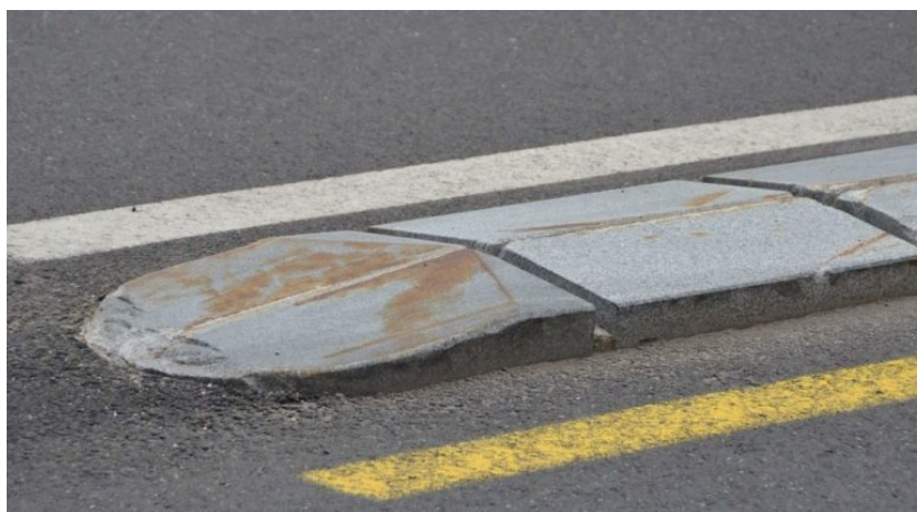
Obrázek 1.8: Fyzické oddělení jízdních pruhů na okružním pásu [8]
