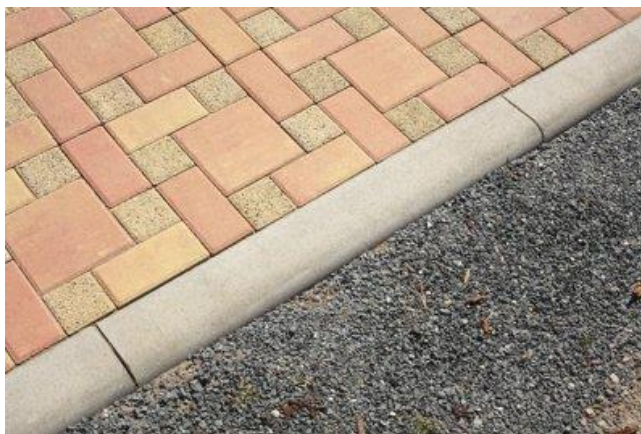
Obrázek 14 - betonová dlažba oddělena betonovou nájezdovou obrubou
