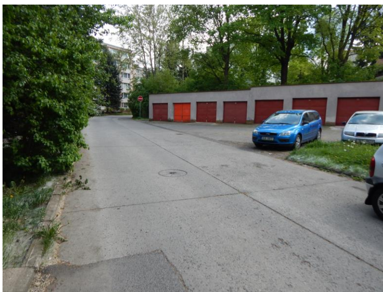
Obrázek 9 - betonové plochy v ul. Červeného
