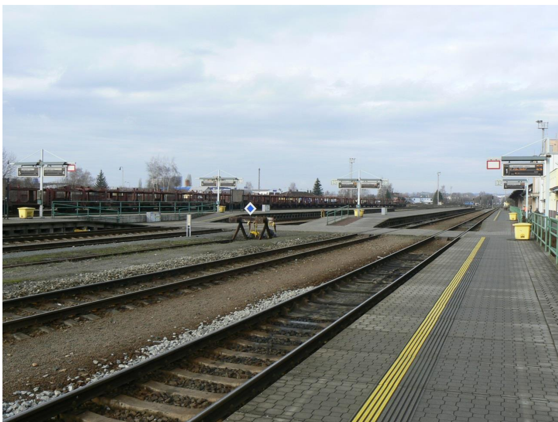
Obr. 36: Pohled na část kolejíště z la. nástupiště u dopravní koleje č. 2
