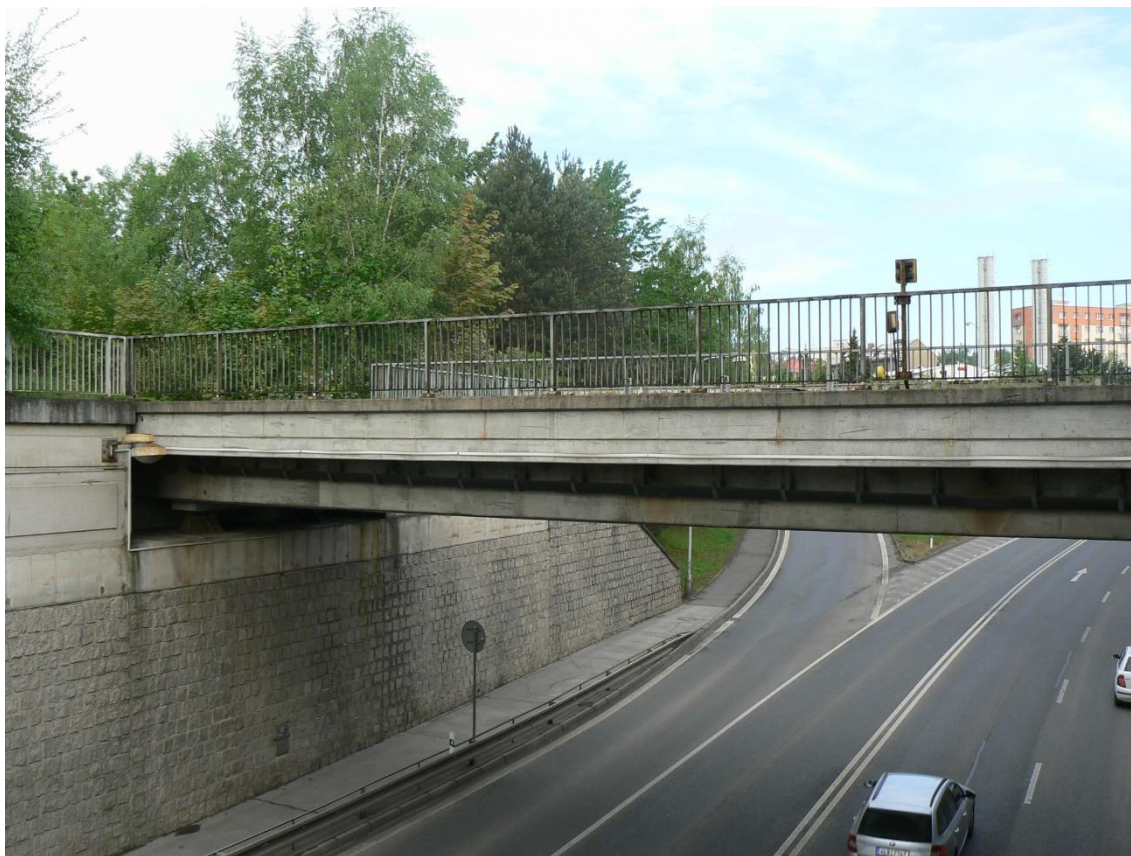
Obr. 31: Pohled na most v km 123,362 a začátek maloskalského zhlaví – výhybka č. 1
