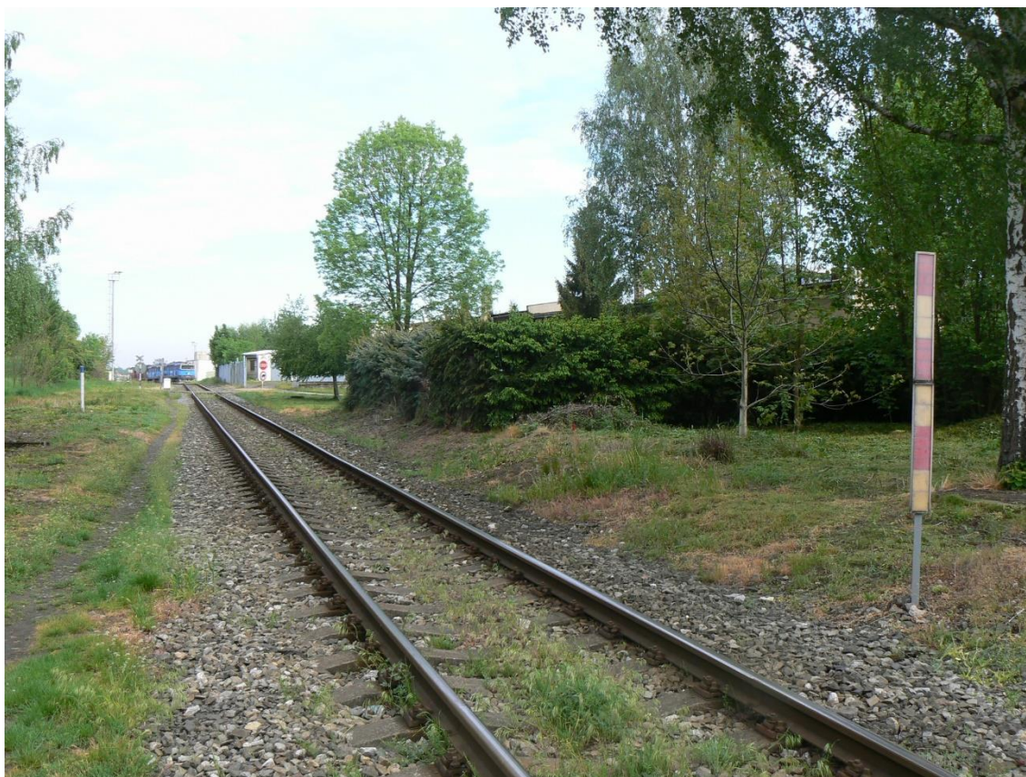
Obr. 28: Pohled na trať 041 směr žst. Turnov ze železničního přejezdu v km 28,815
