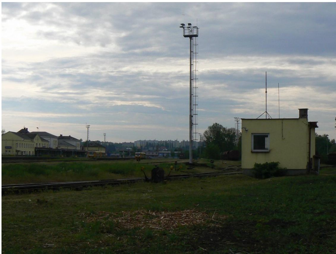
Obr. 21: Pohled na železniční stanici – v popředí stavědlo St. 3
