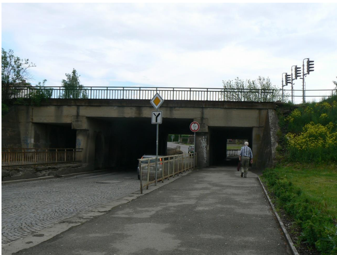
Obr. 32: Pohled na most na liberecko-boleslavském zhlaví
