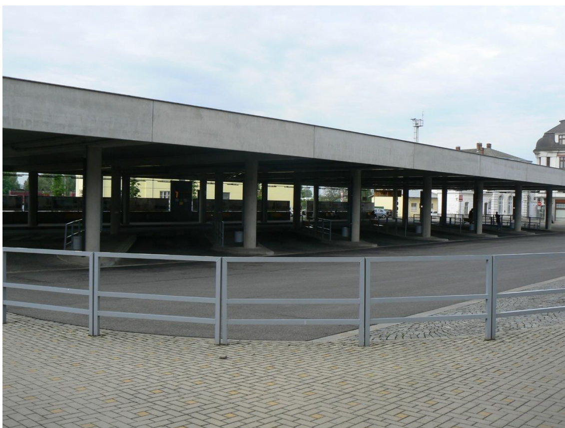
Obr. 7: Pohled na autobusový terminál od centra města
