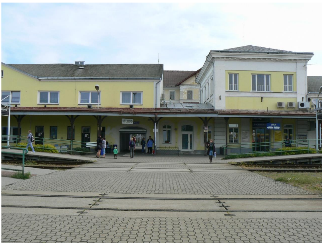
Obr. 18: Pohled na centrální úroňový přechod od III. nástupiště k výpravní budově
