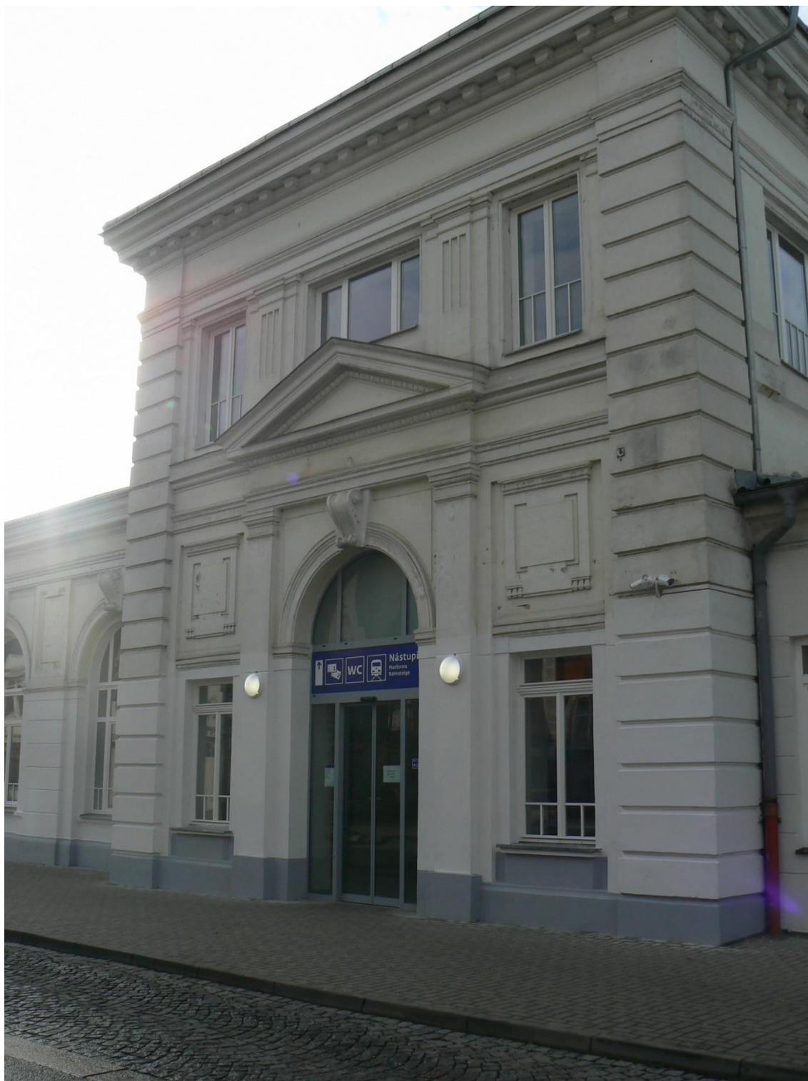
Obr. 1: Hlavní vstup do výpravní budovy
