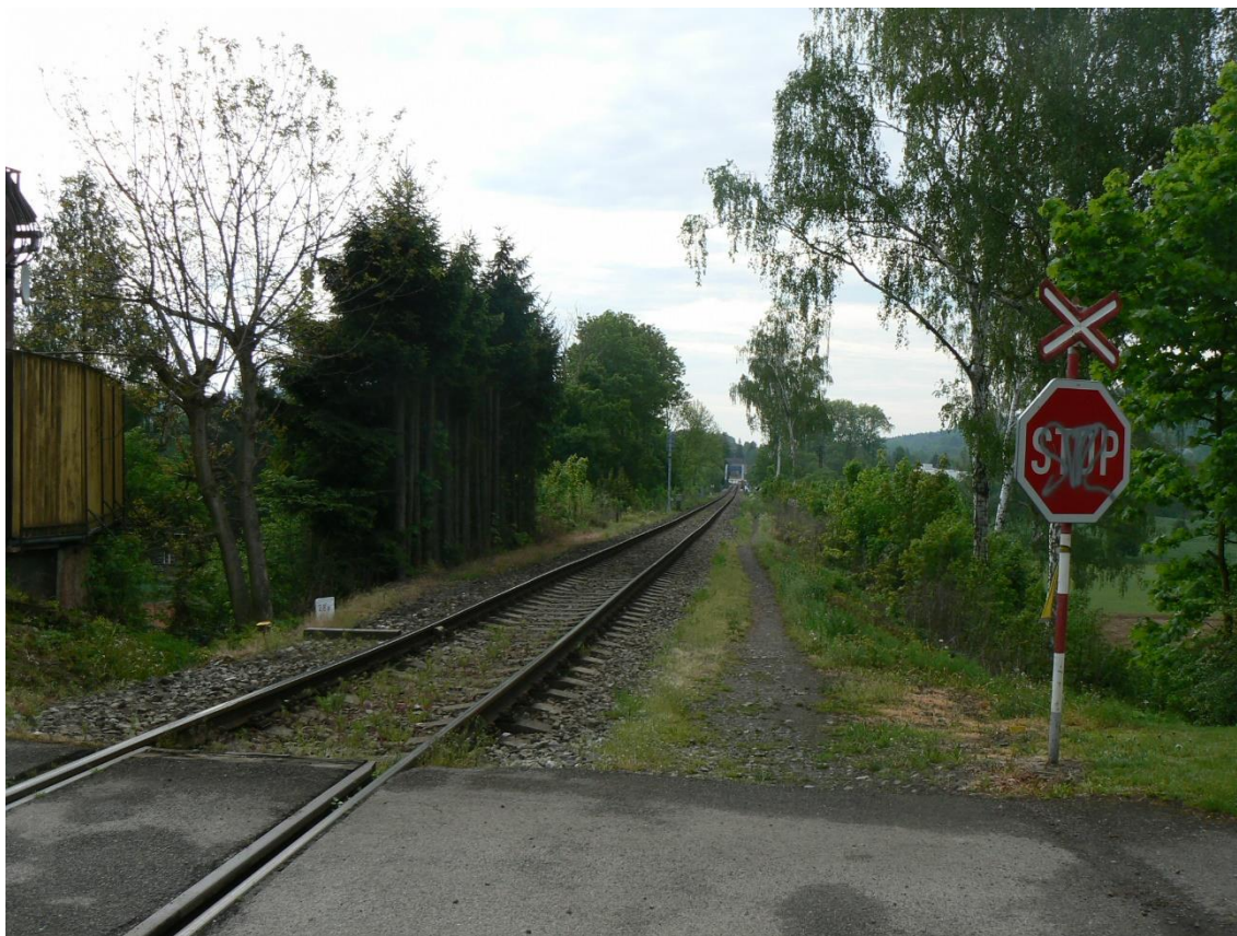
Obr. 27: Pohled na trať 041 směr zast. Turnov město ze železničního přejezdu v km 28,815
