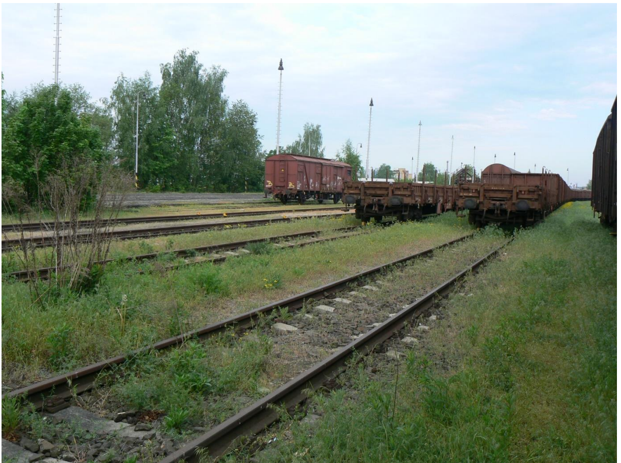
Obr. 26: Pohled od východu na směrové koleje č. 33 – 43
