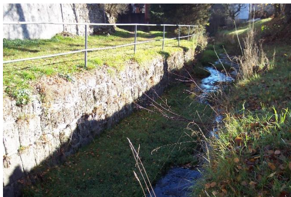
Foto 14: Opevněné koryto Nihošovického potoka - v ř. km 0.000 – 0.500.
