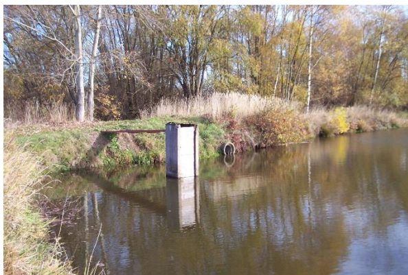
Foto 9: První bezejmenná MVN (profil hráze ř. km 0.155) – rozloha nádrže je 5111 m 2 . Nádrž má funkci rybochovnou a krajnotvornou. Na fotce je vidět spodní výpust typu betonového otevřeného požeráku a BP řešen betonovou troubou DN 400. Vlivem plného uzavření požeráku dlužemi, je průtok nádrží primárně odváděn troubou BP. Na vzdušném líci je trouba odpadu spodní výpustí vyvedena pod troubou BP, tím došlo k vodní erozi vzdušného líce hráze v místě výusti odpadu spodní výpusti a časem může dojít k jejímu protržení.
