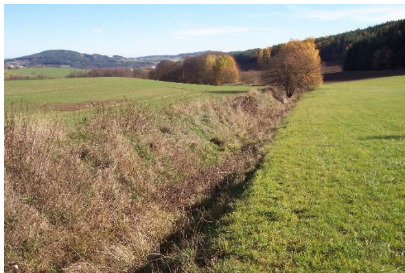
Foto 4: Napřímené opevněné koryto –v ř. km 0.778 – 0.934. Na levém břehu je pozemek orné půdy po pravém břehu se nachází udržované TTP. Koryto je v uvedeném úseku bez břehové stromové vegetace.
