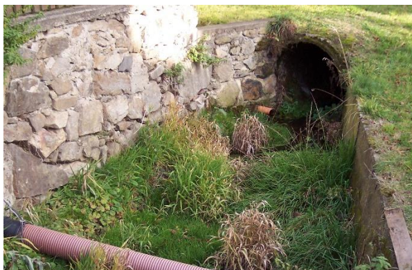
Foto 7: Nátok do zatrubnění v obci Úlehle – trouba DN 600, je zvolena jako kritický bod v obci Úlehle. Vtok do zatrubnění se nachází v ř. km 0.730. Zatrubnění ústí do místní hasičské nádrže, za ní je znovu tok zatrubněn.
