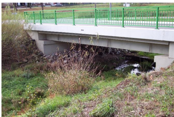
Foto 19: Most obec Radkovice - Rekonstruovaný silniční most v obci Radkovice. Most byl rekonstruován v roce 2008, z důvodu jeho malé kapacity a poničení povodní.
