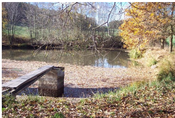
Foto 6: MVN rybník V Luhu – MVN hráz se nachází v ř. km 1.021. Na fotce je zobrazena zátopa se spodní výpustí typu betonového otevřeného požeráku. Kolem nádrže se nachází velké množství stromové vegetace. U nádrže nebyl nalezen BP.
