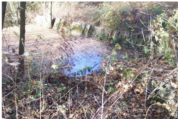
Foto 8: MVN Bělohluvův rybník – MVN hráz se nachází v ř. km 0.863. Na fotce je zobrazena zátopa a hráz MVN. Hráz je na návodním líci opevněná betonovými deskami. Ve variantě PPO s retenčním prostorem v ř. km 0.847 byla navržena SN na ochranu obce Úlehle. Ve variantě PPO bez retence byl návrh nádrží rekonstruovat a využít ji jako rozdělovací objekt k nátoku do původního koryta a navrženého obtokového koryta. Viz. kapitola - 6. Hydrologické výstupy a hydrotechnické návrhy.
