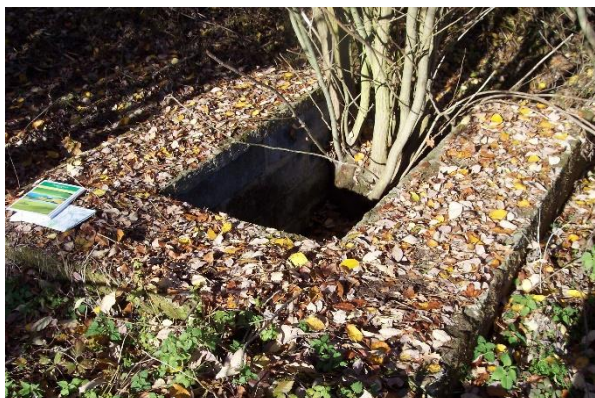
Foto 5: Nátok do propustku – objekt nátoku do propustku se nachází v ř. km 0.954. Zatrubněné koryto se zde nachází z důvodu potřeby přejezdu zemědělské mechanizace. V objektu je zakořeněn bez černý ( Sambucus nigra ), objekt se tím stává méně kapacitní.
