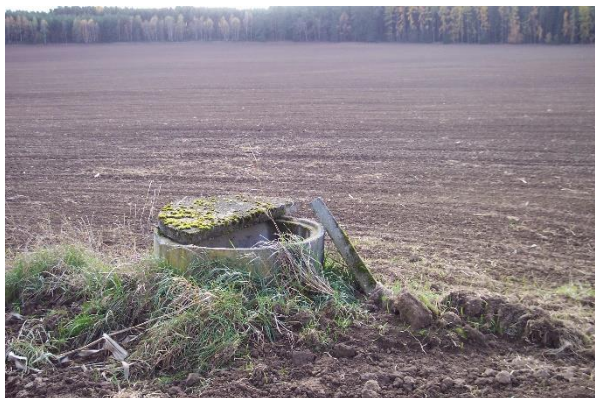
Foto 3: Šachta odvodňovacího zařízení ZVHS 108020390/9 - délka odvodňovacího zařízení je 551 m a převádí odtok z výše položených zemědělských pozemků nad místní komunikací. V průběhu celé jeho délky je 7 revizních šachet.
