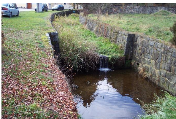
Foto 15: Příčný objekt (stupeň), ř. km 0.332 – Výška objektu je 0,845 m. Objekt byl navržen k účelu zmenšení sklonu nivelety vodního toku v úpravě.
