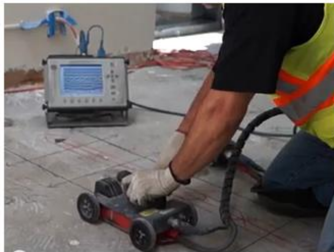
Obr. 2: Průzkum betonové podlahy; Zdroj: [8]
