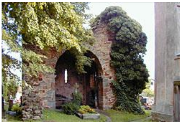
Obr. 22: Presbytář původní budovy kostela sv. Martina; Zdroj: internet
