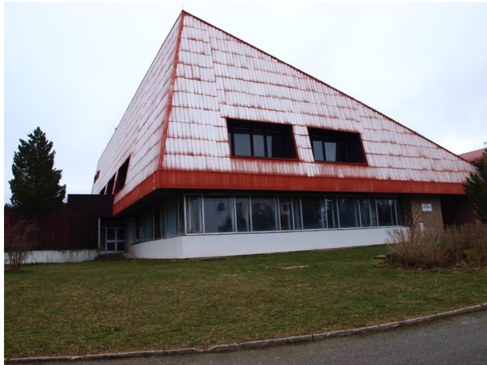
Obr. 61: Hotel Fontána – hlavní budova
