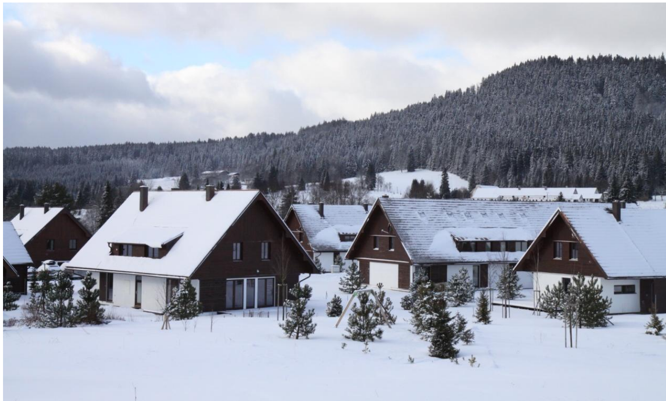
Obr. 26: Výstavba apartmánů v Borové Ladě
