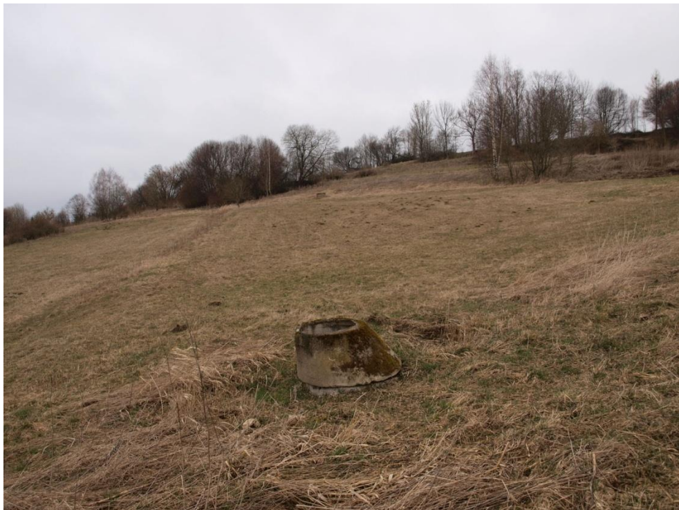
Obr. 70: Kanalizační šachty v řešeném území
