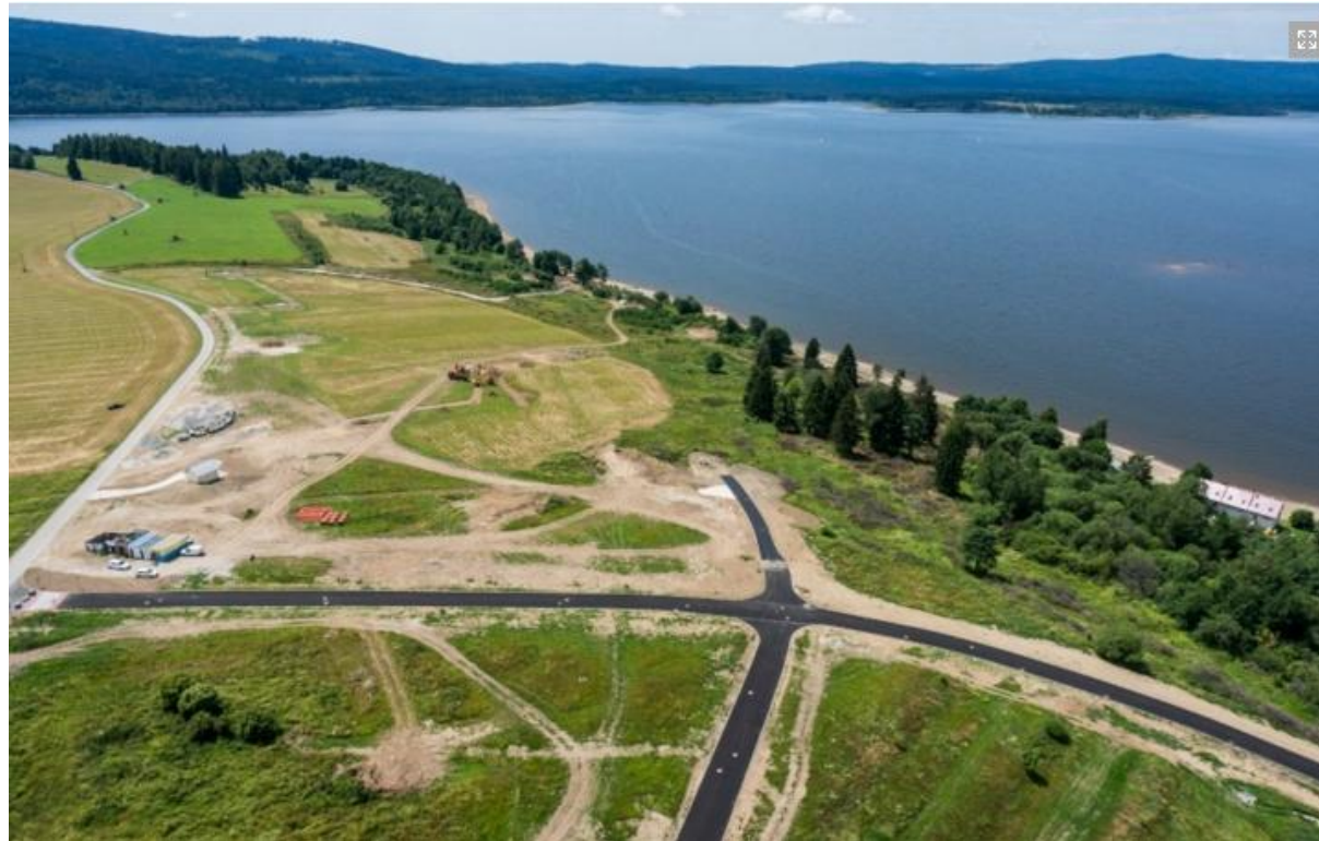
Obr. 40: Letecký pohled na lokalitu projektu Kovářský poloostrov
