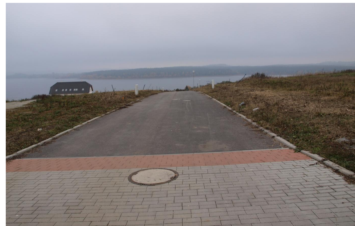
Obr. 43: Obslužná místní komunikace v areálu Kovářský poloostrov
