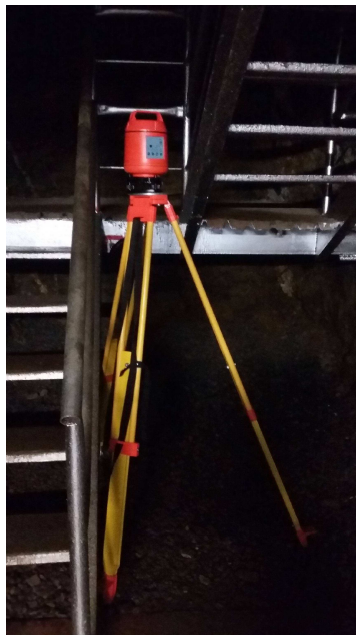
Obr. 5.2c: Stativ s laserovým provažovačem na stanovisku provažování [zdroj vlastní]
