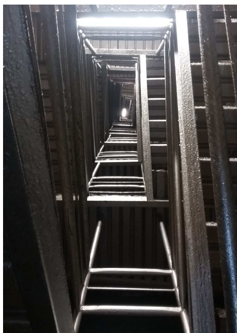
Obr. 5: Pohled zespod do schodišťové šachty [zdroj vlastní]
