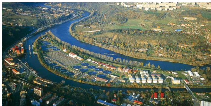
Obr. 3 | Ústřední čistírna odpadních vod v Praze
