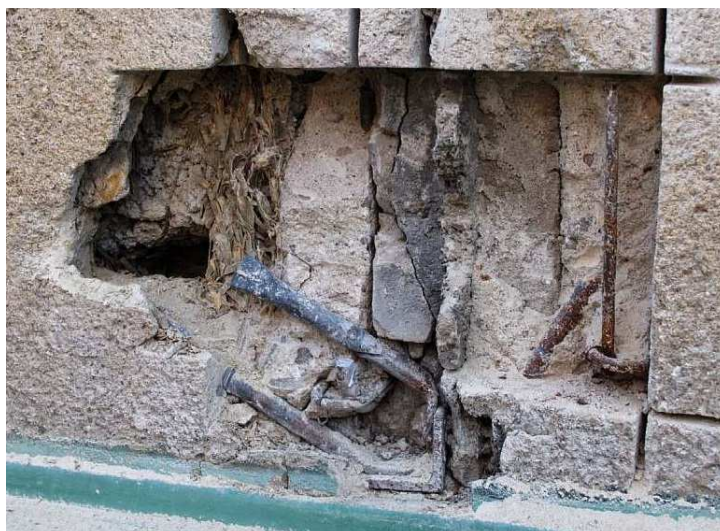
Obr. 2.23: Sonda č. 1 - Místo styku dvou dolních rohů prefabrikovaných panelů (18)
