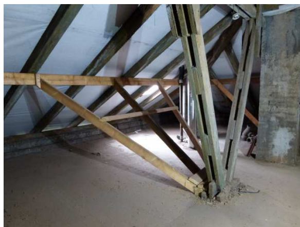
Obr. 2.39: Dodatečné ztužení krokví podepřením v místech severních štítů s valbami
