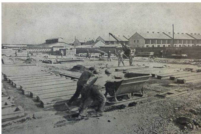
Obr. 1.15: Letní výroba železobetonových stropnic na staveništi ve Strašnicích (11)
