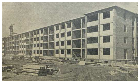
Obr. 1.10: Jižní průčelí bytového domu bloku A ve výstavbě (7)
