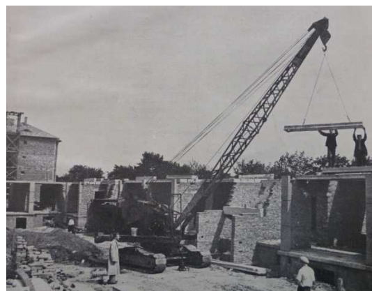
Obr. 1.17: Osazování stropnic pomocí jeřábu na 1.NP bytového domu (12)
