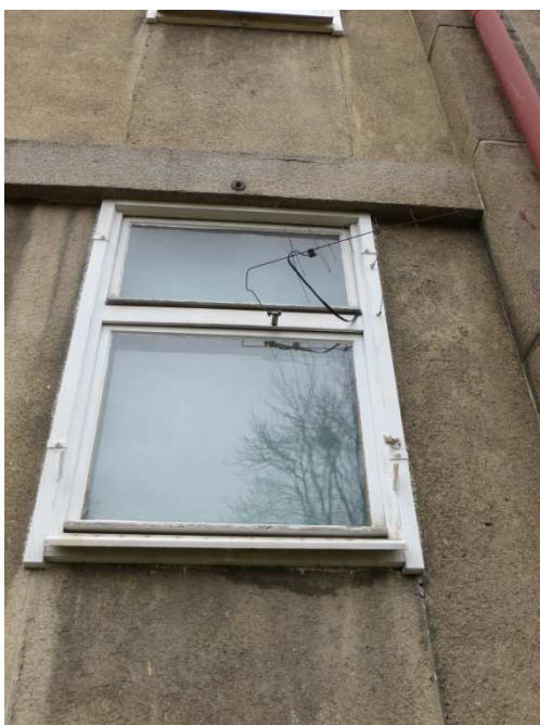
Obr. 2.52: Původní dřevěná výplň okenního otvoru nadzemního podlaží
