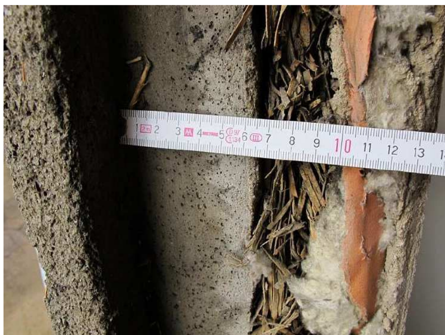
Obr. 2.22: Výměna oken v bloku A1 – Ověření skladby a stavu obvodového pláště (18)
