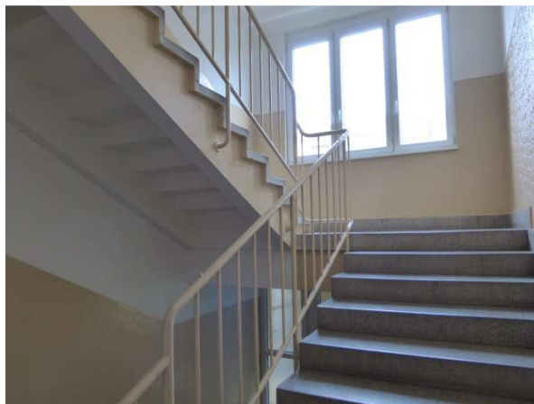
Obr. 2.47: Hlavní schodišťový prostor vnitřní sekce bytového domu
