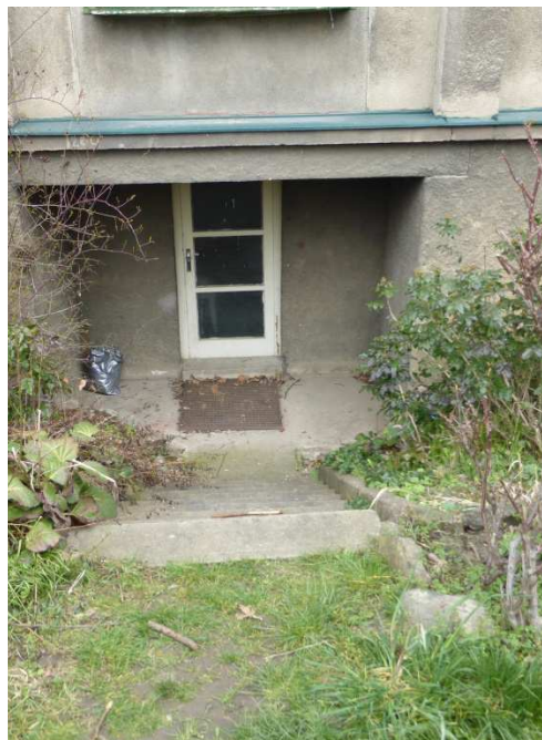
Obr. 2.53: Původní dřevěné vchodové dveře zadního vchodu vnitřní sekce objektu
