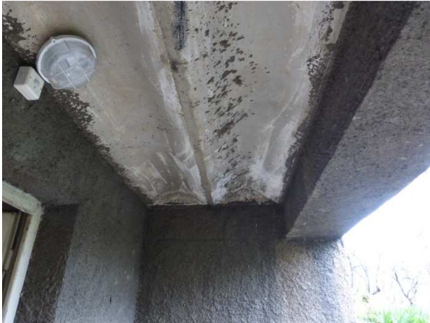
Obr. 2.56: Stropní konstrukce nad zadními vchody do objektu
