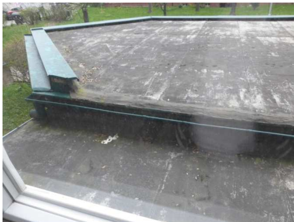
Obr. 2.54: Pohled shora na střešní konstrukci vstupních vestibulů
