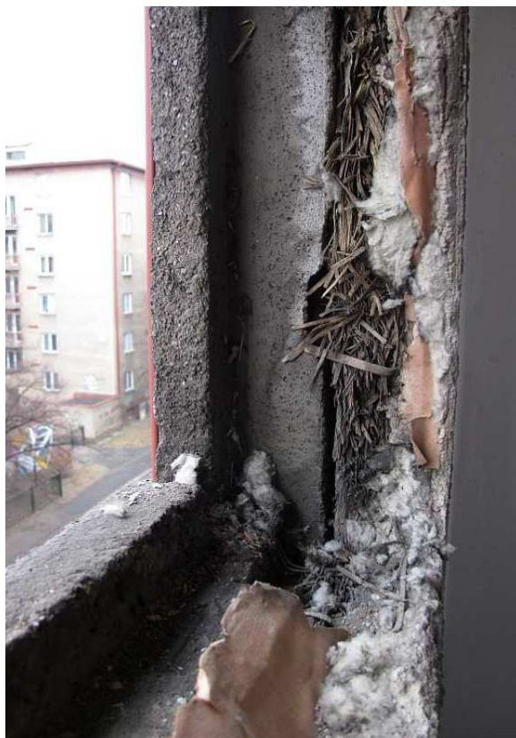
Obr. 2.21: Výměna oken v bloku A1 – Pohled na skladbu obvodového pláště (18)
