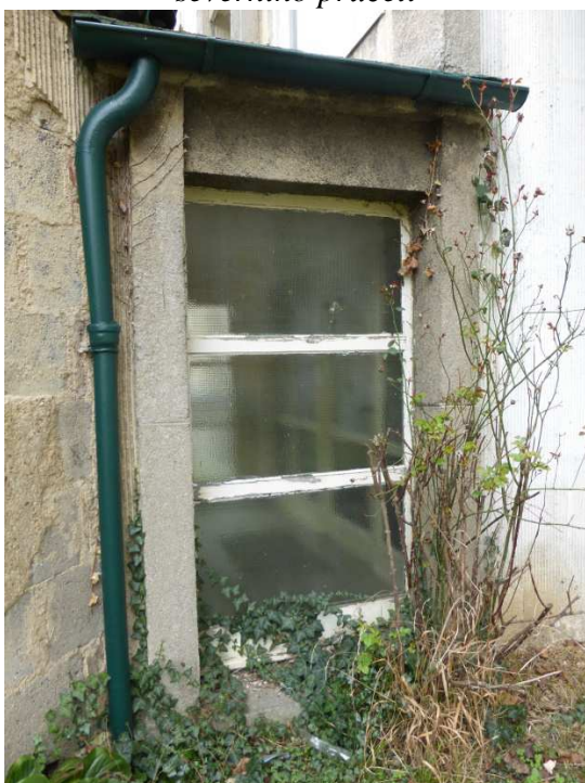
Obr. 2.50: Původní dřevěná prosklená stěna vstupního vestibulu vnitřní sekce na severním průčelí
