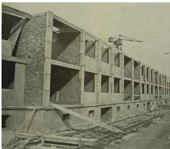
Obr. 1.8: Jižní průčelí bytového domu bloku E ve výstavbě
