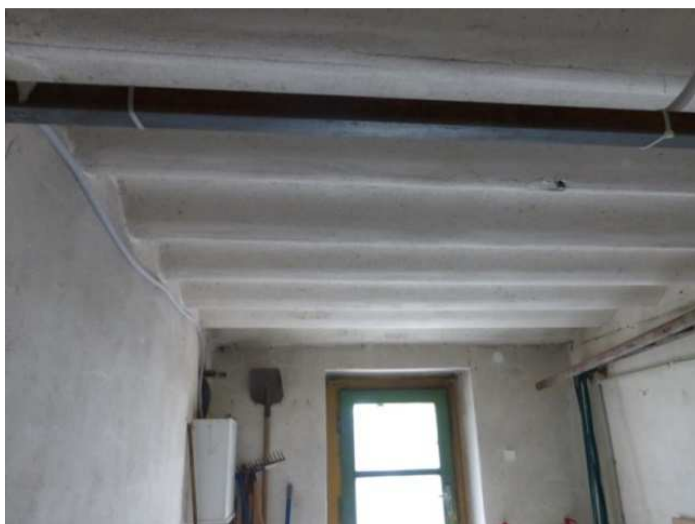
Obr. 2.63: Prostor chodby u zadních vstupů do objektu, podzemní podlaží
