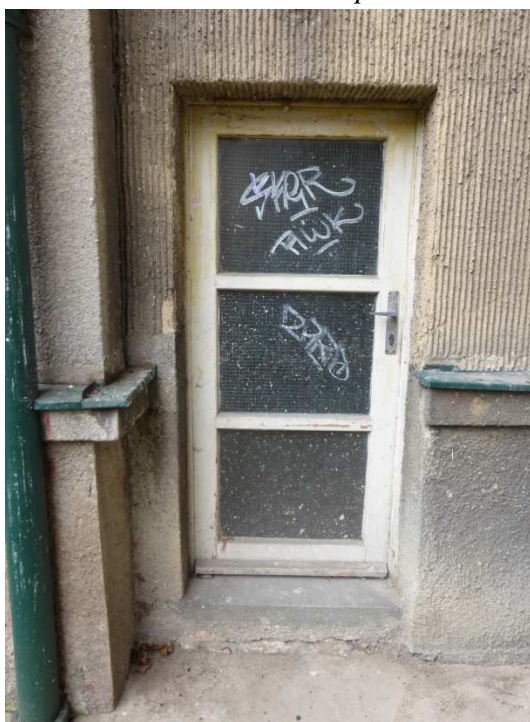
Obr. 2.51: Původní dřevěné zadní vchodové dveře krajní sekce na severním průčelí
