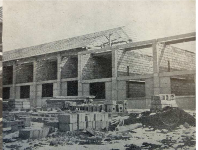
Obr. 1.12: Západní průčelí řadových domků ve výstavbě (11)
