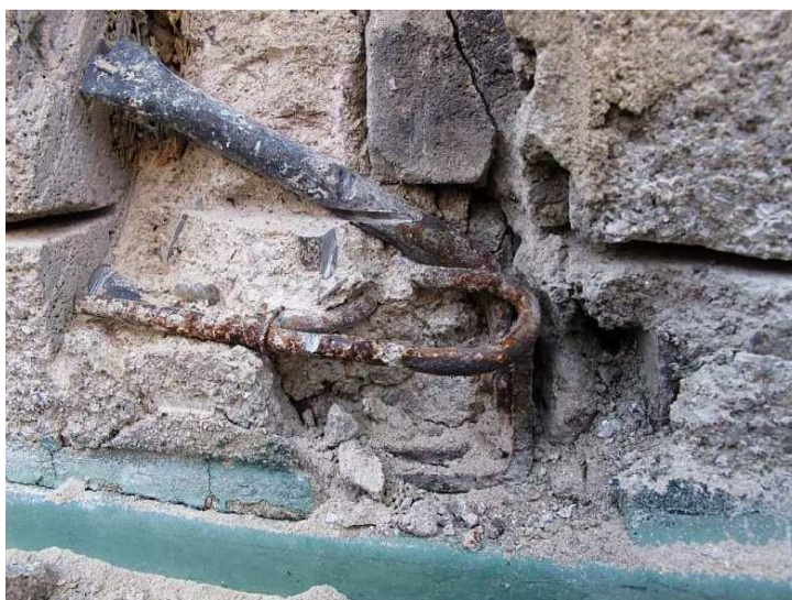
Obr. 2.24: Sonda č. 1 – Detailní pohled na kotvení prefabrikovaných dílců k ocelovým úhelníkům (18)
