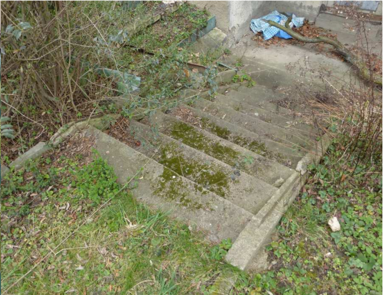
Obr. 2.46: Jednoramenné schodiště v místě zadního vstupu na jižním průčelí, degradace betonu, obnažení výztuže
