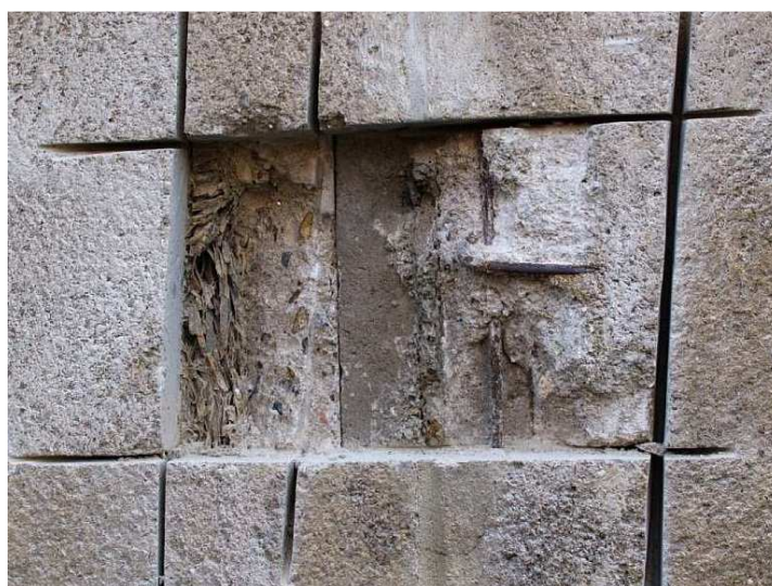
Obr. 2.25: Sonda č.2 – Svislá spára v dolní třetině výšky panelových dílců (18)
