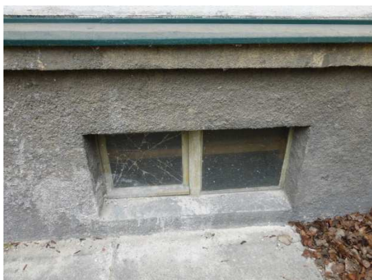
Obr. 2.48: Původní dřevěné sklepní okno severního průčelí
