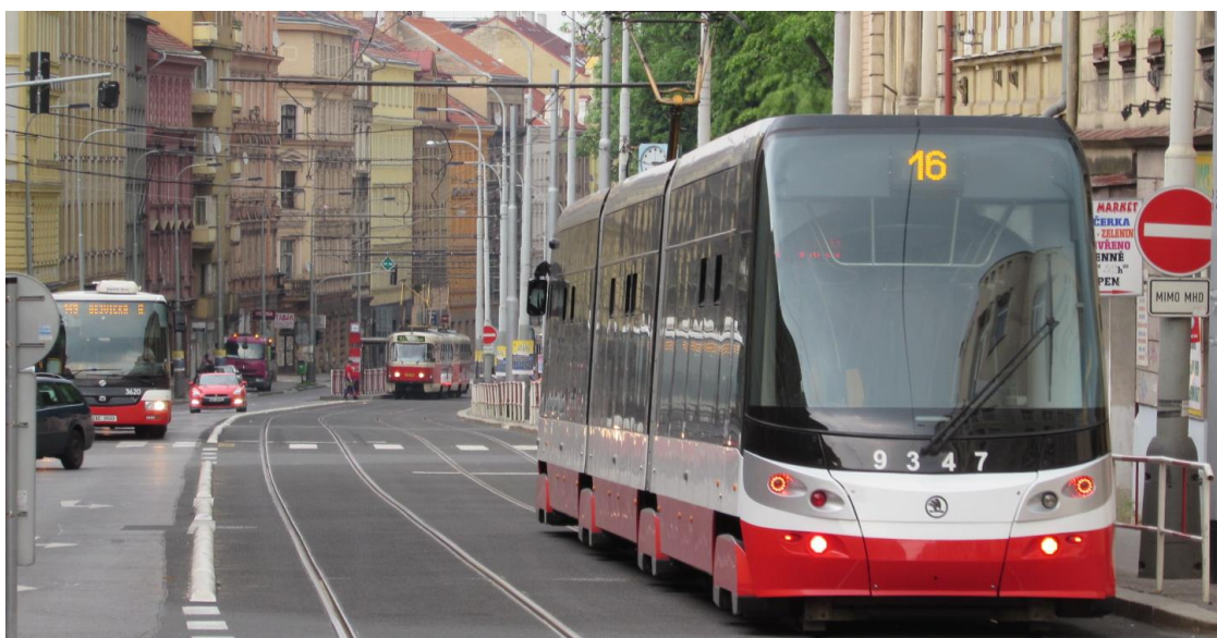
Obrázek 12 - nezvýšený tramvajový pás v ulici Plzeňská (U Zvonu)
