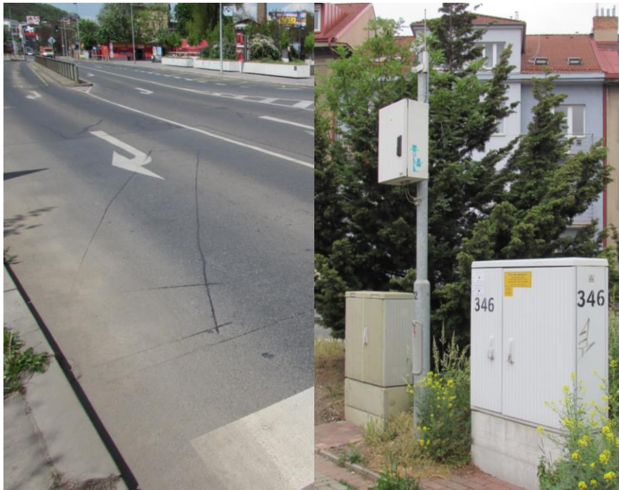
Obrázek 42 - vlevo, ukázka indukční smyčky v křižovatce se SSZ
