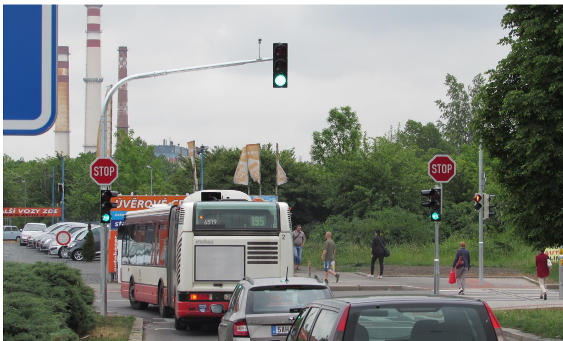
Obr. P7 – nové SSZ a detekční zařízení na křižovatce Dřevčická x Počernická
