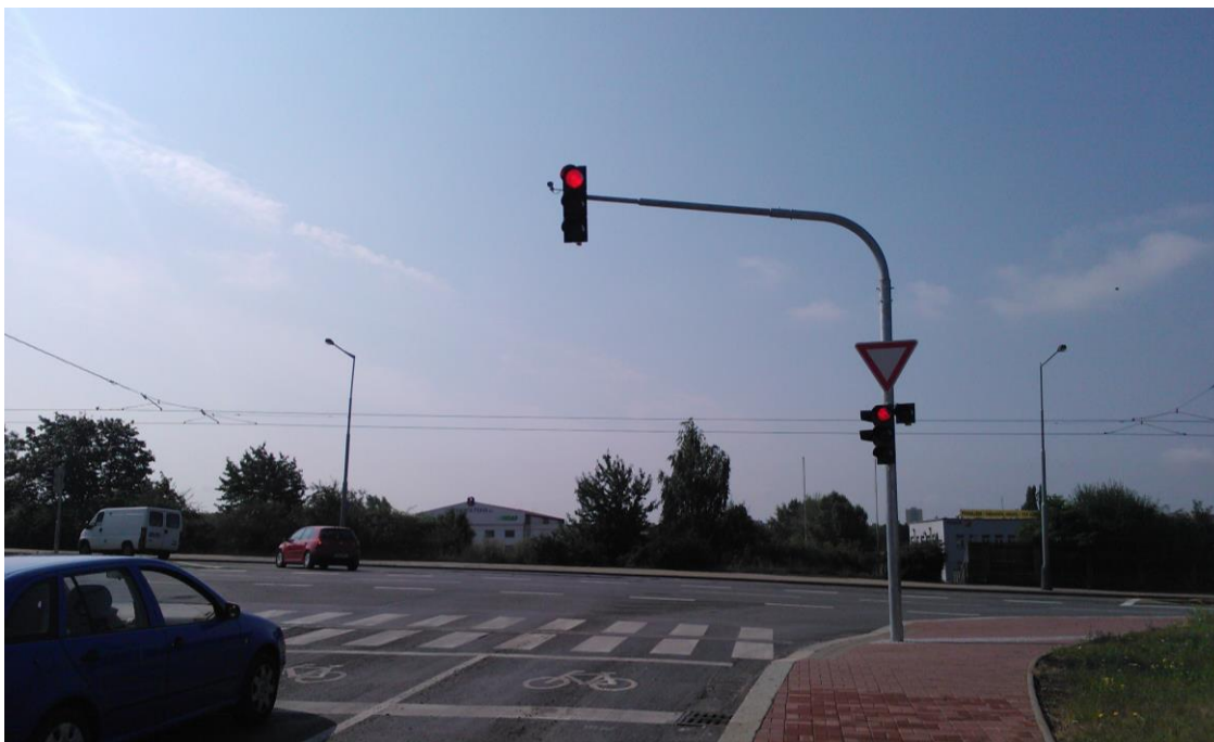
Obr. P6 – SSZ a detekční zařízení na křižovatce Černokostelecká x Dřevčická
