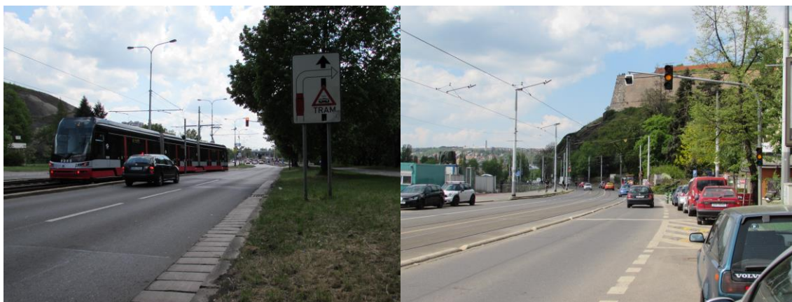
Obrázek 24 - vlevo, světelná závora pro přechod ze zvýšeného tramvajového pásu na segregovanou trať (Přístaviště)
