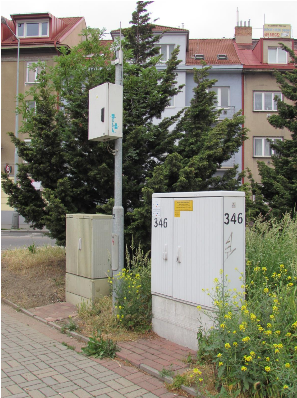
Obr. P1 – řadič křižovatky Černokostelecká x Limuzská (Úvalská)
