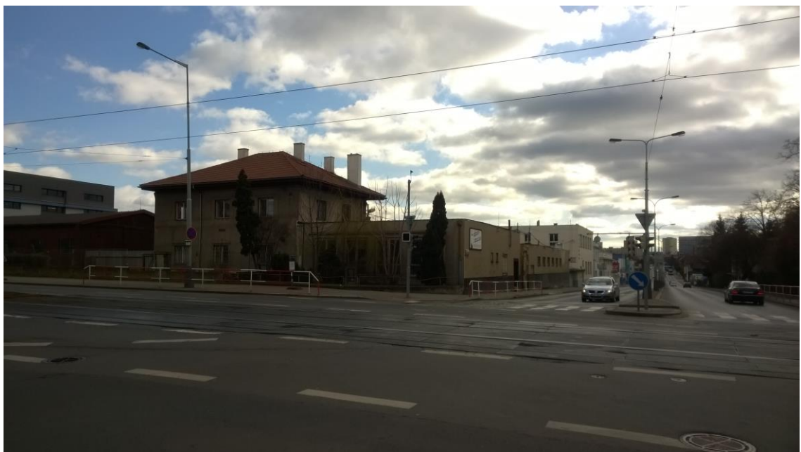
Obr. P13 – aktuální stav pryžového zákrytu tramvajové tratě
