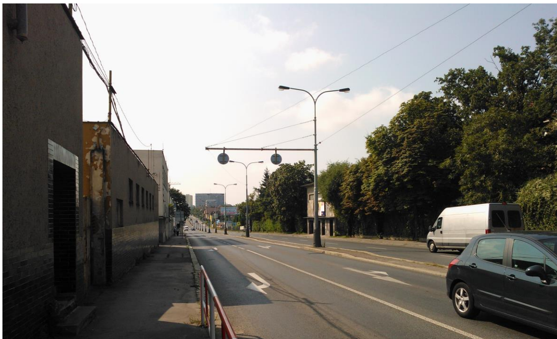
Obr. P14 - pohled směrem do ulice Úvalská
