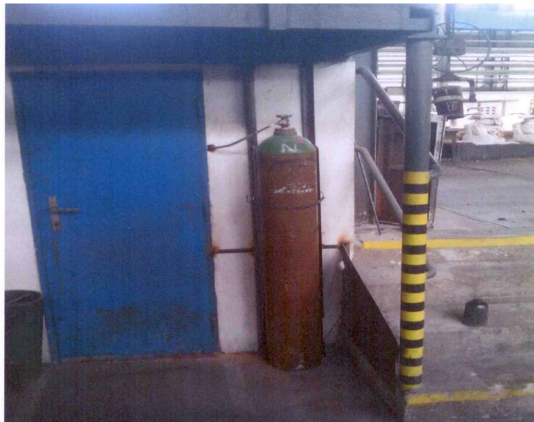
Obr. 74: Umístění a ukotvení tlakové láhve s argonem [56]
