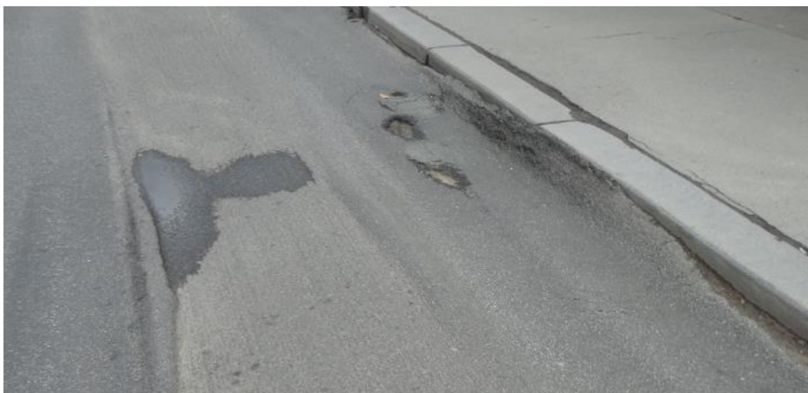
Obrázek 17: Vyjeté koleje v místě zastávky MHD Centrál, směr Tyršův most
