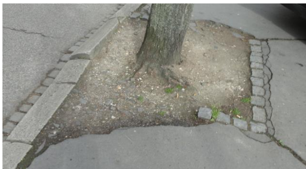
Obrázek 9: Narušení obrub a asfaltového krytu kořeny stromů
