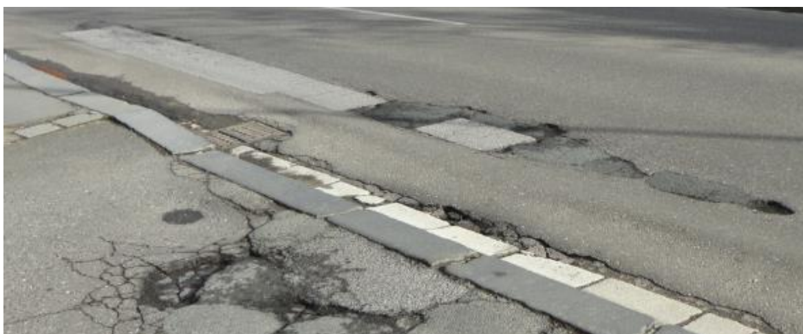
Obrázek 16: Ukázka opravovaných výmolů ve vozovce
