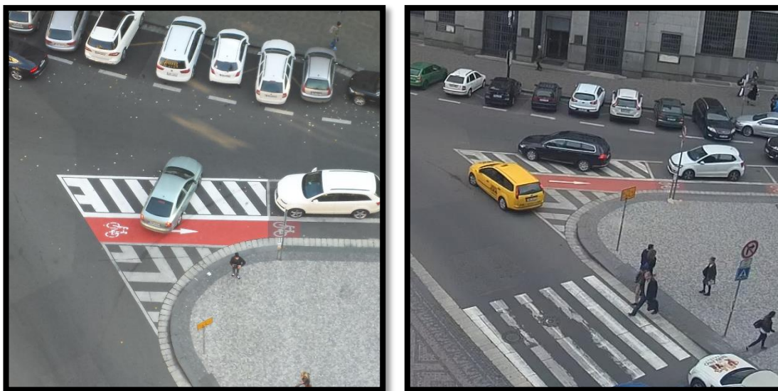
Obrázek 46 a 47 – Použití VDZ místo stavební úpravy
