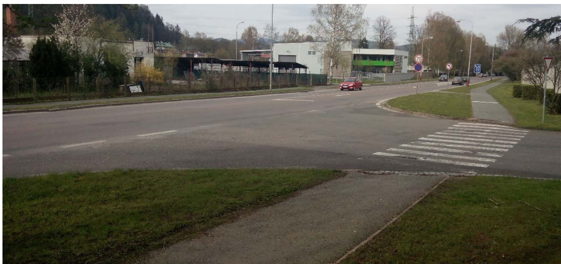
Obr. 11 - Absence dělicího ostrůvku a usměrnění dopravního proudu
