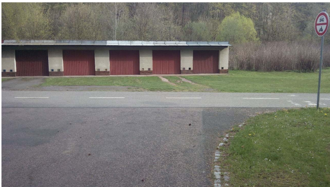
Obr. 12 - Kolize funkčních ploch a jejich chybějící oddělení 1
