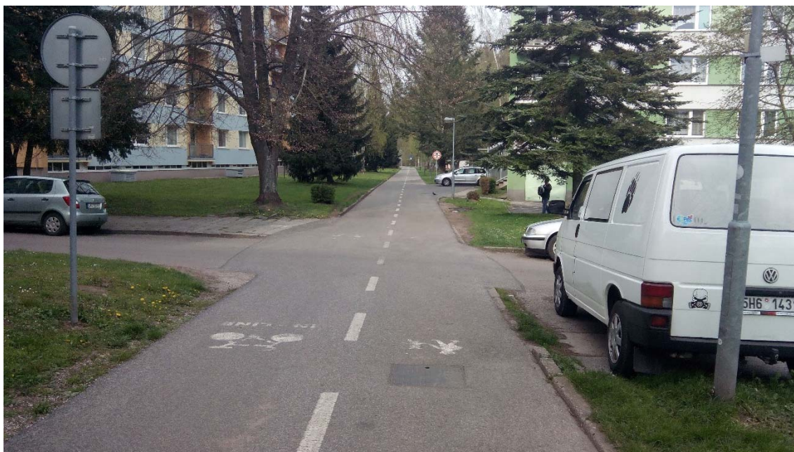
Obr. 13 - Kolize funkčních ploch a jejich chybějící oddělení 2
