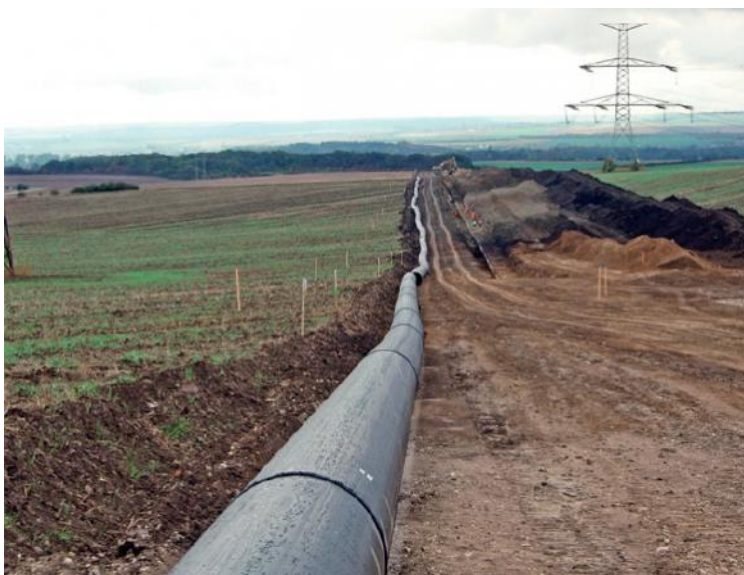
Obr. 2.3 Výměna ocelového potrubního přivaděče vody do paroplynové elektrárny Počeradý za potrubí z PE100+ [14]
