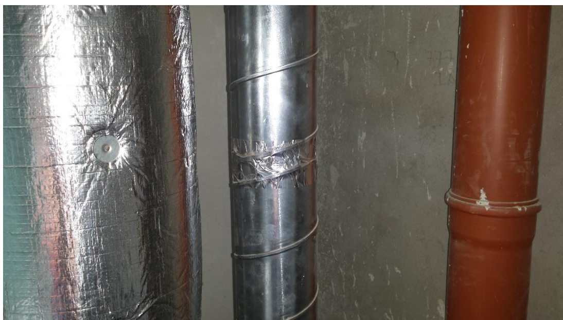
Obr. 4: Bezpřírubový spoj spiro potrubí. (autor Jaroslav Hatoň, 2016)
