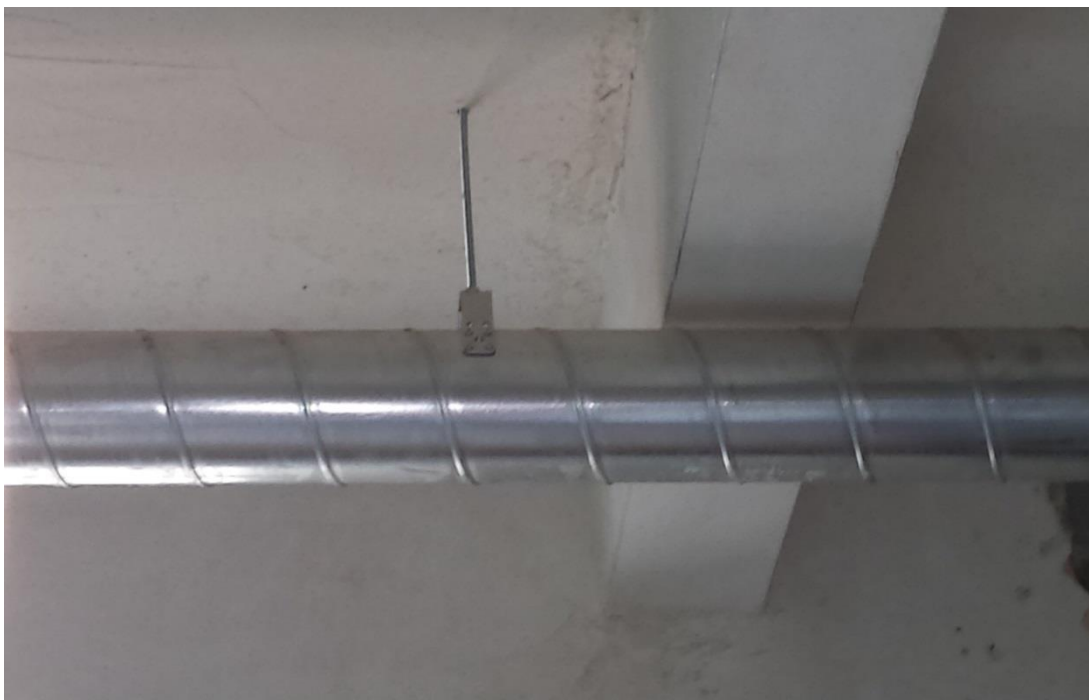
Obr. 3: Kruhové spiro potrubí. (autor Jaroslav Hatoň, 2016)
