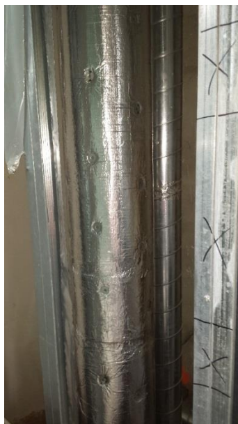
Obr. 17: Protipožární izolace kruhového potrubí. (autor Jaroslav Hatoň, 2016)
