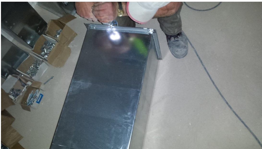
Obr. 7: Uchycení volné příruby. (autor Jaroslav Hatoň, 2016)
