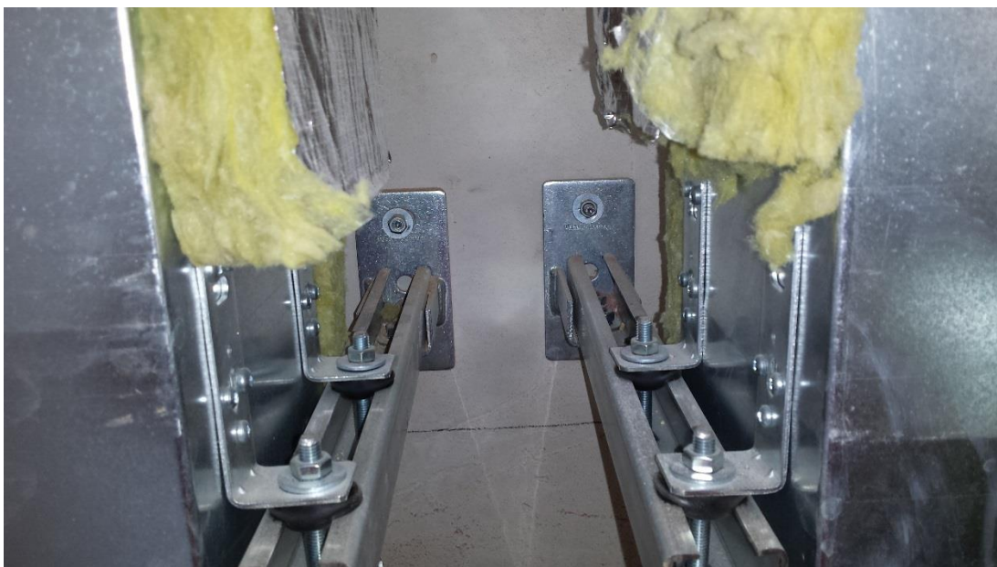
Obr. 21: Montážní profil s funkcí konzoly. (autor Jaroslav Hatoň, 2016)
