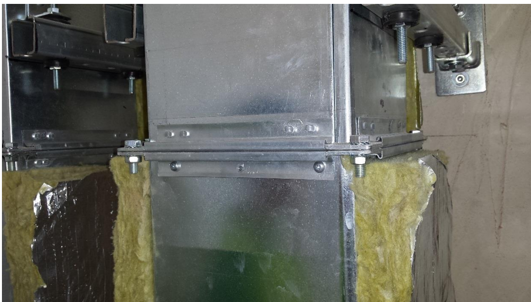
Obr. 8: Přírubový spoj s horní pevnou přírubou a spodní volnou přírubou osazenou na stavbě. (autor Jaroslav Hatoň, 2016)
