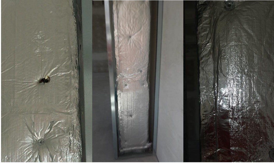
Obr. 22: Přední pohled a detaily tepelné izolace. (autor Jaroslav Hatoň, 2016)
