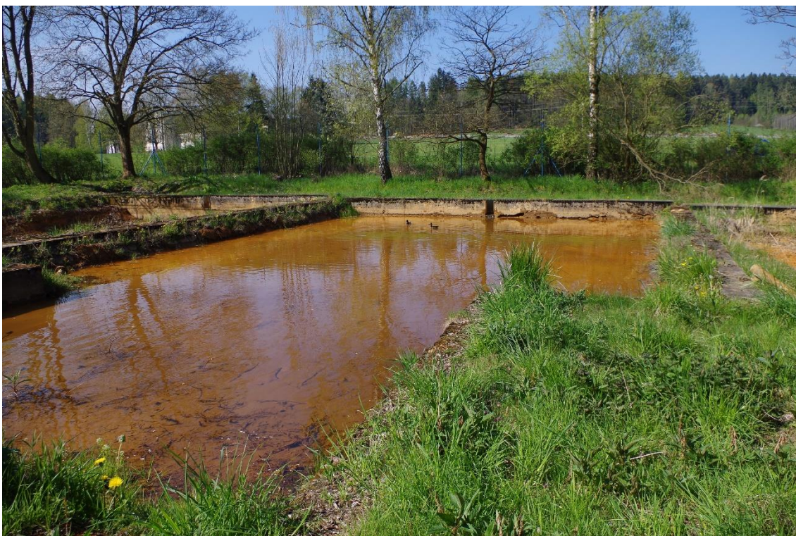
Obr. 3.9. Kalové pole v provozu
