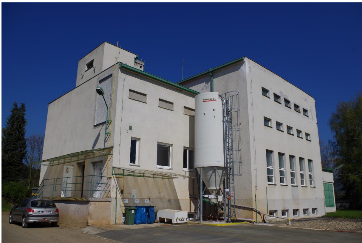
Obr. 3.1. Budova Úpravny vody Janov
