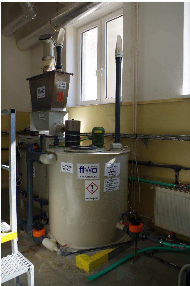
Obr. 3.4. Sestava pro dávkování vápenného hydrátu
