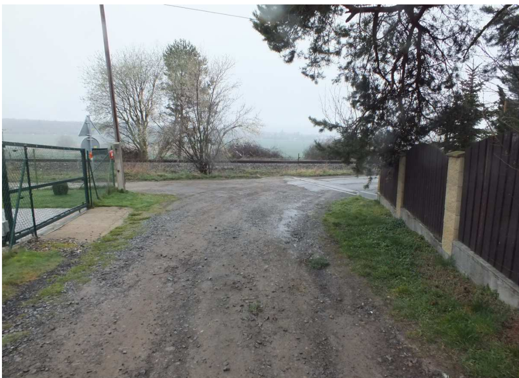
U Lesa – hrana ul. U Kolejů, konec
