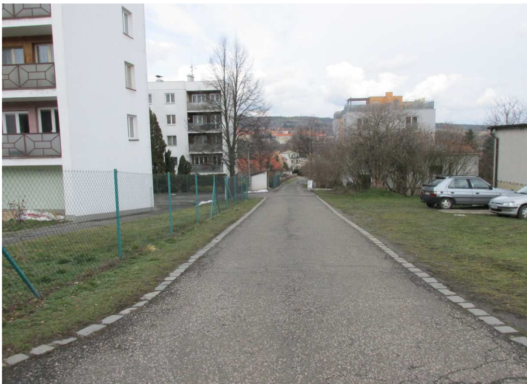
Rymáňská – rameno B, hrana ul. Rymáňská, směrem k ul. Čisovická
