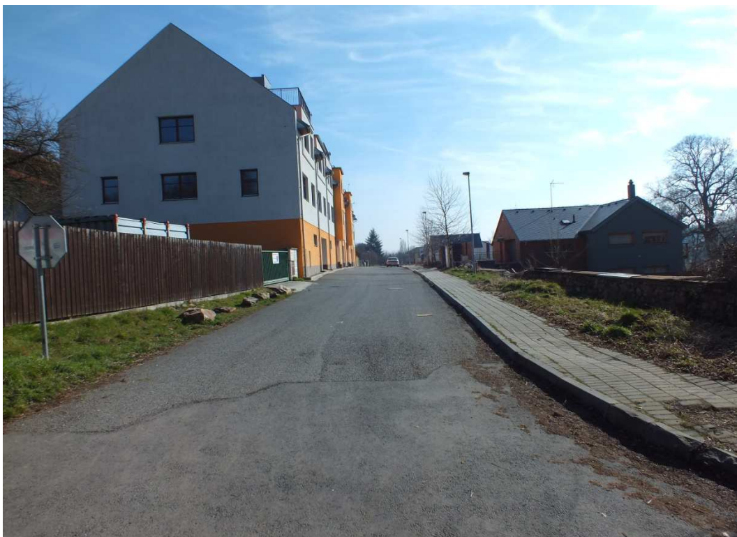
Skalecká – rameno B, hrana ul. Skalecká, směrem k ul. Řevnická
