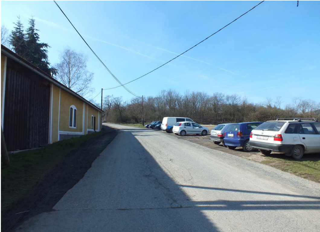
Tovární – hrana nám. F.X.Svobody – západ, směrem k ul. Za Rybníky
