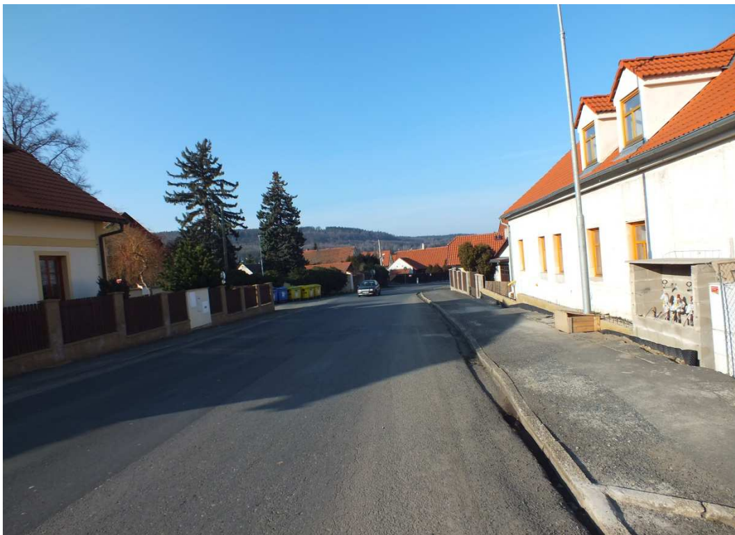
Dobříšská 1 – připojení, vlevo ul. Kytínská
