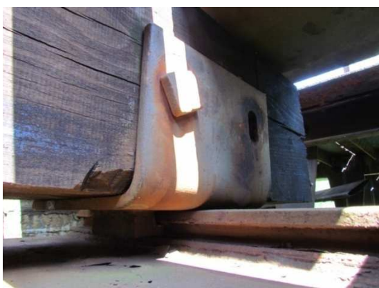
FOTO 17 - Chybějící mostnicový šroub
