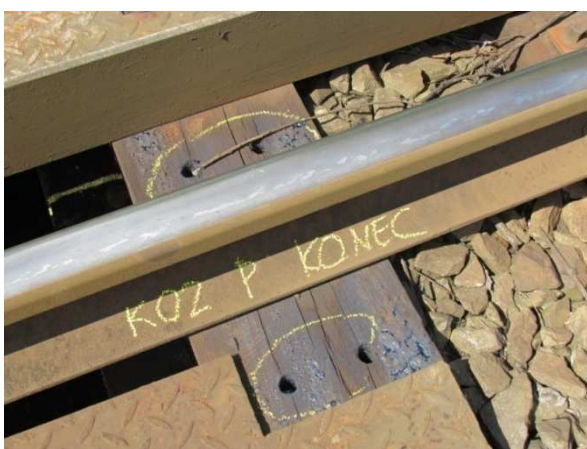
FOTO 17 - Chybějící mostnicový šroub
