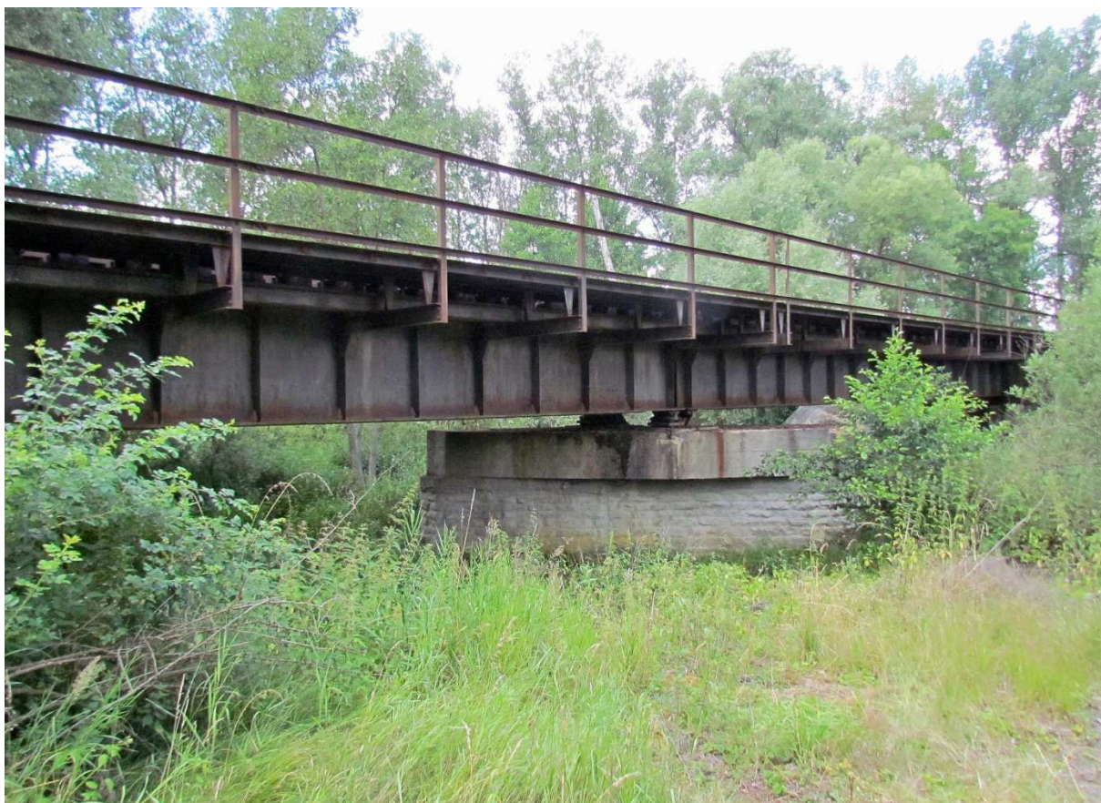
FOTO 1 - Pohled na celý most zprava
