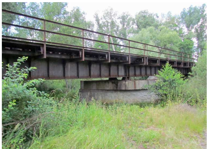
FOTO 20 - Mokřad a vegetace pod mostem
