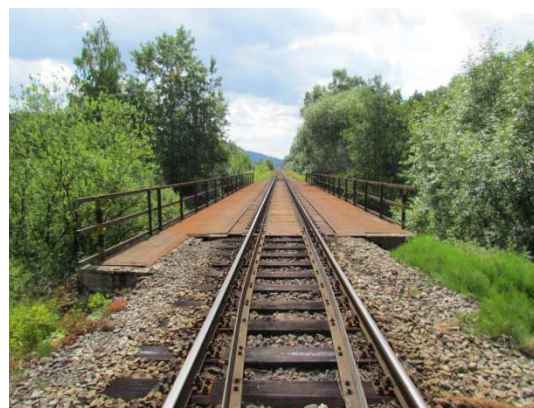
FOTO 9 - Pohled proti směru staničení
