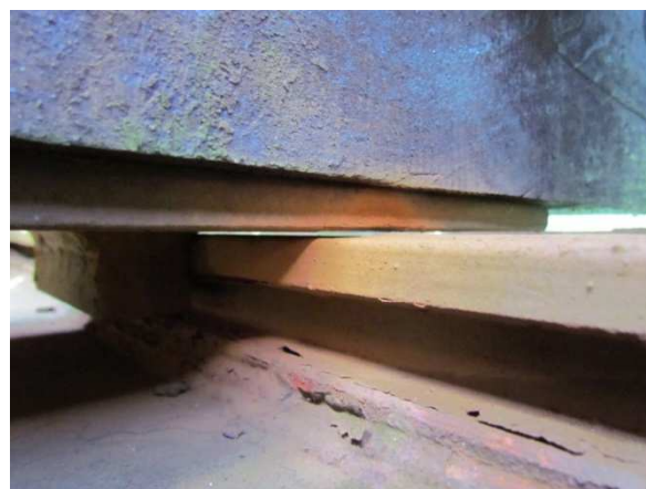
FOTO 18 - Hniloba mostnice, porušená drážbnost vrtulí
