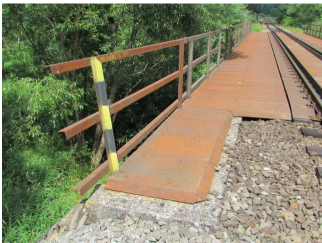
FOTO 19 - Vyklonění zábradlí
