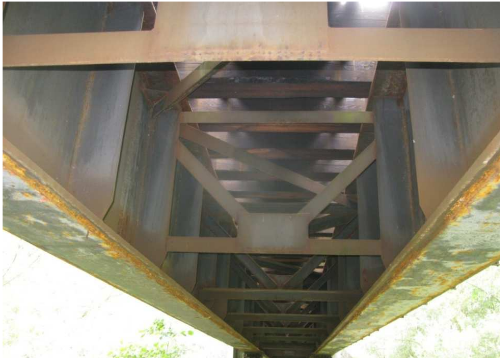
FOTO 2 - Pohled na ztužidla a nosníky
