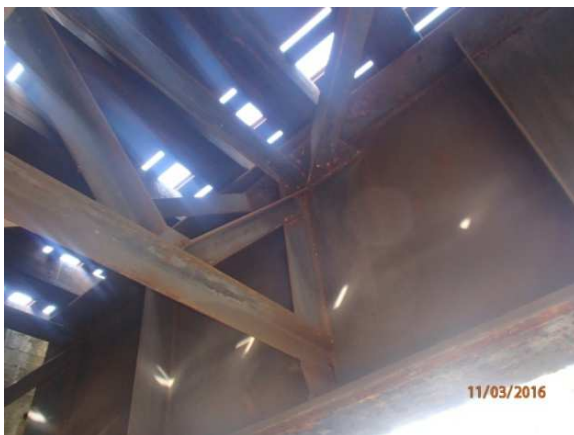
FOTO 12 - Rez na nosné konstrukci
