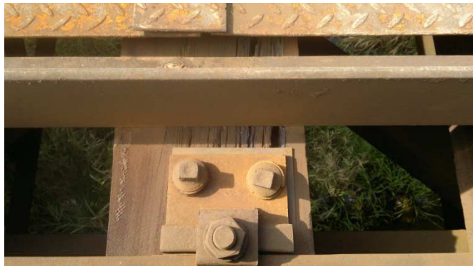
FOTO 7 - Upevnění na pozednice
