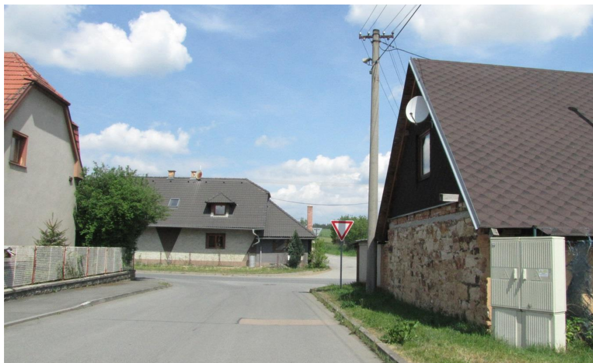
Obr. 27. Nepřehledná křižovatka – nedodržení rozhledových poměrů (trojúhelníků)
