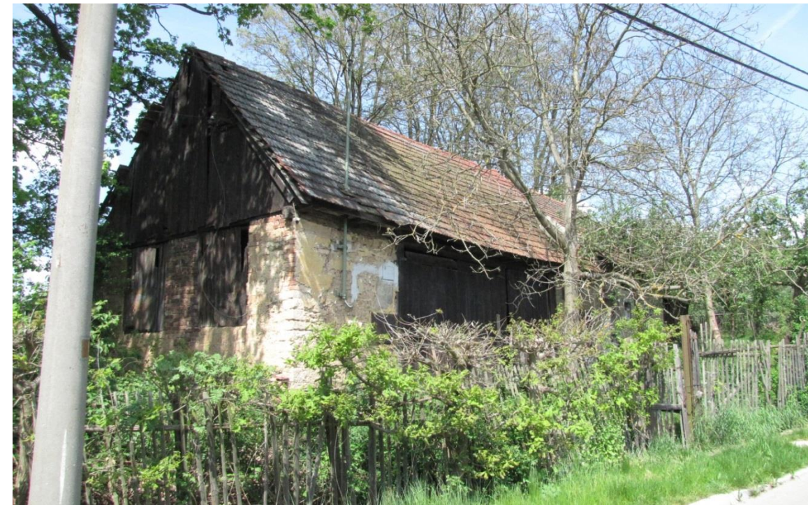
Obr. 25. Stav historického objektu
