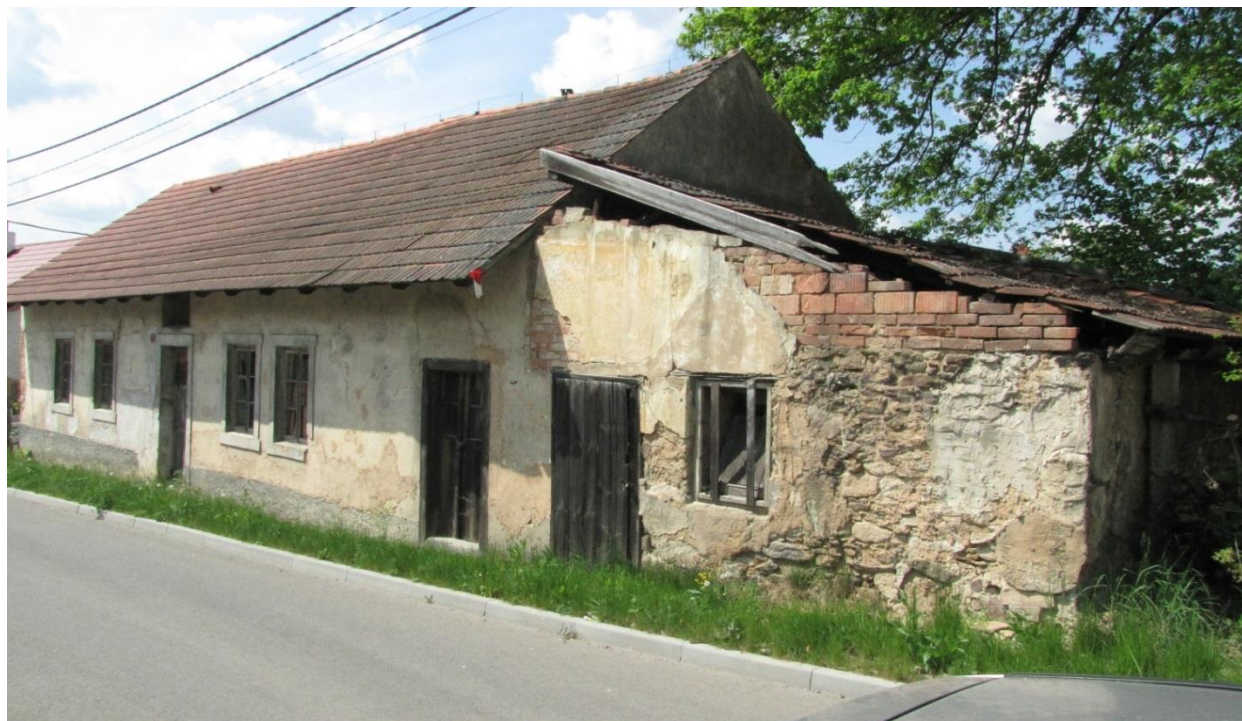
Obr. 24. Stav historického objektu
