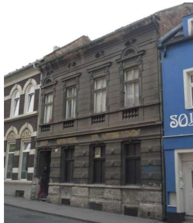
Obr. 63 – Chátrající budova č. p. 63
