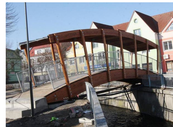
Obr. 10 – Původní lávka přes řeku Bílinu
