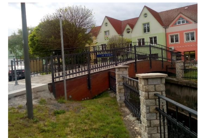
Obr. 11 – Současná lávka přes řeku Bílinu
