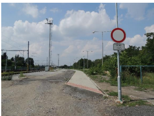
Obrázek 69 – Dlážděný chodníček z Ulice Purkyňova do ulice Na Spojce (pohled od Na Spojce)
