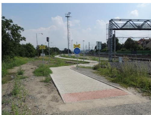
Obrázek 8 - Dlážděná cesta vedoucí od Purkyňovy ulice k ulici Na Spojce
