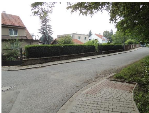
Obrázek 24 - Prvky pro nevidomé navádějí na silnici bez přechodu
