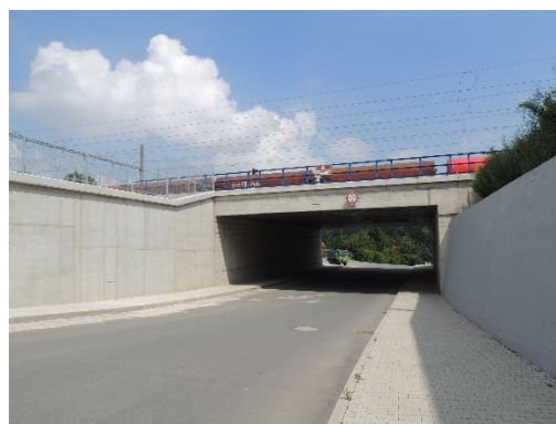
Obrázek 70 – Podjezd pod železniční tratí
