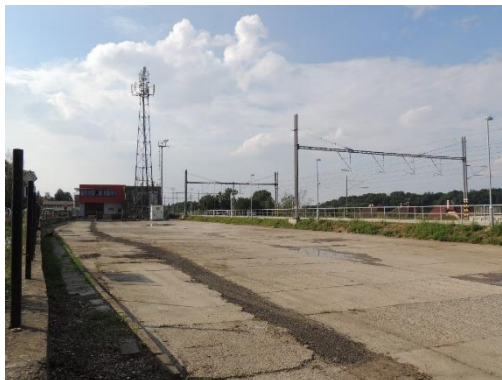
Obrázek 41 – Plocha odkladiště materiálu u železniční stanice Úvaly
