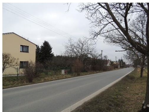
Obrázek 7 - Chybějící chodník v ulici Jirenská, chodci musí jít po silnici
