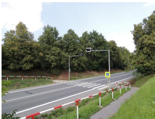
Obrázek 52 – Stávající stav přechodu pro chodce přes silnici I/12 ve staničení km 2,18
