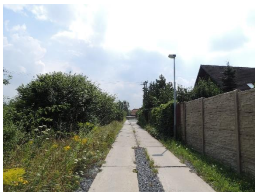
Obrázek 65 – Betonová cesta podél Jirenské ulice (II/101)
