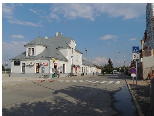
Obrázek 73 – Ulice Jiráskova, absence zálivů pro autobusy u výpravní budovy
