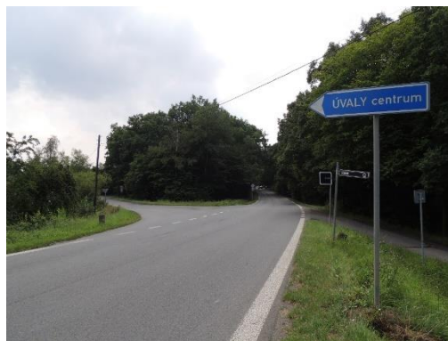
Obrázek 14 – Křižovatka ulic Jirenská x Klánovická, absence přechodu pro chodce a pěší infrastruktury, špatné rozhledové poměry
