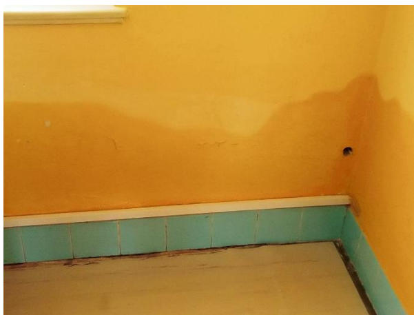
Obr. 4: Projevy vzlínající vlhkosti v interiéru
