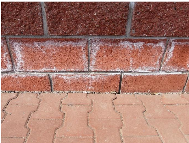
Obr. 6: Projevy soli používané jako tavidlo sněhu
