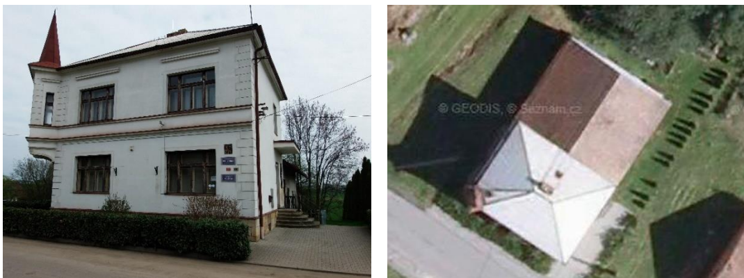
Obr. 15: Samostatně stojící objekt, vlevo pohled, vpravo letecký snímek [22]
