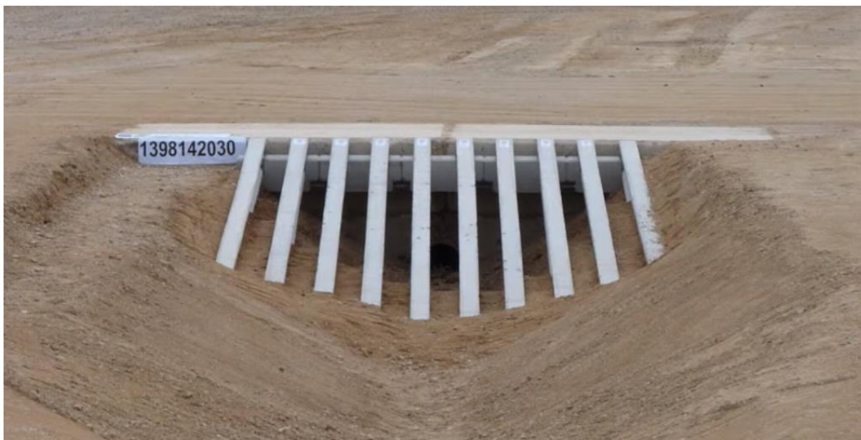
Obr. [44] Segmenty umístěné před čelem samostatného sjezdu
