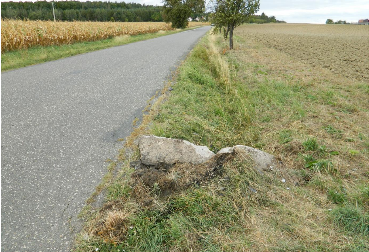
Obr. [31] Místo nárazu automobilu Peugeot 206 do čela propustku
