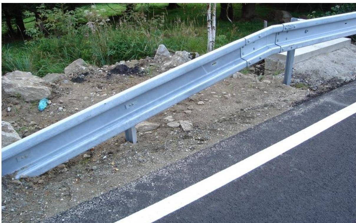
Obr. [21] Vhodné ukončení svodidla s krátkým náběhem
