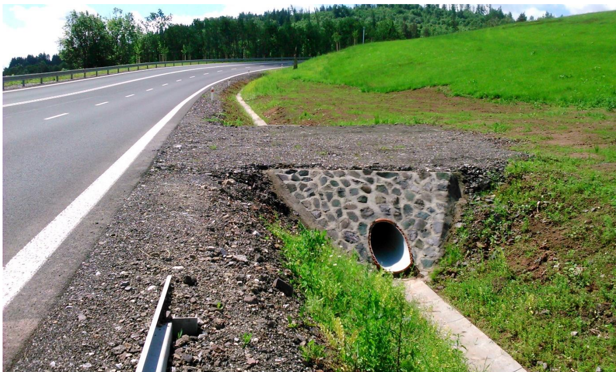
Obr. [25] Šikmé čelo samostatného sjezdu, silnice II/295 u obce Zálesní Lhota
