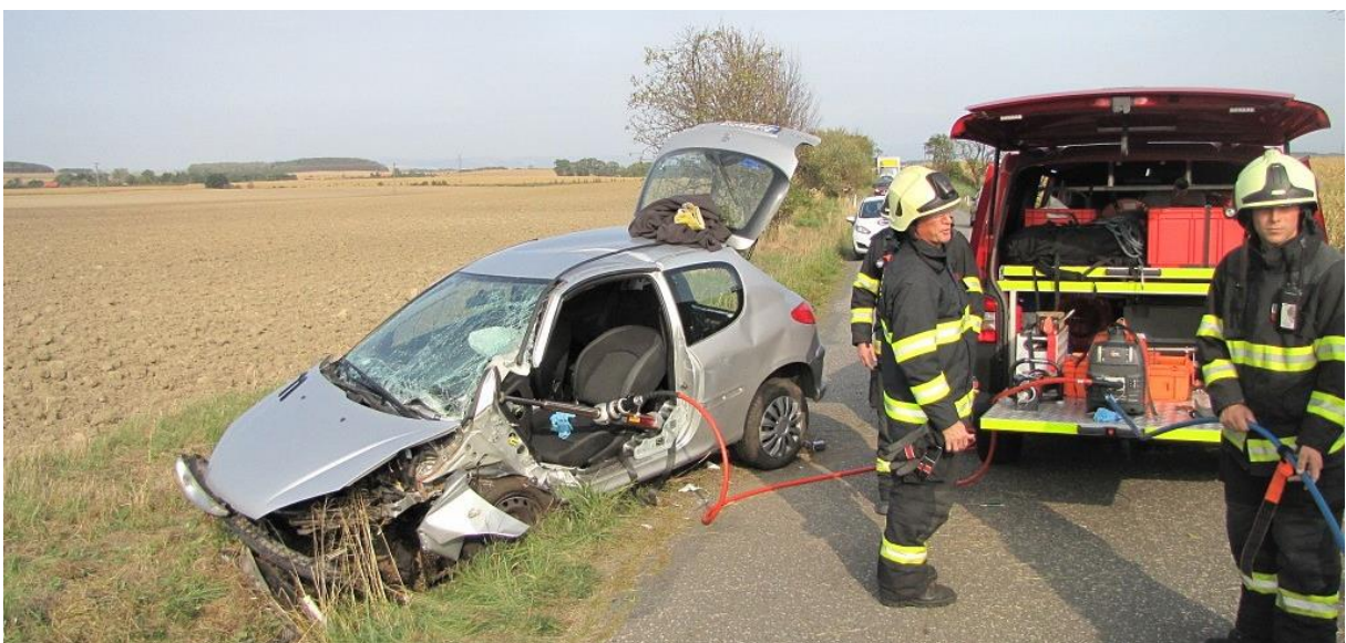
Obr. [32] Poloha automobilu po nárazu do čela betonového propustku
