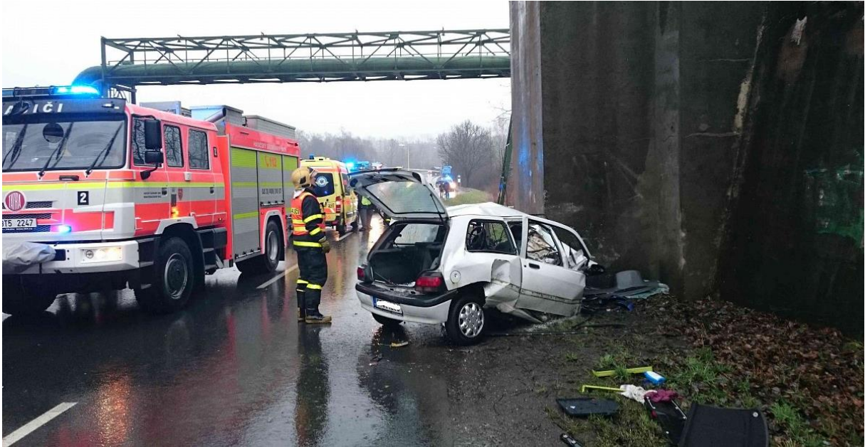
Obr. [20] Náraz vozidla do železobetonového mostního základu, nezabezpečeného
