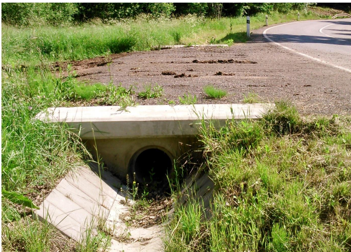
Obr. [24] Rovné čelo samostatného sjezdu, silnice I/16 u obce Horka u Staré Paky
