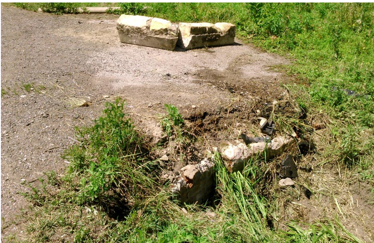
Obr. [38] Místo nárazu automobilu Škoda Fabia II. generace do čela samostatného sjezdu
