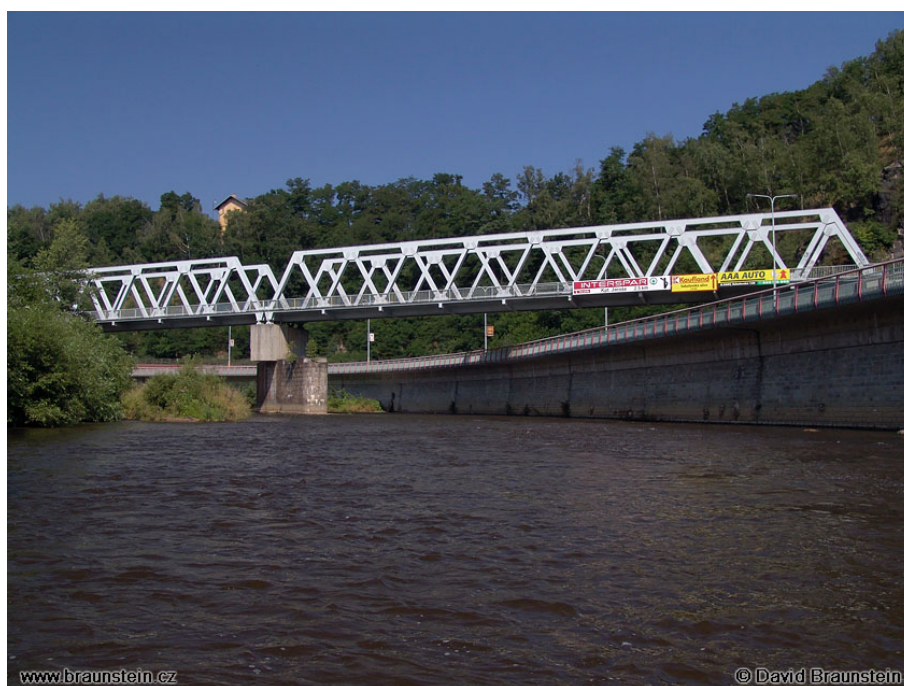
Obrázek 5 Vedení průtahu I/6 Karlovými Vary nad řekou Ohří, železniční most v mezistaničním úseku K. Vary dol. n. - K. Vary, v pozadí mezi stromy objekt bývalé vodárny stanice Karlovy Vary, zdroj: www.braunstein.cz
