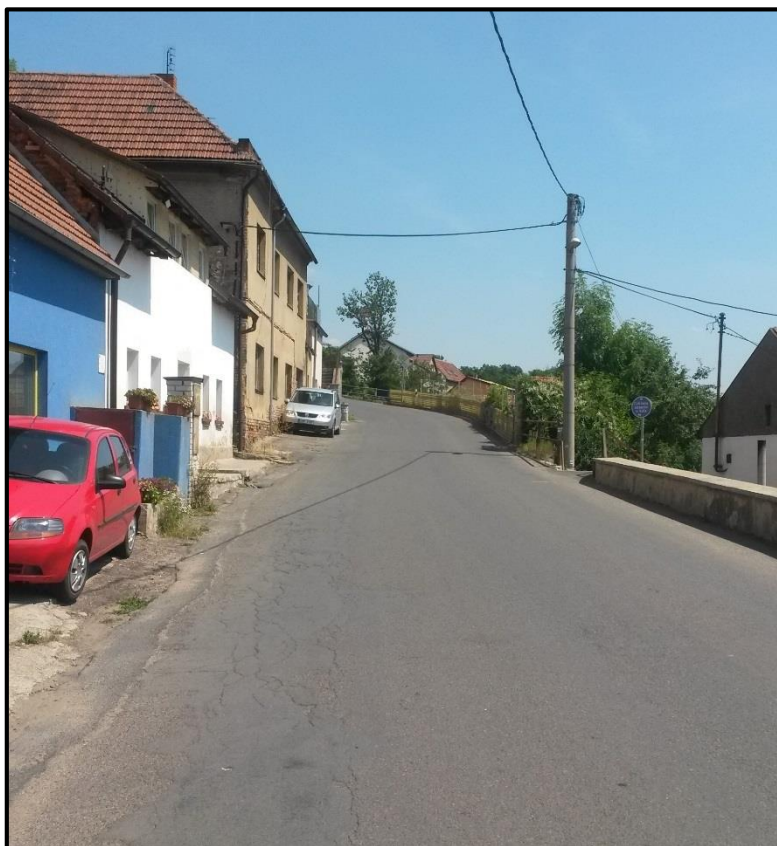
Obr. 24: Pohled směrem ke křižovatce Rýznerova X Josefská
