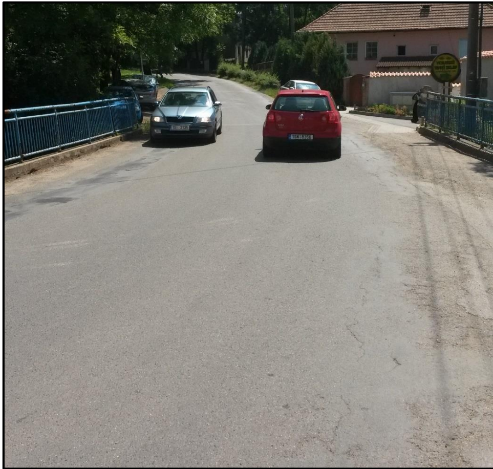
Obr. 20: Pohled přes most směrem k pivovaru
