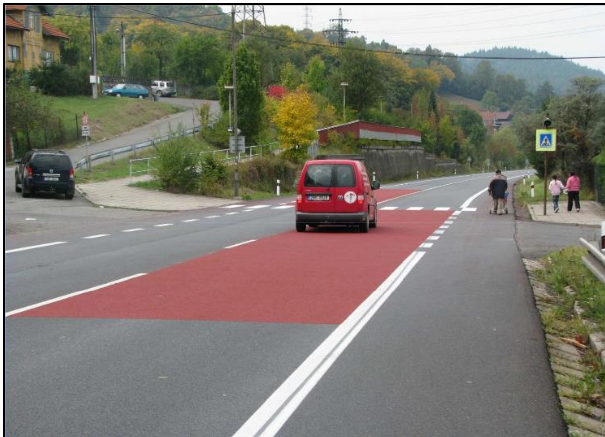
Obr. 40: Bezpečnostní protismyková úprava povrchu vozovky [9]
