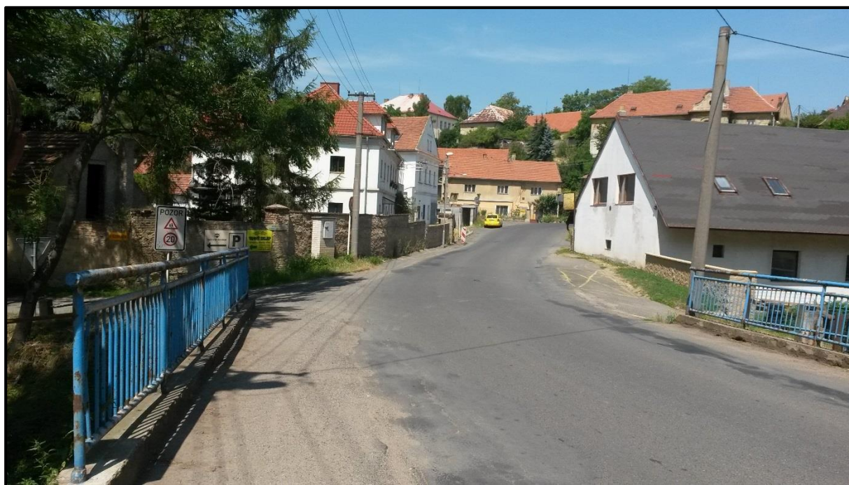
Obr. 19: Pohled přes most směrem od pivovaru
