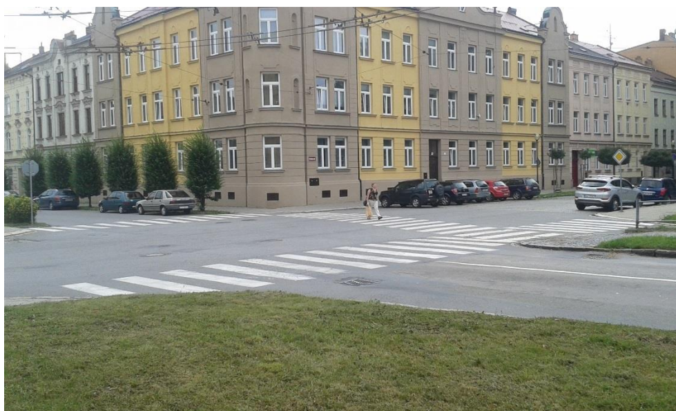
Obrázek 8: Celkový pohled na křižovatku ze severozápadu
