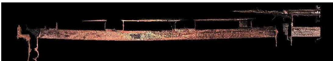
Obrázek 20: Pohled na stropní trám, bodové mračno
