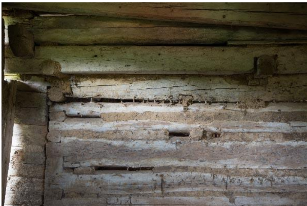
Obrázek 7: Zed' tvořená trámy s použitím výplňového materiálu, autor: J. Kmošek
