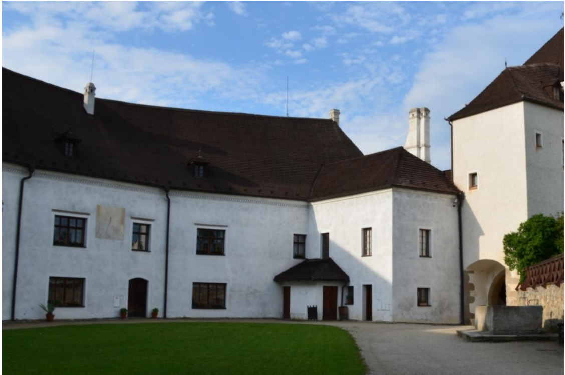
Obr. 4-3 Pohled na část nádvoří – současnost [10]
