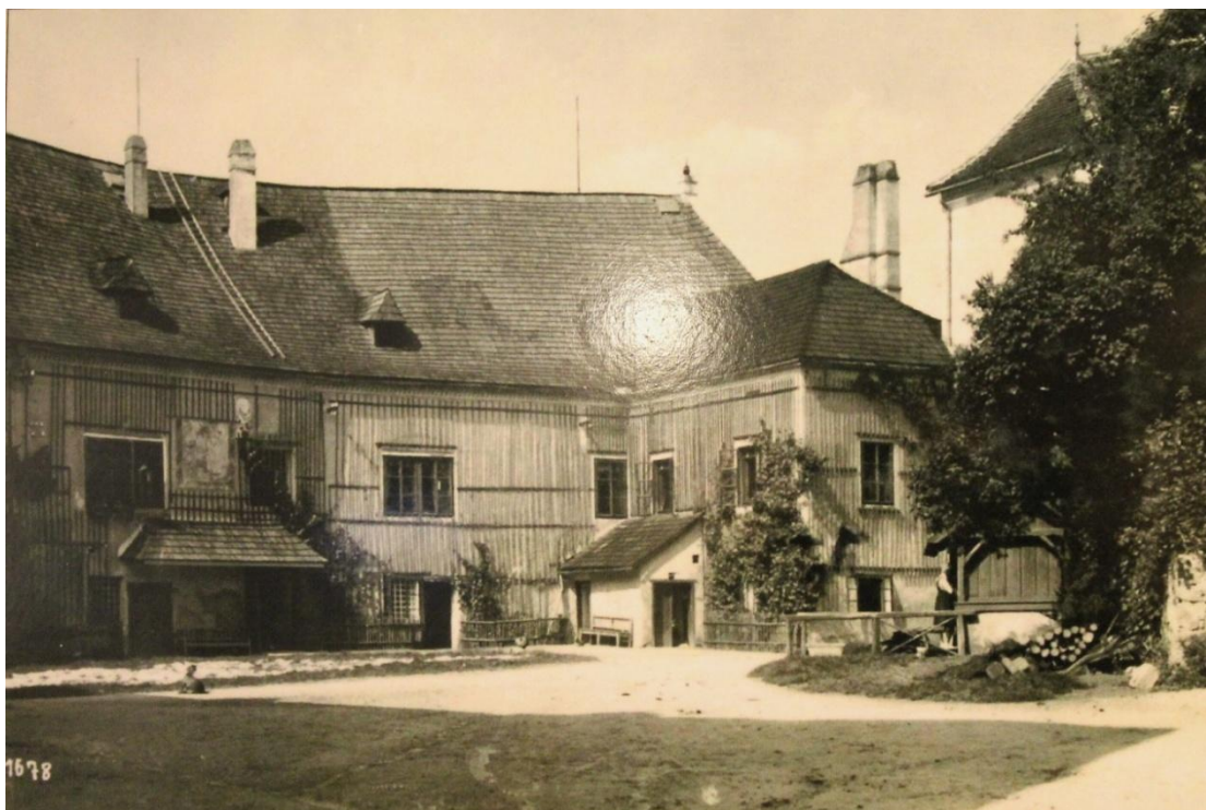
Obr. 4-1 Pohled na část nádvoří před rokem 1950 [Zdroj: fotografie vystavené na hradě]
