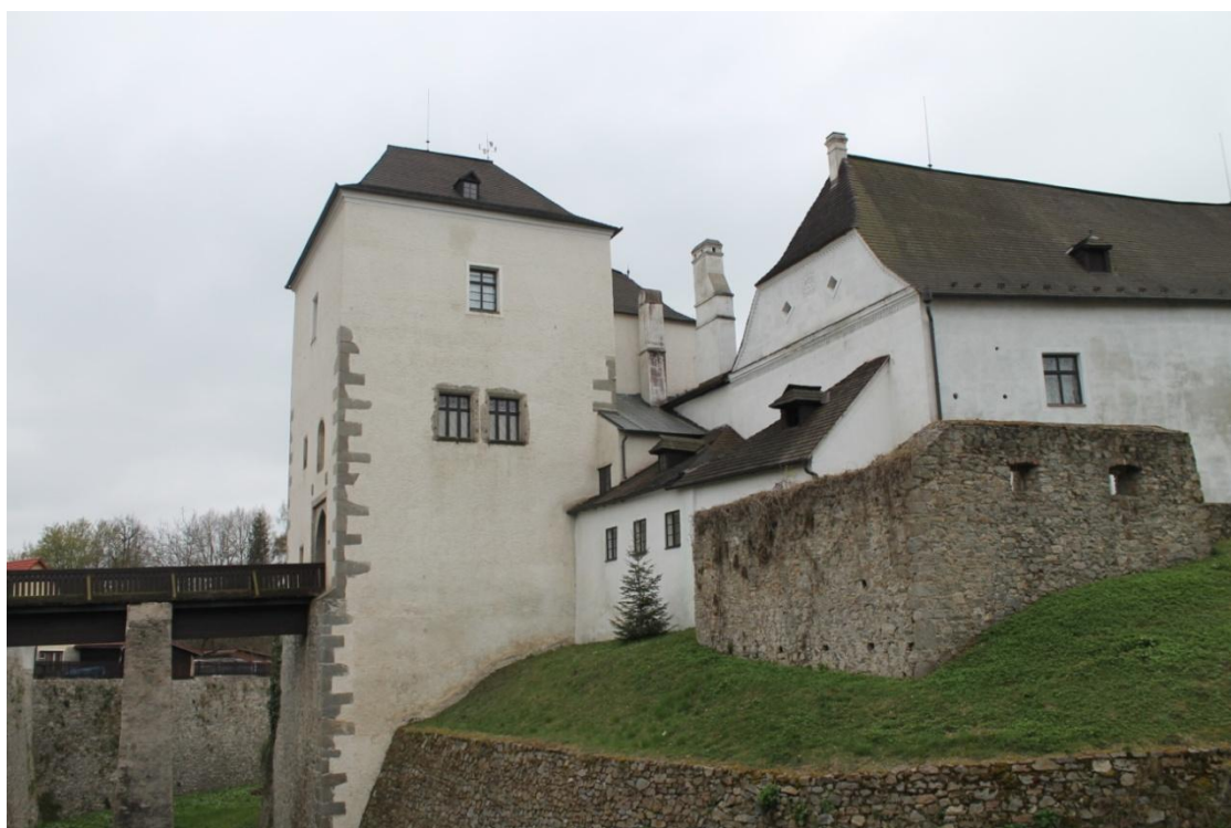
Obr. 2-2 Pohled na vstupní bránu s přílehlými budovami - současnost [Zdroj: autor]
