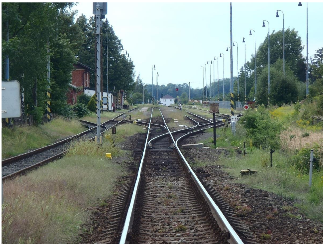
Obr. 12: Celkový pohled na kolejiště železniční stanice ve směru Frýdek-Místek
