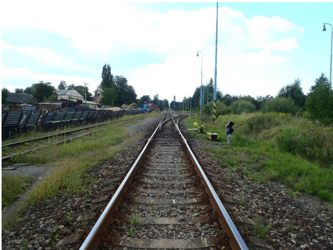
Obr. 4: Celkový pohled na vjezd do stanice ze směru Český Těšín.
