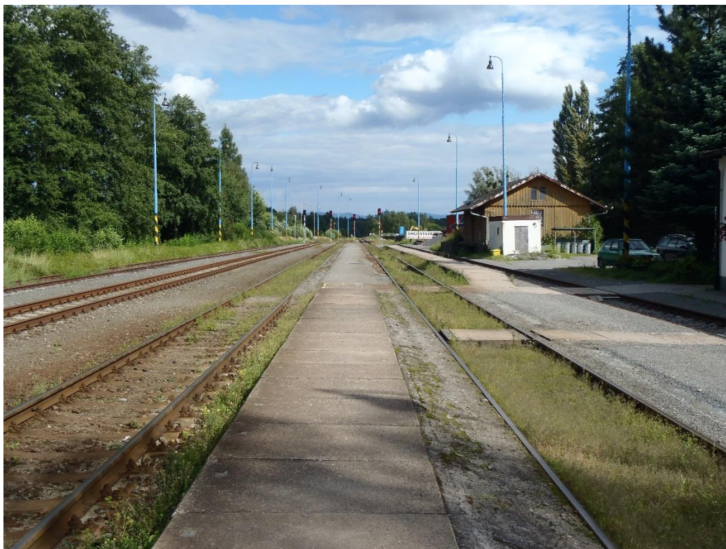
Obr. 7: Celkový pohled na obě nástupiště směrem na Český Těšín.
