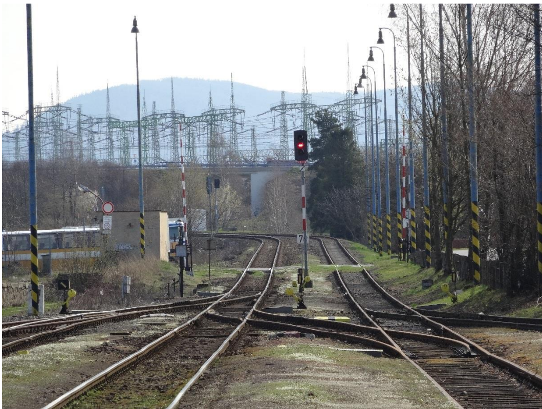
Obr. 14: Hnojnické zhlaví se staniční kolejí č. 90 vlevo a vlečku Pivovar vpravo.
