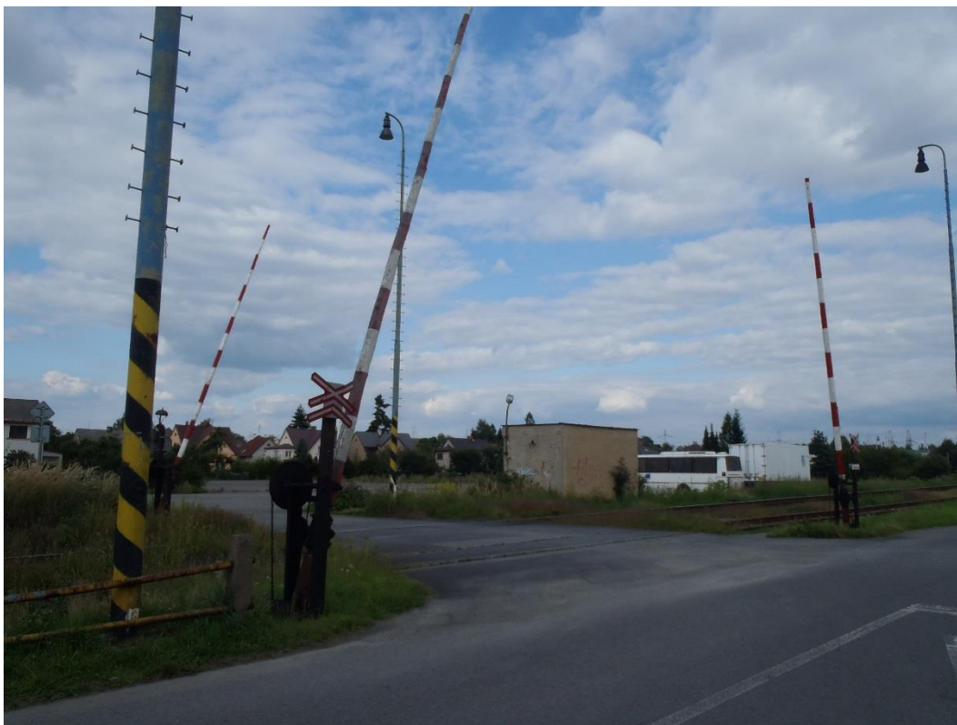
Obr. 21: Přejezd P 8308 zabezpečen mechanickými závorami obsluhovanými ze stavědla železniční stanice.
