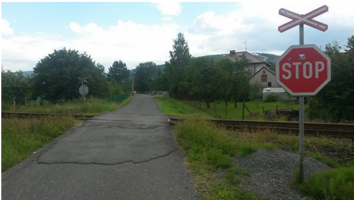
Obr. 3: Přejezd P 8326 zabezpečen výstražnými kříži bude nově vybaven světelným zabezpečovacím zařízením.
