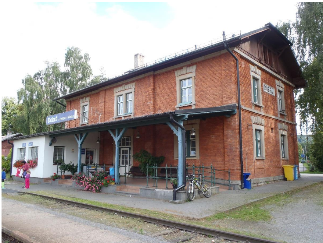
Obr. 11: Výpravní budova ŽST Dobrá u Frýdku-Místku, v popředí ústřední stavědlo.
