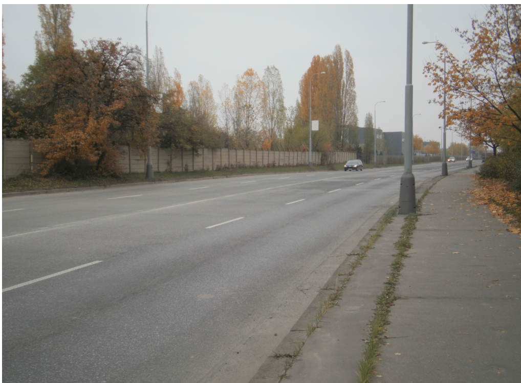
Obrázek č. 15 – Betonová zeď v severovýchodní části úseku
