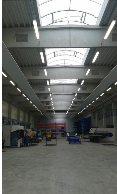
Obr. 7.2 Sálavé panely – montážní hala MEVA, Roudnice nad Labem
