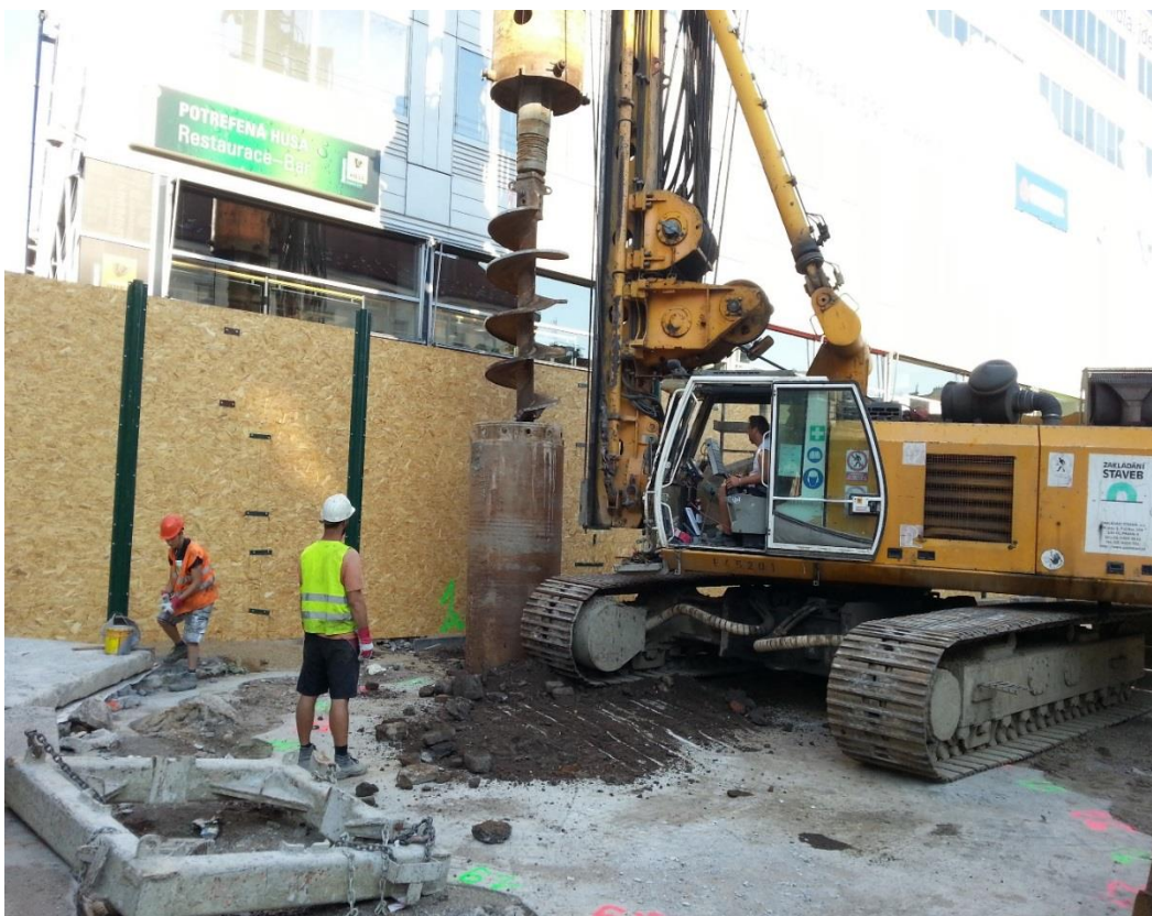
Obr. 17.: Zakládání převrtávaných pilotů (archiv autora)
