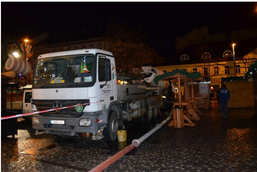
Obr. 34: Začátek trasy potrubí od betonpumpy do stanice metra (archiv autora)
