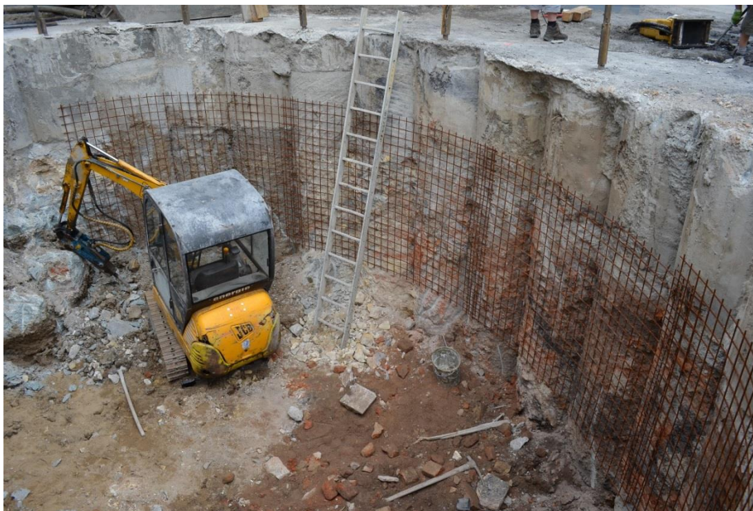
Obr. 9 Očišťování převrtávaných pilotů a pokládání kari sítí (archiv autora)
