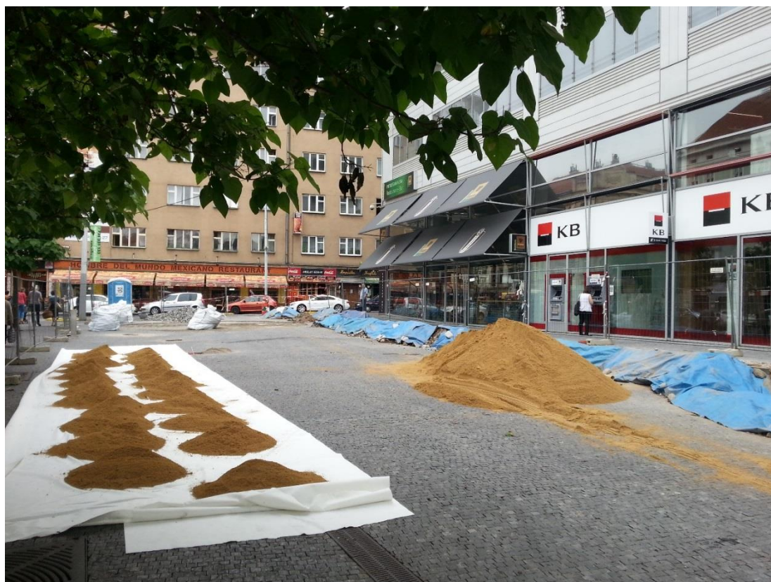
Obr. 15: Příprava syplých materiálů pro vytvoření ochranné skladby (archiv autora)
