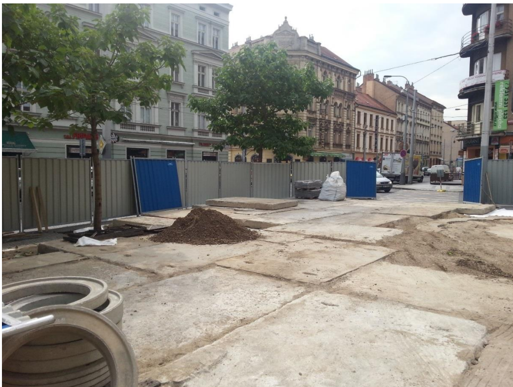
Obr. 16.: Ochrana stávající dlažby silničními panely (archiv autora)
