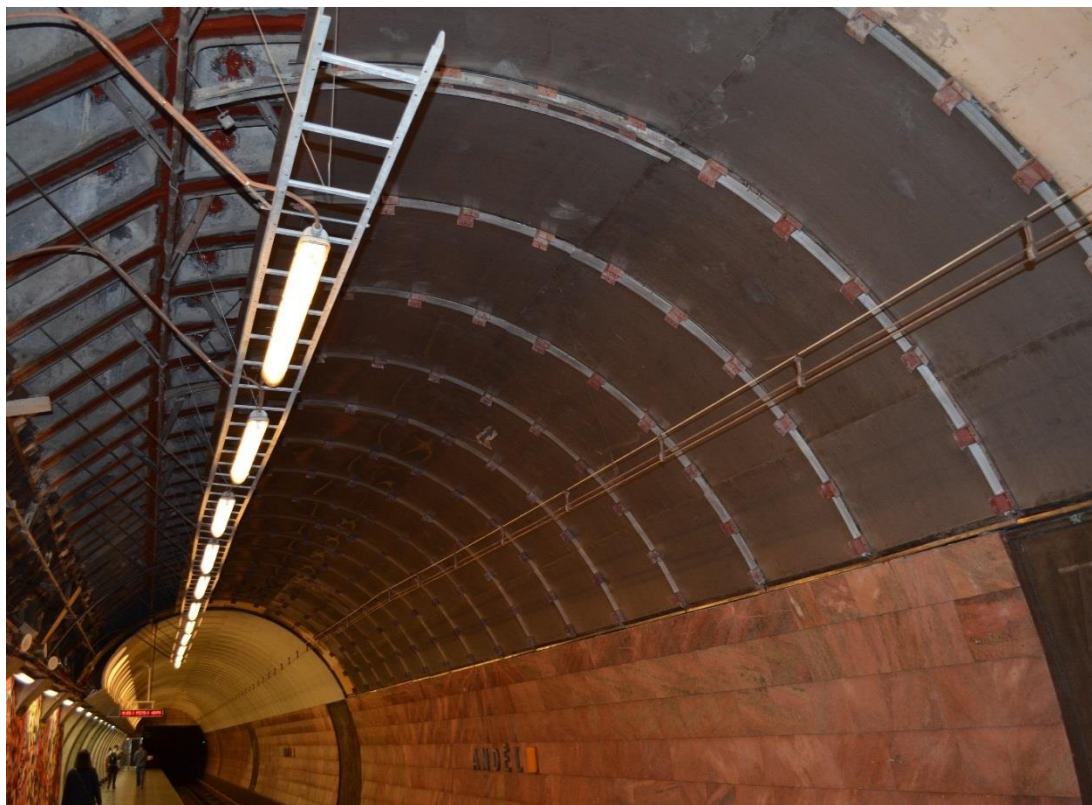
Obr. 40: Systém zontů v kolejišti ve stanici Anděl (archiv autora)
