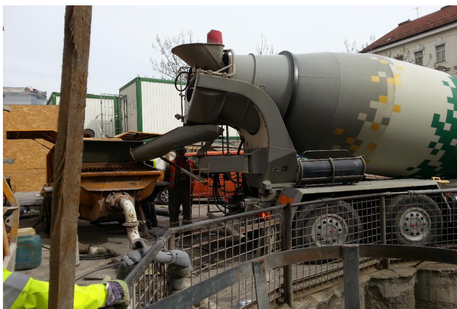
Obr. 31: Betonáž sekundárního ostění přestupní chodby (archiv autora)
