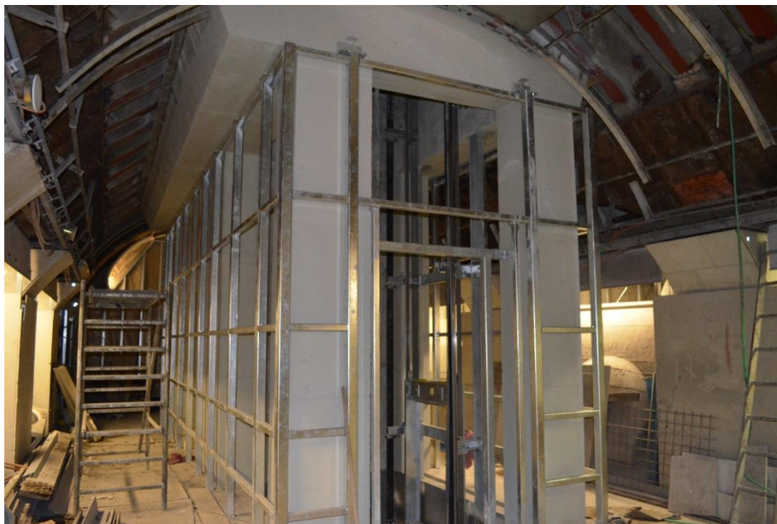
Obr. 42: Kiosek výtahu na úrovni nástupiště (archiv autora)
