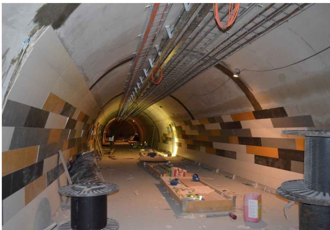
Obr. 32: Tenkostěnné obklady lepené pružným lepidlem na definitivní ostění stanice (archív autora)
