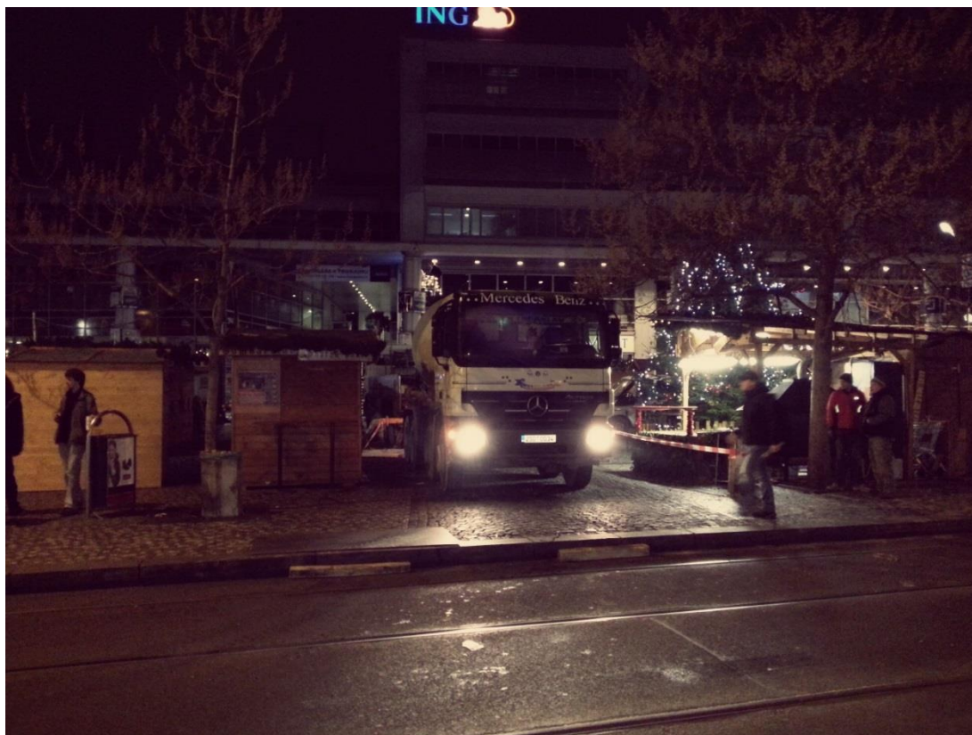
Obr. 33: Betonáž ze severního vestibulu (archiv autora)
