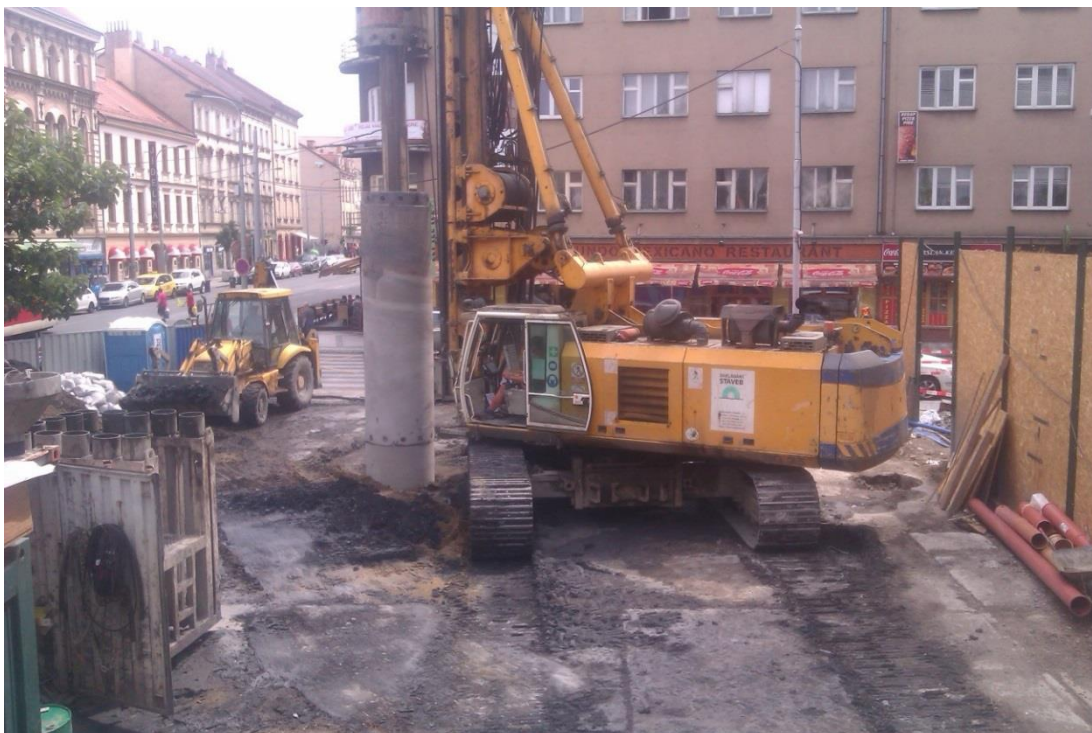
Obr. 19: Zařízení staveniště při zemních pracích (archiv autora)
