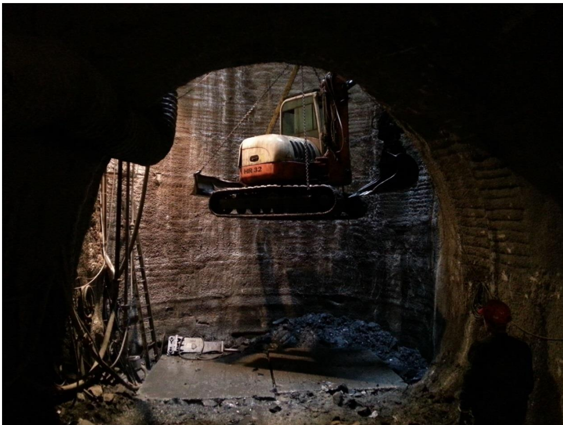
Obr. 39: Spouštění minibagru jeřábem RDK 300 do ražené přestupní chodby (vyfoceno autorem)
