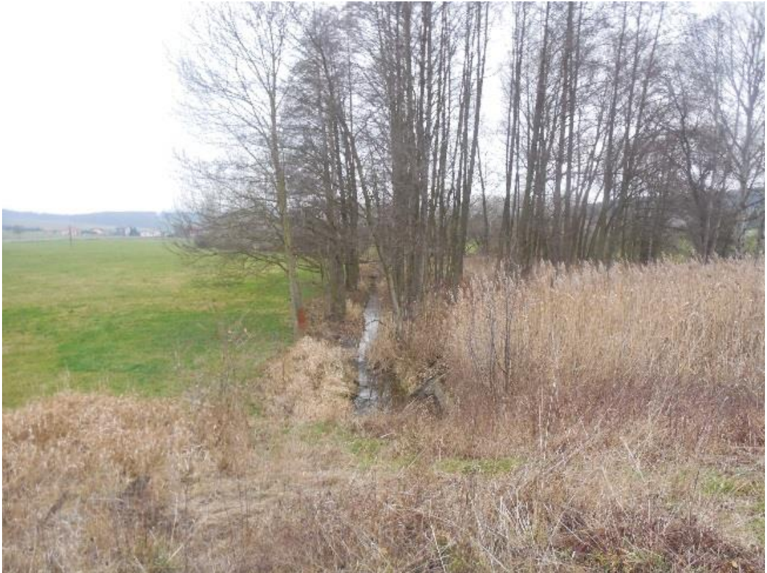
Obr. 14 – Zarostlé koryto pod výtokem ze spodní výpusti
