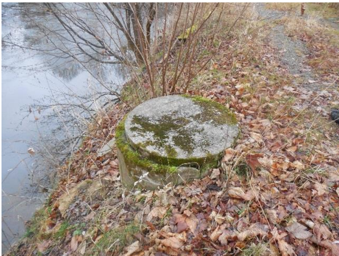
Obr. 3 – Vstup do spodní výpusti na koruně hráze
