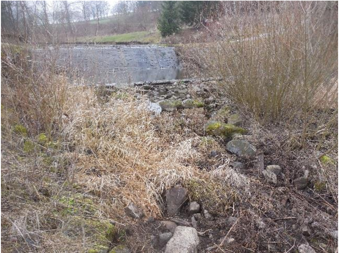
Obr. 18 – Bezpečnostní přeliv – pohled proti nádrži
