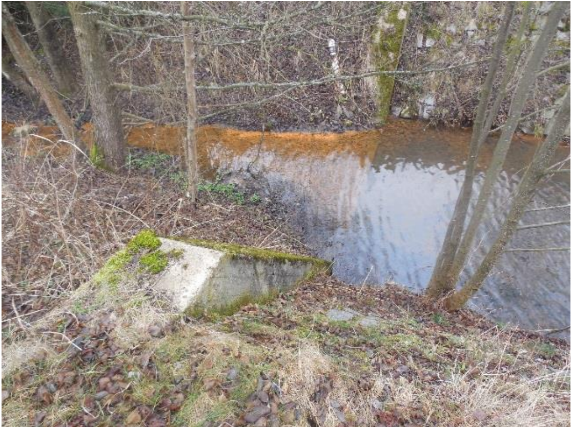
Obr. 22 – Zarostlé koryto pod výtokem z objektů
