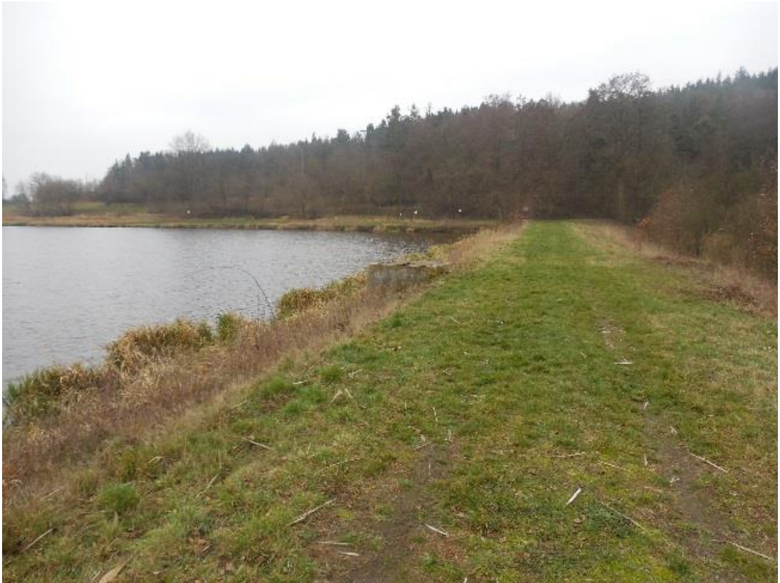
Obr. 16 – Pohled na hráz
