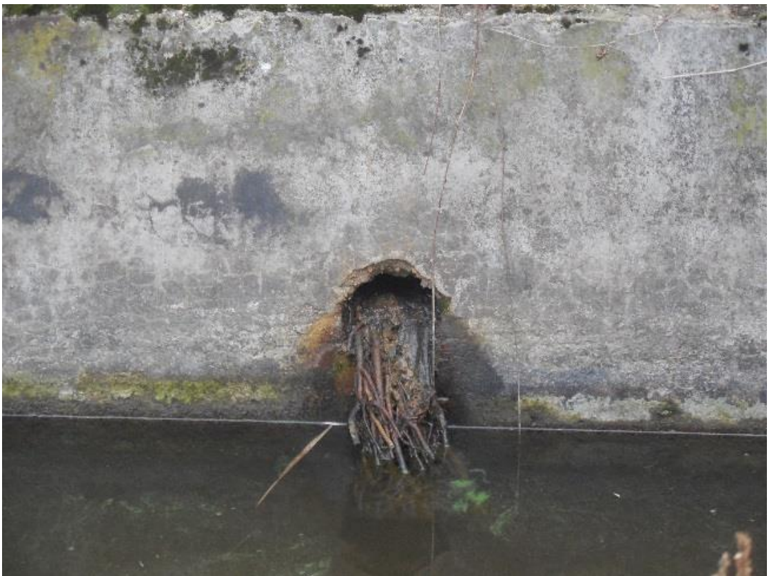
Obr. 13 – Zanesený výtok z patního drénu
