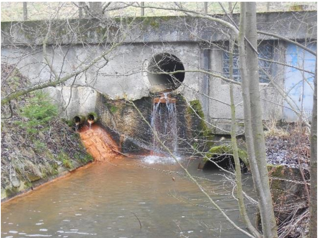
Obr. 23 – Výtok z objektů výpusti a patních drénů
