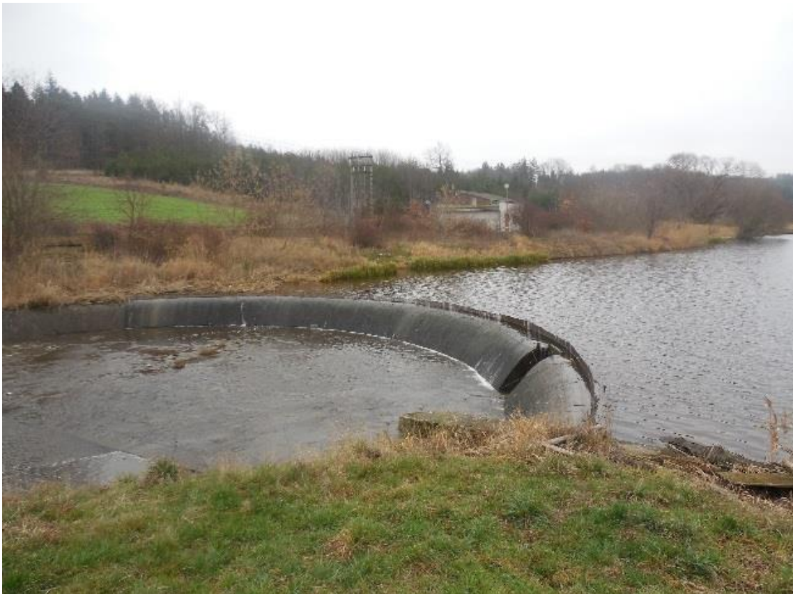
Obr. 9 – Bezpečnostní přeliv
