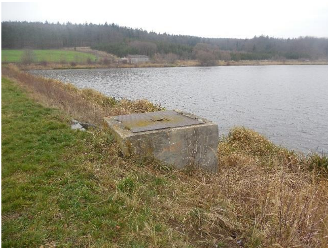
Obr. 10 – Spodní výpust
