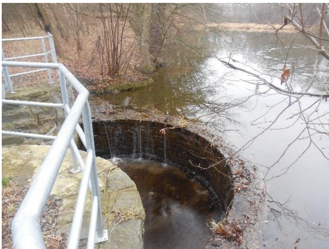
Obr. 2 – Bezpečnostní přeliv
