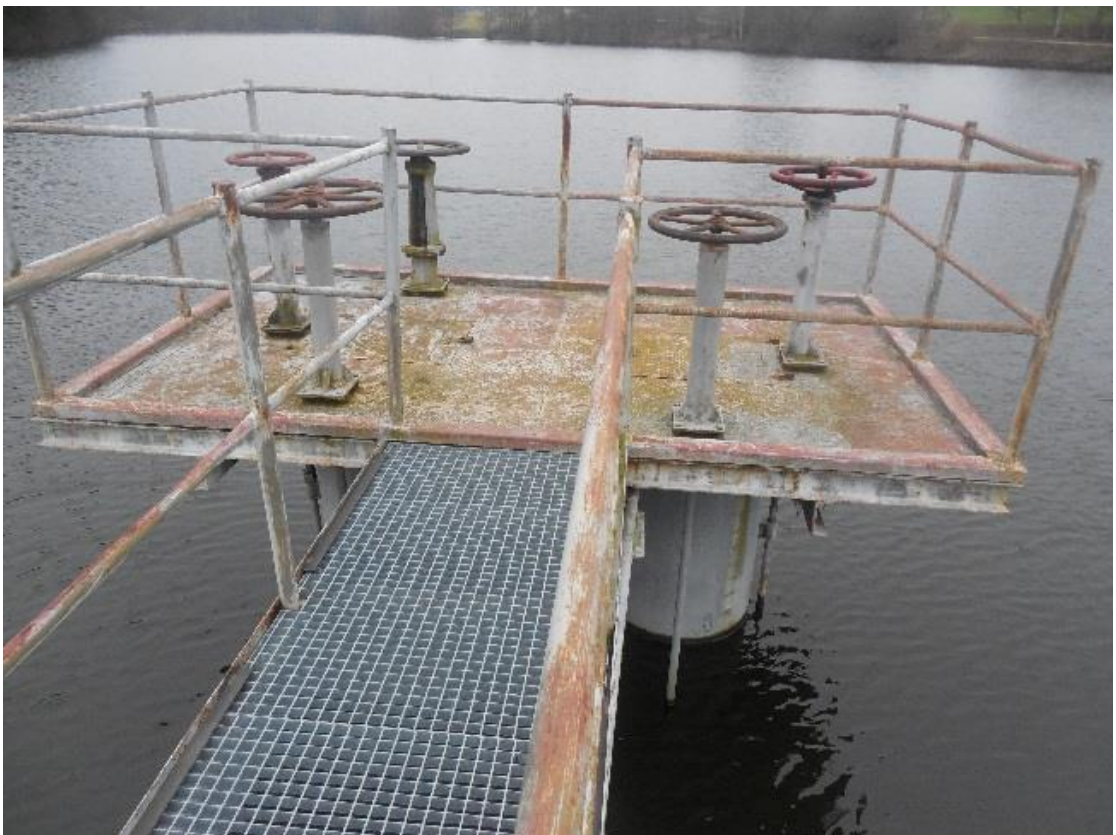
Obr. 19 – Ovládací plošina spodní výpusti a nátoku na MVE
