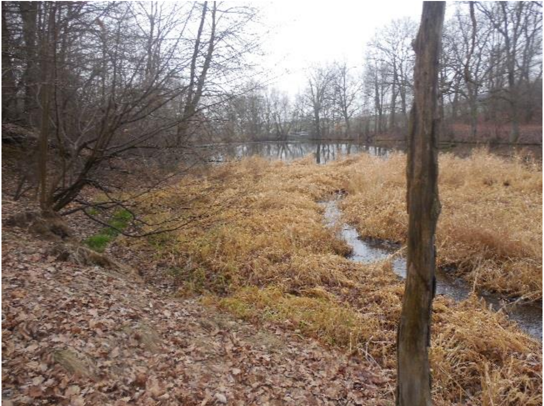
Obr. 7 – Zanesená část nádrže (pohled směrem ke hrázi)
