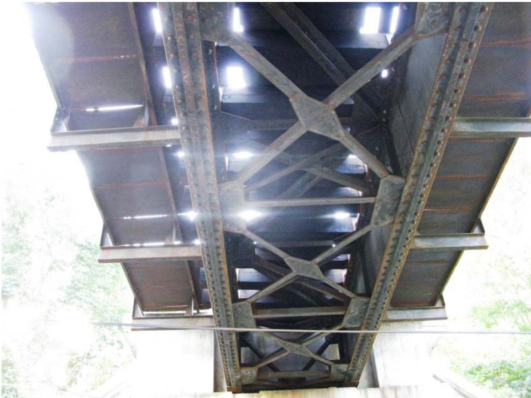
Obr.4 Pohled na ztužení a hlavní nosníky
